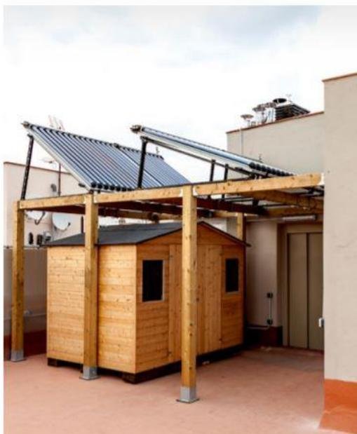
F76: sistema centralizado de ACS y calefacción mediante placas solares.
