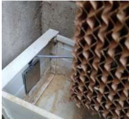
Figura 35 Colocación Sensor de Detección de Agua
