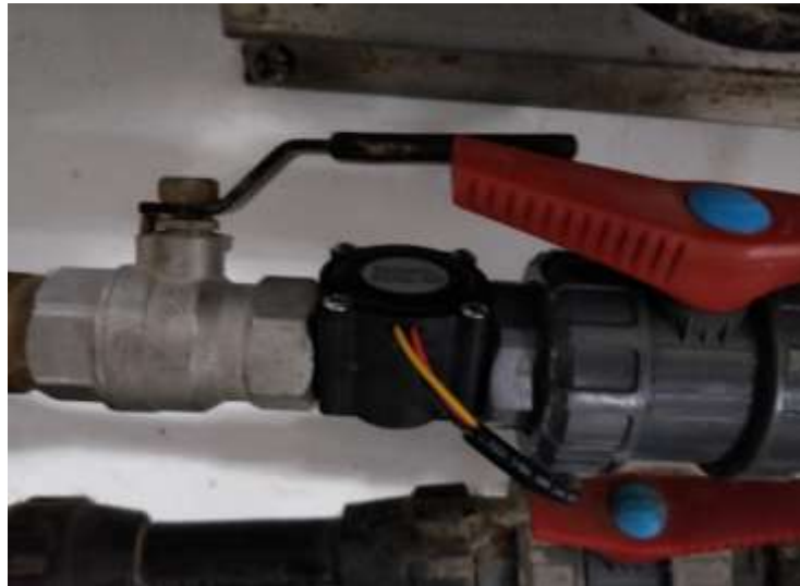
Figura 31 Colocación del sensor caudalímetro
