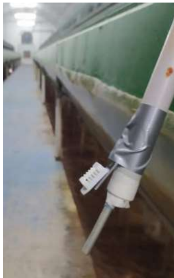
Figura 28 Colocación sensor de humedad
