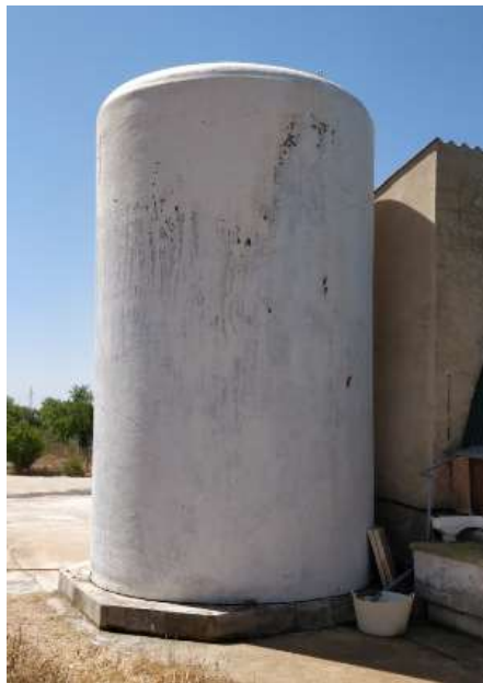
Figura 38 Depósito de agua
