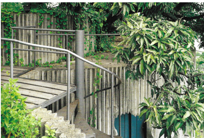
Figura 4.83 Elementos de hormigón prefabricado en escaleras y paredes exteriores. Fuente: Editorial Gustavo Gili (2002)
