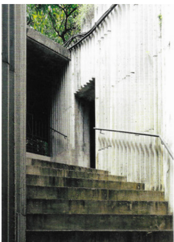
Figura 4.82 Elementos de hormigón prefabricado en escaleras y paredes exteriores Fuente: Editorial Gustavo Gili (2002)
