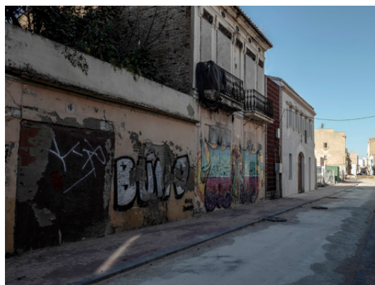
Figura 3.63 Obras Calle San Pedro terminadas con viviendas tapiadas públicas sin intervenir Fuente: Elaboración propia (Noviembre 2019)
