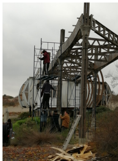
Figura 4.10 Hospedería colgante en obras. Ciudad Abierta Fuente: Fotografía propia (2019)
