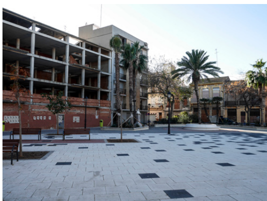
Figura 3.62 Obras Plaça del Rosari terminadas con edificio en construcción abandonado Fuente: Elaboración propia (Noviembre 2019)
