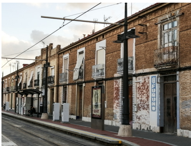
Figura 5.17 Fachada Este Lonja de la Marina Auxiliante Fuente: Elaboración propia (2020)
