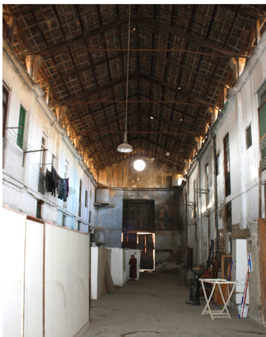
Figura 5.15 Modificaciones internas que ocupan espacio común. Fuente: Rosa Pastor (2010)
