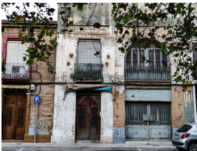
Figura 5.18 Fachada Oeste Lonja de la Marina Auxiliante Fuente: Elaboración propia (2020)
