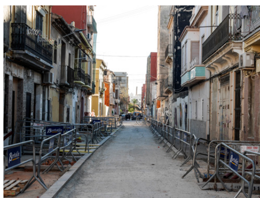
Figura 3.67 Obras en Calle Lavadero Fuente: Elaboración propia (Noviembre 2019)
