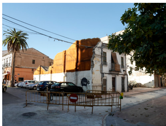
Figura 3.65 Obras Calle San Pedro terminadas con viviendas en estado de ruina Fuente: Elaboración propia (Noviembre 2019)
