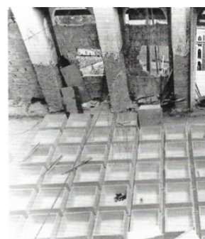
Figura 4.80 Montaje del forjado prefabricado Casa 3. Fuente: Editorial Gustavo Gili (2002)
