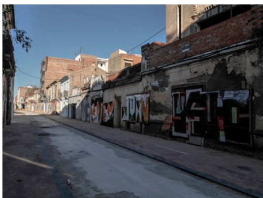
Figura 3.64 Obras Calle San Pedro terminadas con viviendas tapiadas públicas sin intervenir Fuente: Elaboración propia (Noviembre 2019)
