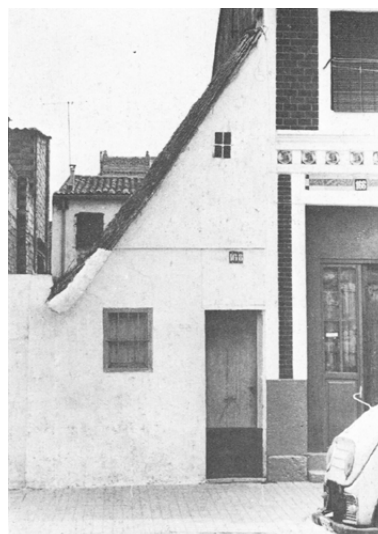
Figura 3.25 Mitad barraca y mitad edificación, El Cabanyal, finales de siglo XIX
