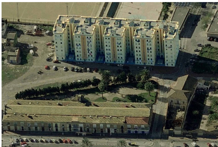
Figura 5.19 Vista de pájaro Lonja de la Marina Auxiliante y Bloques Portuarios Fuente: David Estal (2013)
