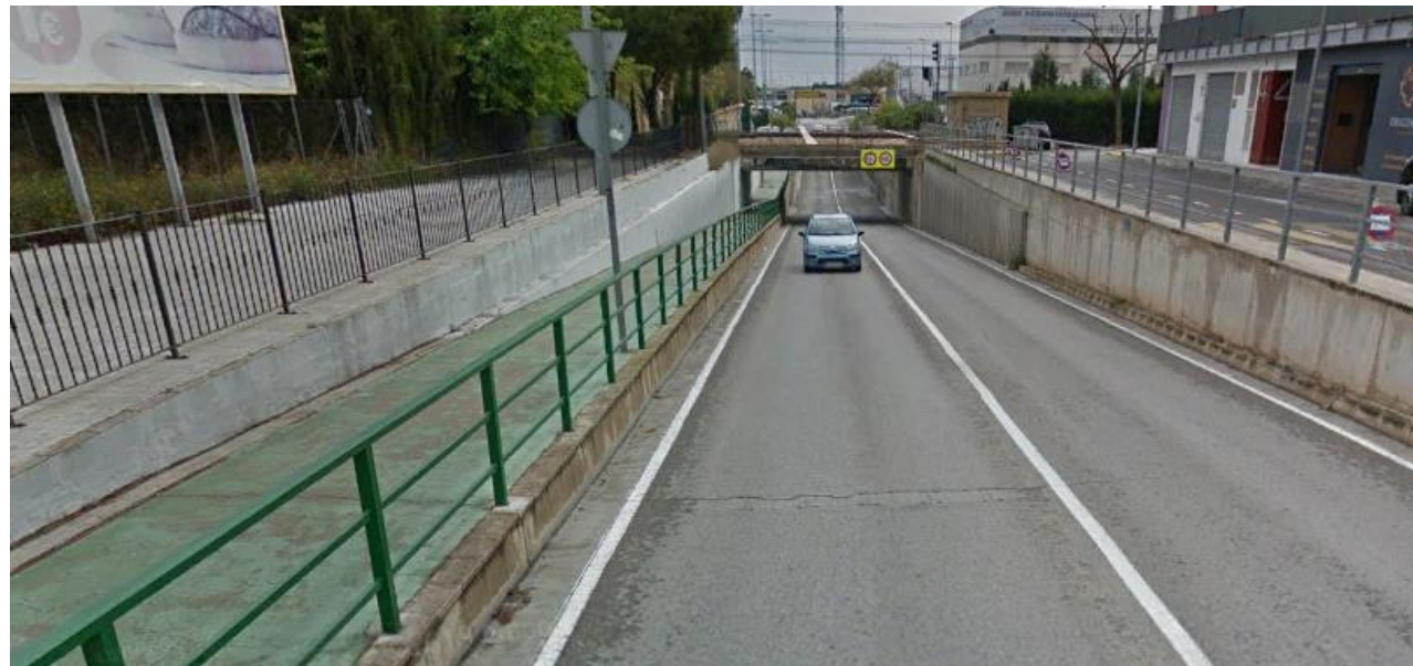
Imagen nº60. Paso inferior en Massanassa con acera ciclopeatonal a la izquierda de la imagen. Fuente: Elaboración propia
