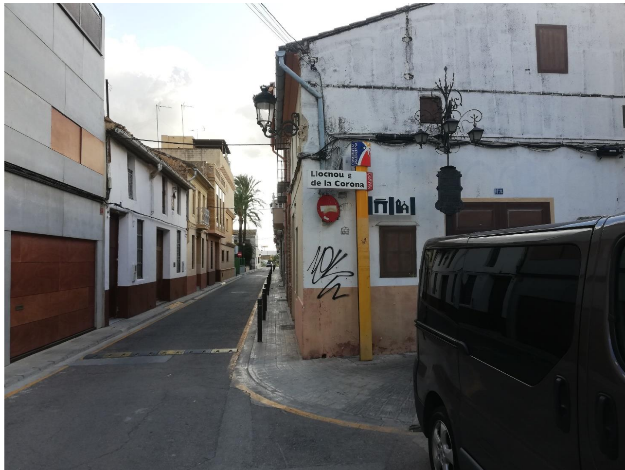
Imagen nº72. Estado pavimento en Lloc Nou Fuente: Elaboración propia
