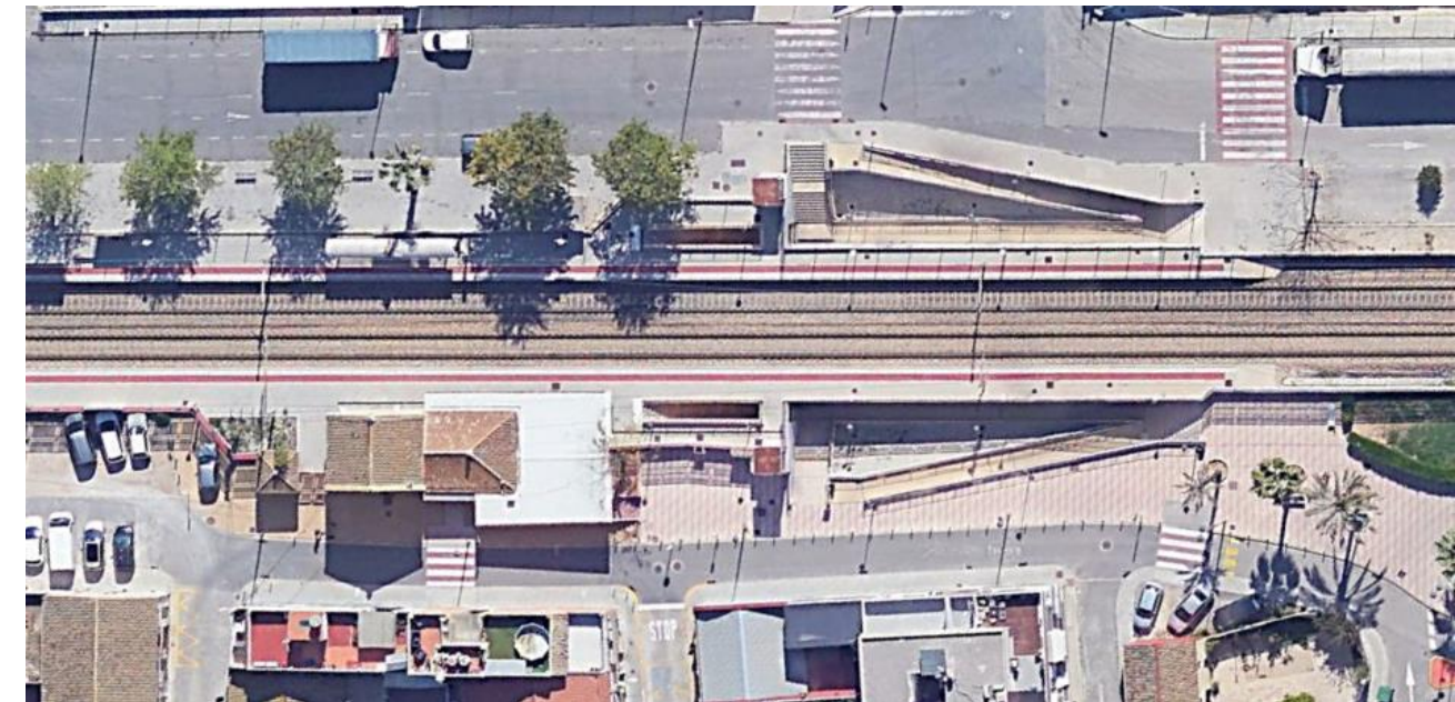
Imagen nº61. Paso inferior en Massanassa con acera ciclopeatonal a la izquierda de la imagen. Fuente: Elaboración propia
