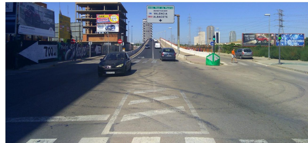
Imagen nº58. Paso elevado en Sedaví por el que discurre actualmente el trazado de la vía verde (derecha de la imagen). Fuente: Elaboración propia
