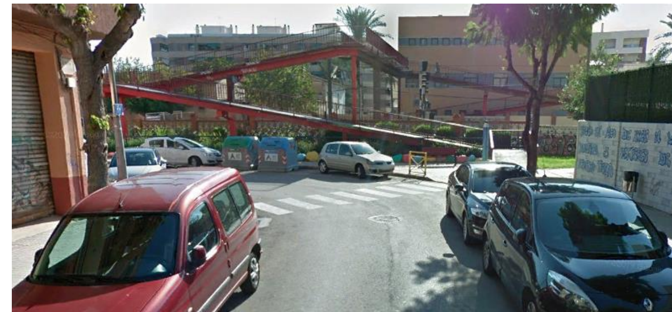
Imagen nº62. Pasarela superior en la estación de Alfafar-Benetússer. Fuente: Elaboración propia
