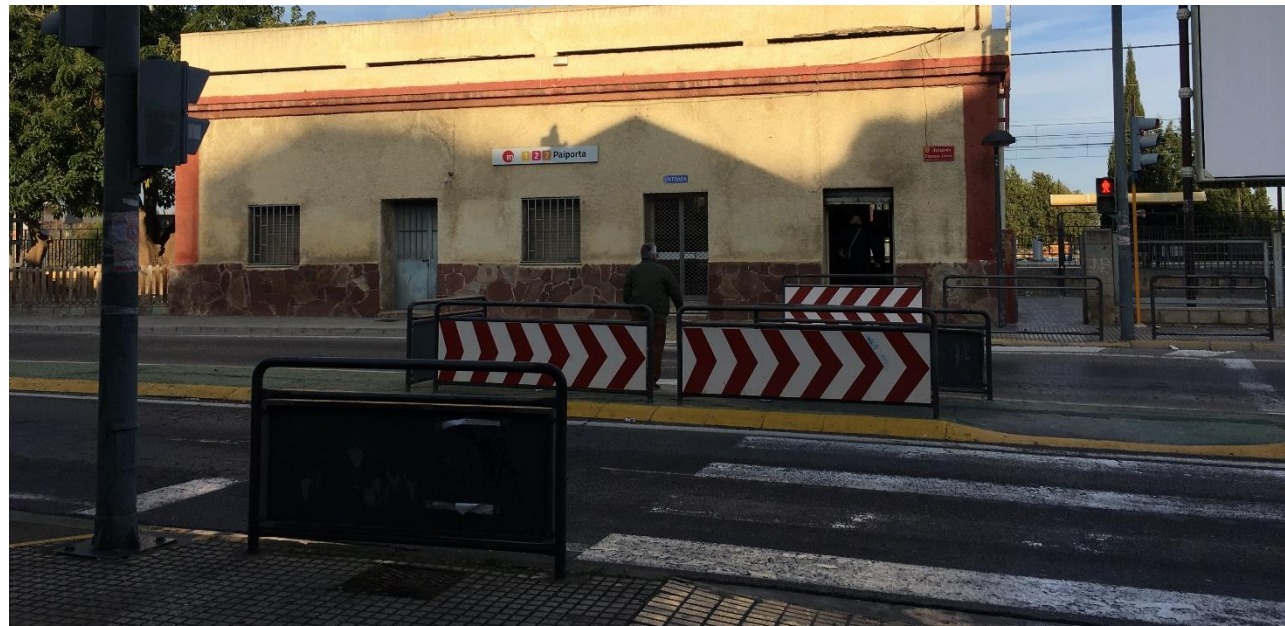
Imagen nº147. Paso peatonal en la carretera al norte de Paiporta junto estación. Fuente: Elaboración propia
