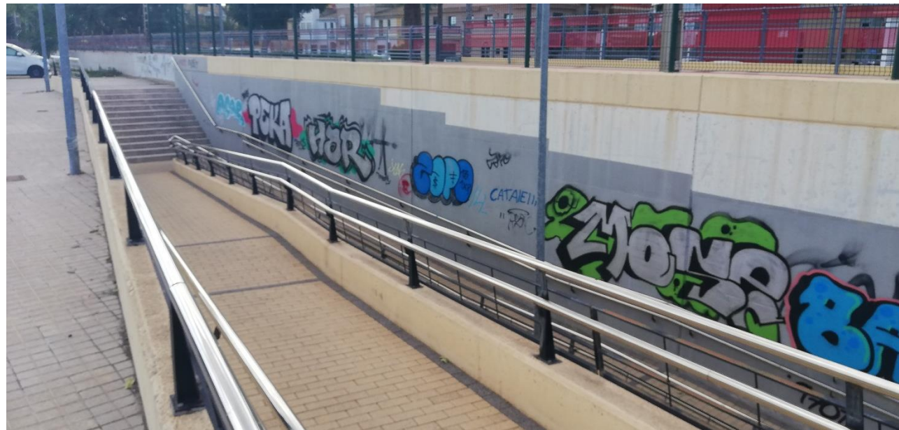
Imagen nº129. Rampa paso inferior bajo estación. Fuente: Elaboración propia
