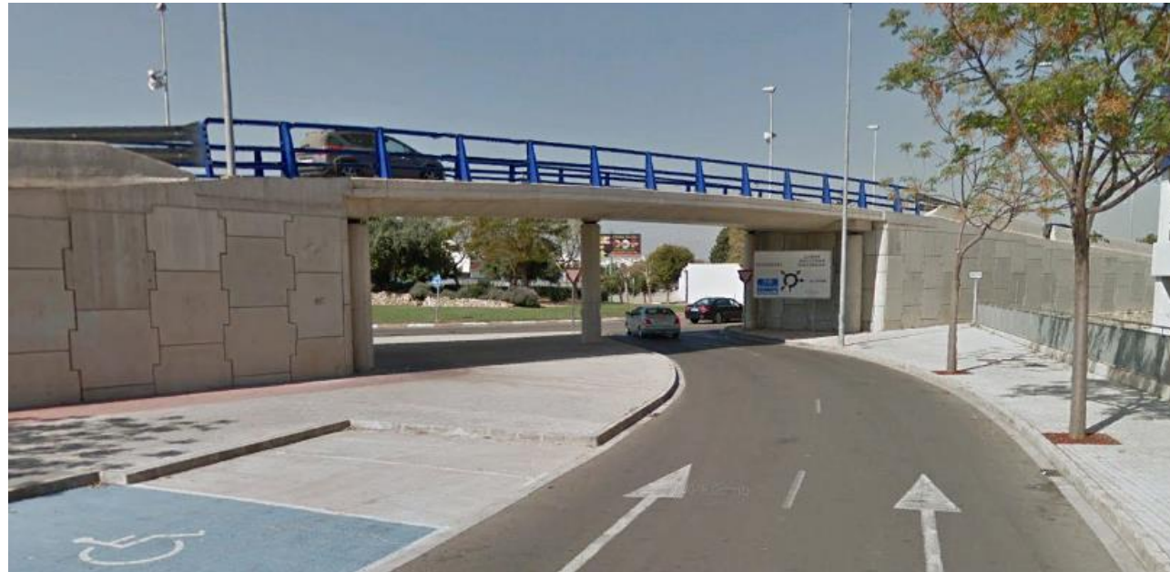
Imagen nº114. Vial sureste glorieta Ikea. Fuente: Google maps
