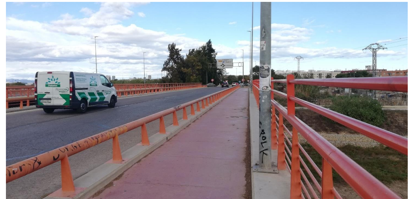
Imagen nº104. Puente sobre el Barranco de Chiva a su paso por Massanassa. Fuente: Elaboración propia
