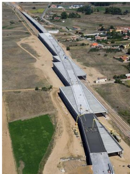
**Figura 4.** Puente pérgola de la LAV venta de Baños-León, subtramo Palanquinos - Onzonilla (León), sobre doble vía de ancho convencional Venta de Baños-Gijón (Fuente. CONSTRUBLOG, 2014).
