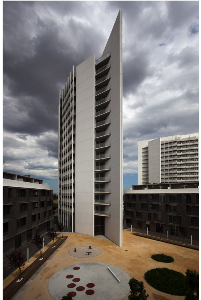
Imagen 1. 2004-2010. Viviendas VPO en el Parc Central de Torrent. Fuente: https://ferrater.com/
