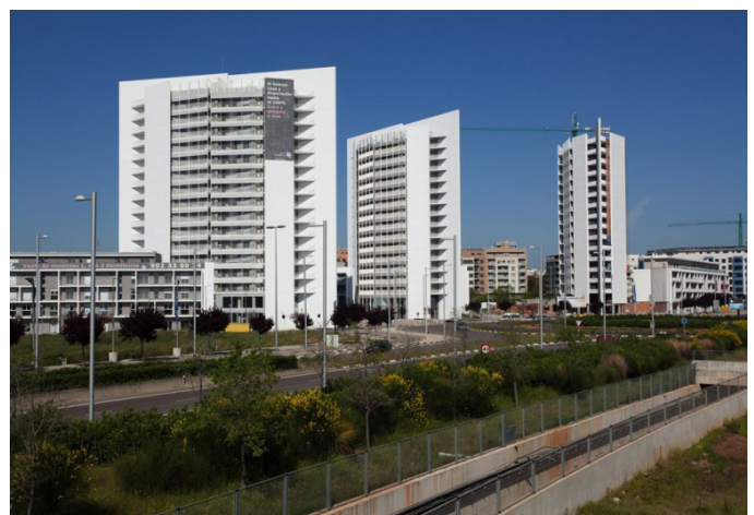
Imagen 2. 2004-2010. Viviendas VPO en el Parc Central de Torrent. Fuente: https://ferrater.com/
