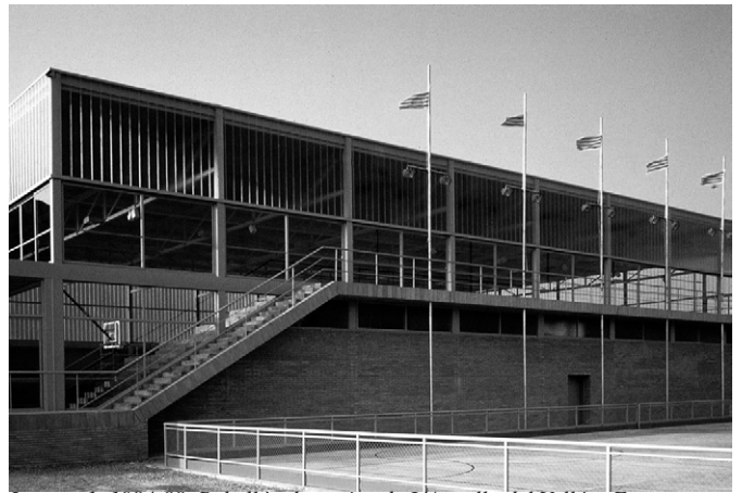
Imagen 1. 1984-88. Pabellón deportivo de L'Ametlla del Vallés. Fuente: https://ferrater.com/
