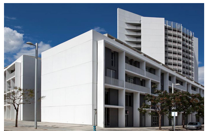
Imagen 3. 2004-2010. Viviendas VPO en el Parc Central de Torrent. Fuente: https://ferrater.com/
