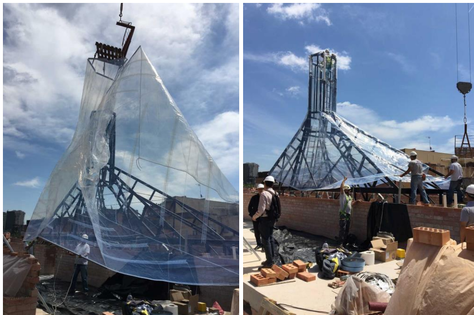
Figura 44 y 45. Chimenea solar, montaje lámina ETFE
