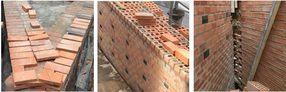
Figura 38. Proceso constructivo muro de ladrillo
