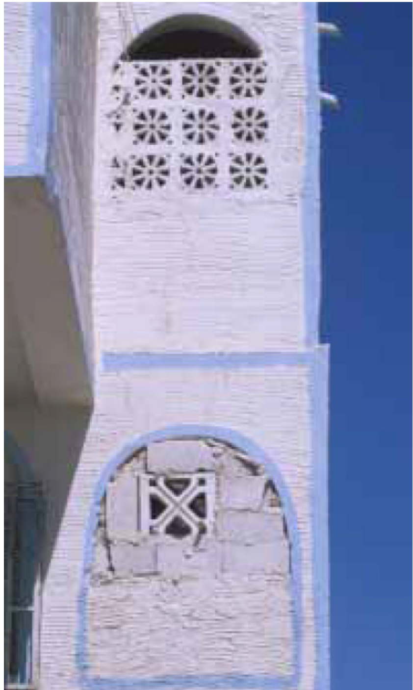
Imagen 24. Huecos con celosías [Fotografía] (Cortesía de Hany El Miniawy)
