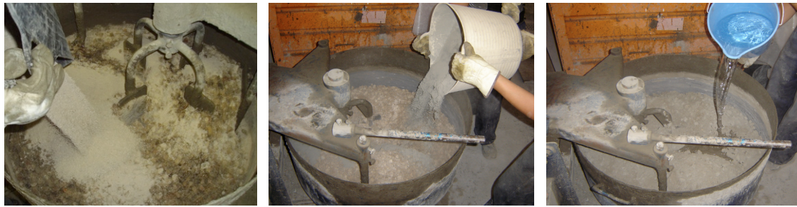
Figura 5.10. Se introducen el árido fino y cemento, se pone la hormigonera en marcha y se añade el agua reservando una pequeña cantidad de agua para mezclar con el aditivo. Se amasa durante 2 minutos.
