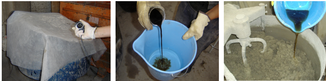
Figura 5.11. Se deja en reposo 2 minutos, se añade el aditivo disuelto en el agua restante y finalmente 2 minutos mezclando.
