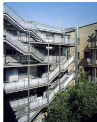
Figura 22. Escalera metálica acceso viviendas
