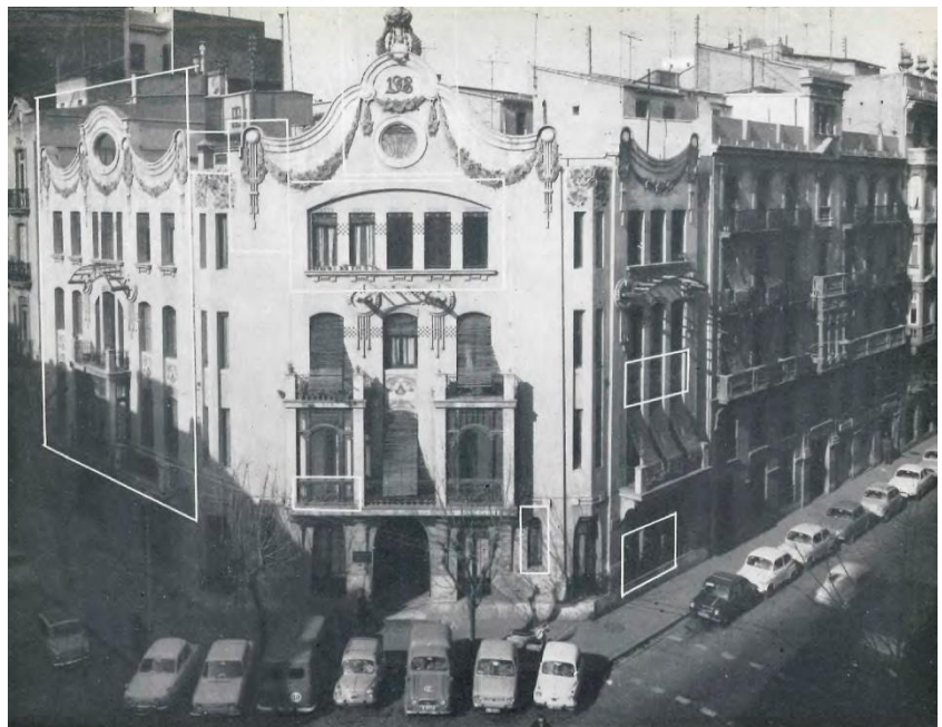
Fig. II. 4 Edificio de Vicente Ferrer en la calle Cirilo Amorós número 31 y construido en 1908 que constituye uno de los ejemplos más claro de la fusión entre la Escuela de Viena y la Escuela de Glasgow.
