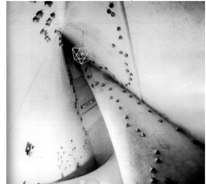
9. Espacio interior del Pabellón Philips
