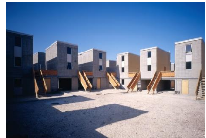
99. Imagen exterior de las viviendas al finalizar la obra
