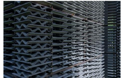
65. Pabellón Serpentine Gallery 2018, diseñado por Frida Escobedo. Este construido con tejas de hormigón, típicas de la arquitectura mexicana. Que aportan rotundidad al espacio y una experiencia táctil de forma visual.
