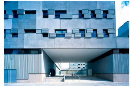
95. Acceso al bloque de viviendas de Carabanchel, Aranguren y Gallegos
