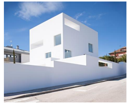
117. Zona exterior de acceso a la vivienda
