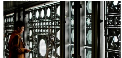
69. Instituto del mundo árabe, Jean Nouvel, en París. Se incorpora en la fachada unos novedosos módulos que se expanden o se contraen produciendo la entrada de luz y el control de temperatura
