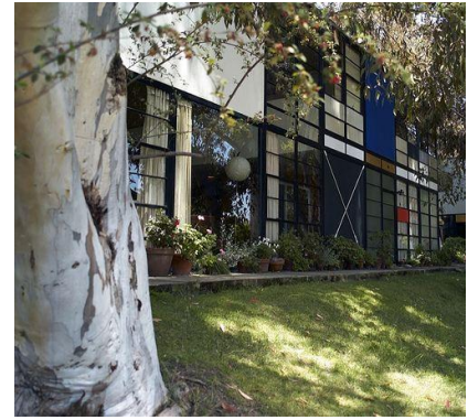
31. Zona de acceso a la vivienda
