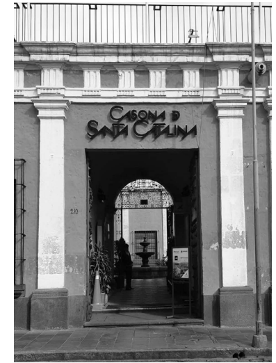
Ilustración nro 187: Acceso, Restaurante Chicha Fuente: Foto propia 2021
