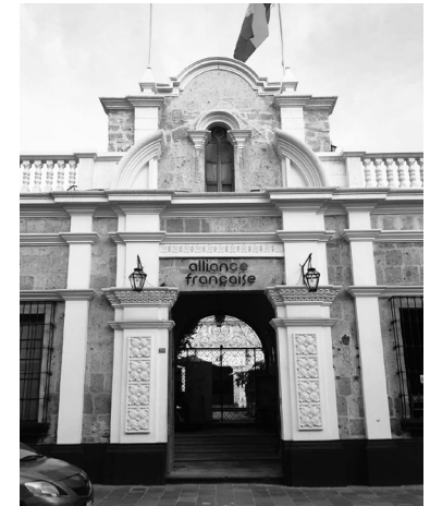
Ilustración nro 174: Acceso, C.I. Alianza Francesa Fuente: Foto propia 2021
