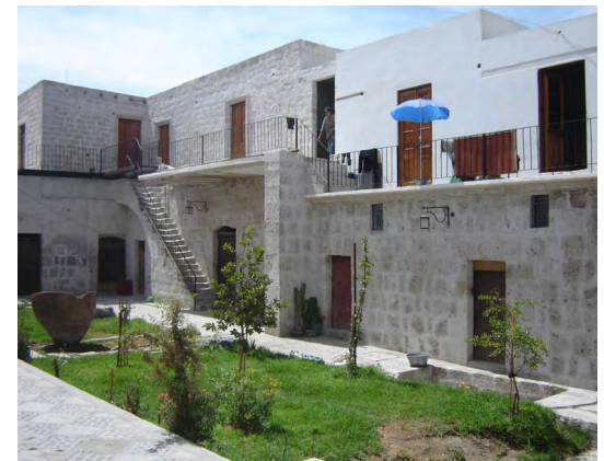
Ilustración nro 68: Patio del Tambo de la Cabezona, Arequipa, después de la intervención
