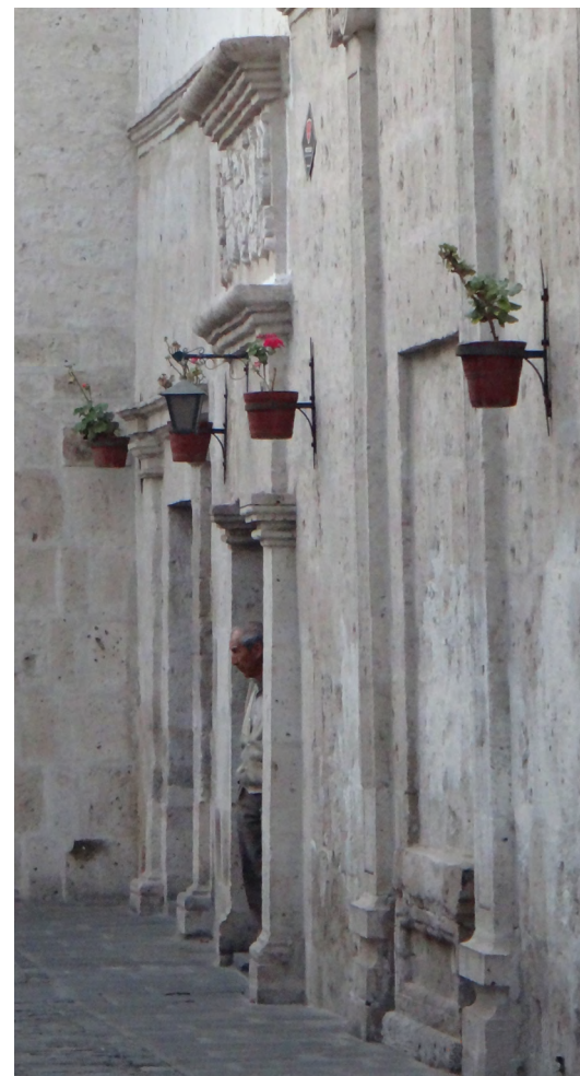
Ilustración nro 79: Fachada de sillar, centro historico de Arequipa.
