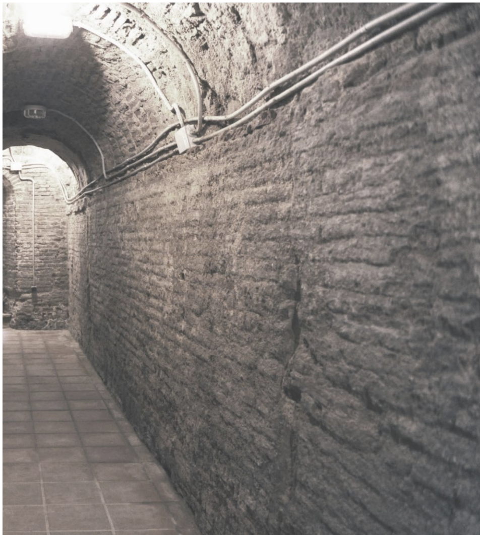
Fig. 22 | Interior de la antigua alcantarilla de la Cava Baja de San Francisco, en el antiguo palacio de los Marqueses de Villafranca. Autor desconocido 2015. Real Academia de Ingeniería.
