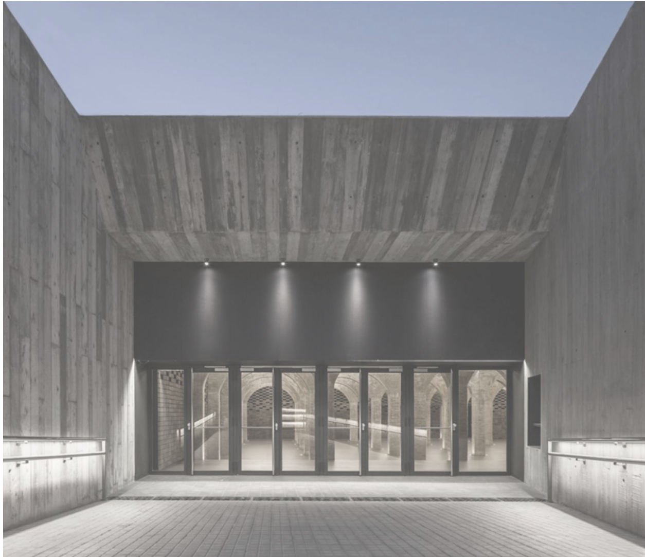
Fig. 4 | Aspecto actual del hall de entrada del depósito Rei Martí (Barcelona), recientemente rehabilitado. Fuente: www.arquitecturacatalana.cat
