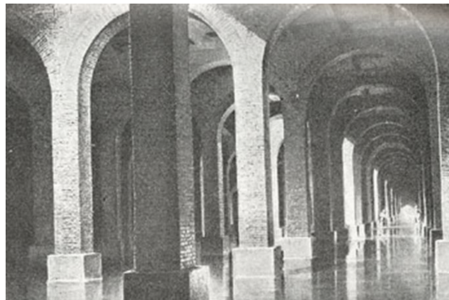
Fig. 28 | Fotografía de archivo del interior del depósito, 1898. Archivo general de Canal de Isabel II.
