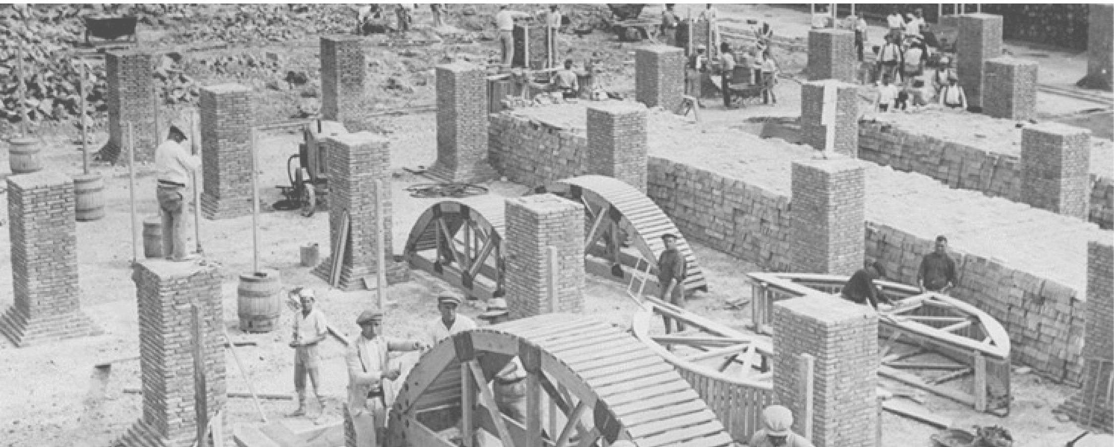
Fig. 19 | Fotografía de la construcción del depósito de Mislata (1849-50). Anónimo. Museo de Historia de Valencia. 13
