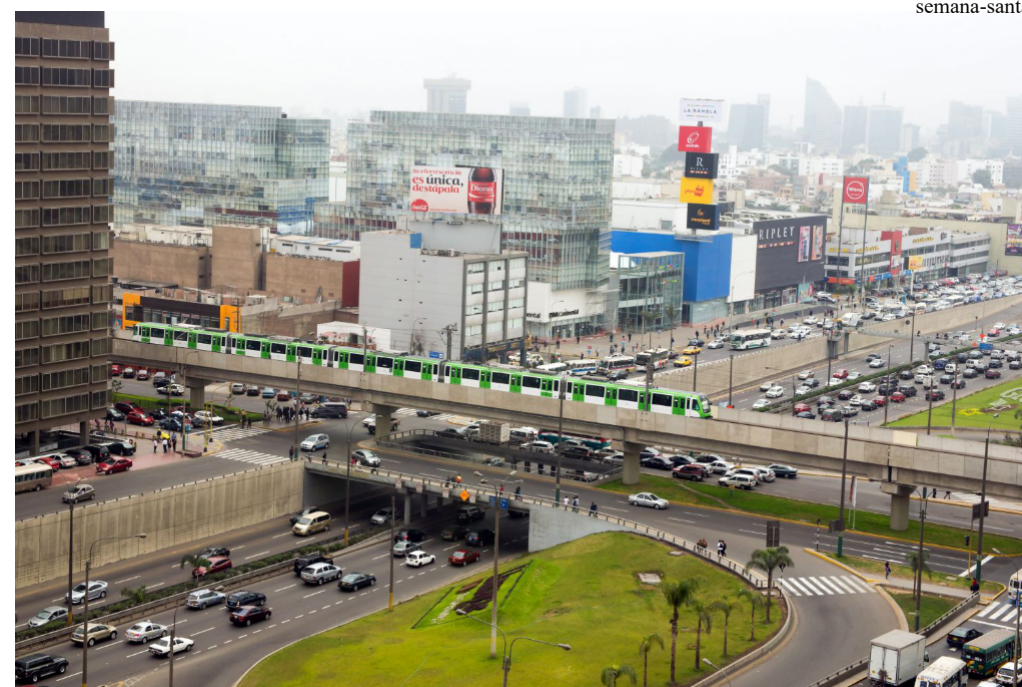
Figura 195. Línea 1 del metro en Av. Javier Prado 2015
