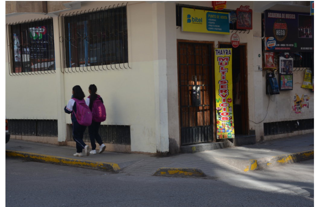
Figura 146. Rampas colocadas sin criterio técnico (Cusco - Perú, 2019) Fotografía: Zulema Conto
