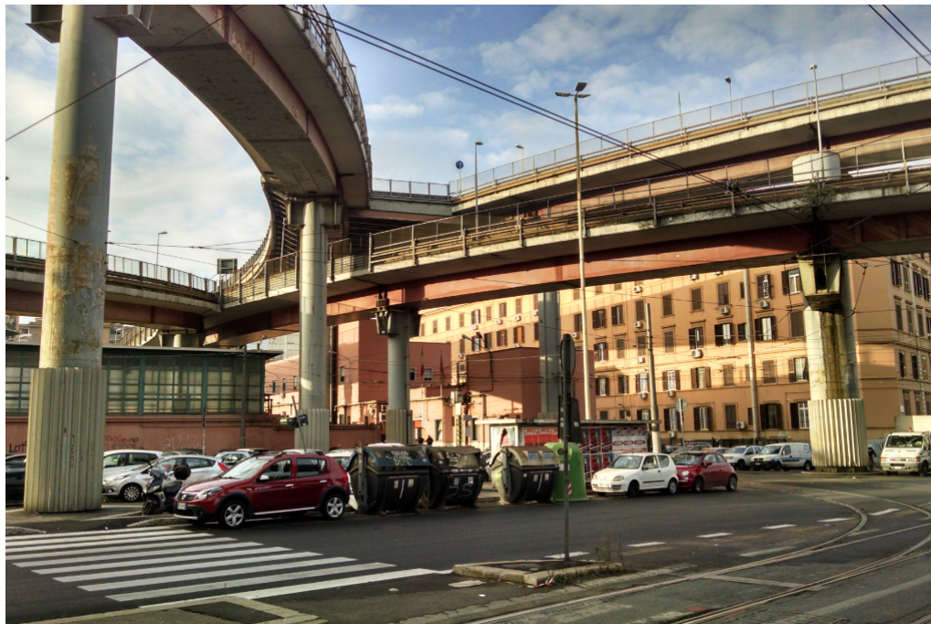
Figura 2. Transporte - infraestructura de transporte Fotografía: Zulema Conto (Roma, 2016)
