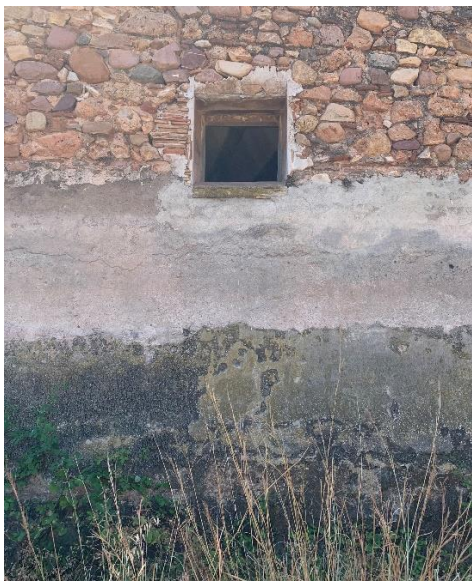
[Fig. 127] Detall de la humitat per capil·laritat en el mur. Font: Elaboració pròpia. Betxí. 2020.
