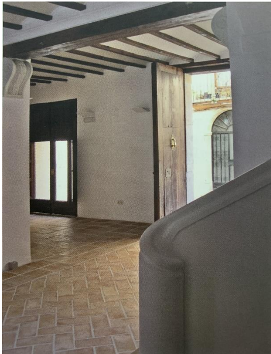
[Fig. 4] Casa decimonònica a Oliva. Es pot observar l'espai definit per una crugia, amb murs de càrrega paral·lels a la façana i bigam entre murs, dins del sistema tradicional valencià. "Arquitectura Rural Valenciana". Font: Miguel Del Rey i Aynat. Girona. (2011)
