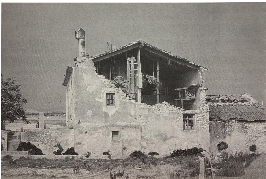
[Fig. 55] Vistes d'un antic molí en ruïnes en Almussafes. La Ribera. La imatge de l'edifici no evidència l'ús al que està destinat, i la seua construcció és idèntica a la de qualsevol casa de dos crugies amb carener sobre la línia central de càrrega. Es pot observar com la idea de construcció d'espai està per damunt de la condició d'ús en les arquitectures de les societats vernacules. L'adequació al medi vindrà donada per l'elecció dels materials i l'ajust particular dels distints elements de l'arquitectura. " Arquitectura Rural Valenciana: tipos de Casas dispersas y analisis de su arquitectura ". Font: Miguel Del Rey i Aynat. València. (1998)
