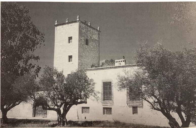
[Fig. 7] Vista de cases amb torre en el Cabo de Huertas. La Cadena i Reixes. En ambdues, la torre manté el caràcter senyorial i de defensa. "Arquitectura Rural Valenciana: tipos de Casas dispersas y analisis de su arquitectura" . Font: Miguel Del Rey i Aynat. València. (1998)
