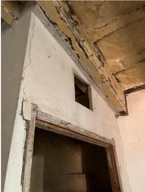
[Fig. 144] Detall d'alteració cromàtica en la fusteria de la porta. Font: Elaboració pròpia. Betxí. 2020.
