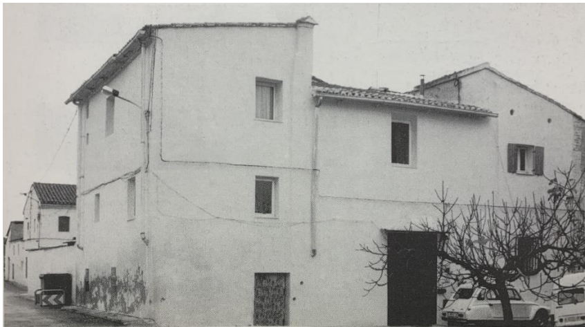
[Fig. 37] Alqueria del Rei en el Camí del Pouet, s. XVI. València. “Arquitectura Rural Valenciana: tipos de Casas dispersas y analisis de su arquitectura” . Font: Miguel Del Rey i Aynat. València. (1998)
