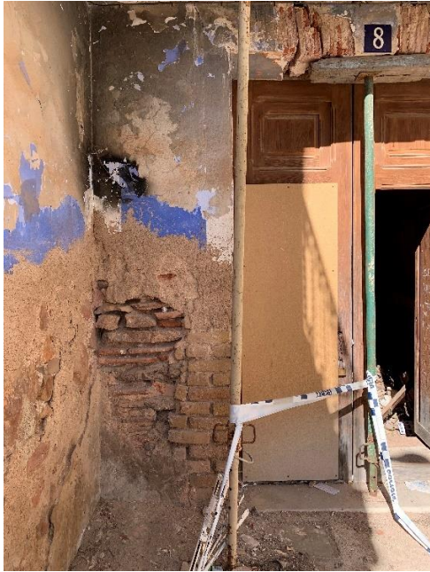
[Fig. 105] Detall de mur de maçoneria en la façana principal. Font: Elaboració pròpia. 2020.
