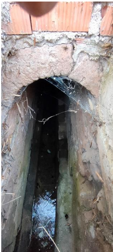
[Fig. 75] La galeria de la séquia. Coberta amb arc. Font: Elaboració pròpia.
