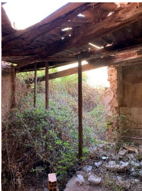
[Fig. 87] Zona de la caiguda de la bomba. Font: Elaboració pròpia.
