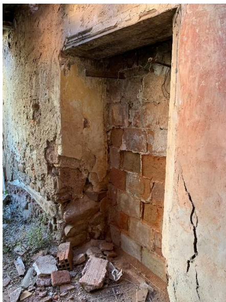
[Fig. 122] Es pot observar a la part esquerra la falta de material en el mur a causa de l'erosió. Betxí. Font: Elaboració pròpia. 2020.
