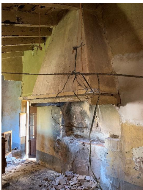
[Fig. 136] Falta de material de coberta facilitant l'entrada d'aigua. Font: Elaboració pròpia. Betxí. 2020.
