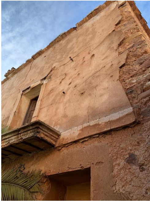
[Fig. 129] Aproximació al quarterat del revestiment exterior. Font: Elaboració pròpia. Betxí. 2020.
