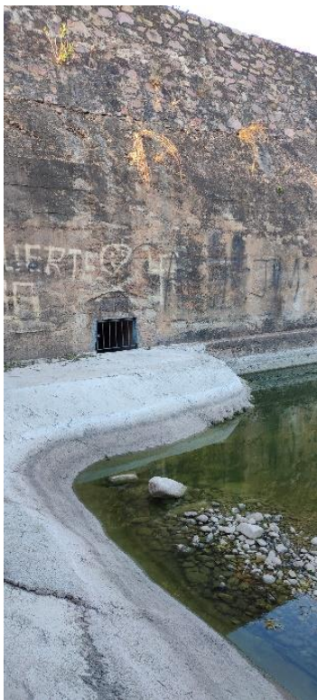
[Fig. 73] Reconstrucció del Pantà. Font: Elaboració propia.
