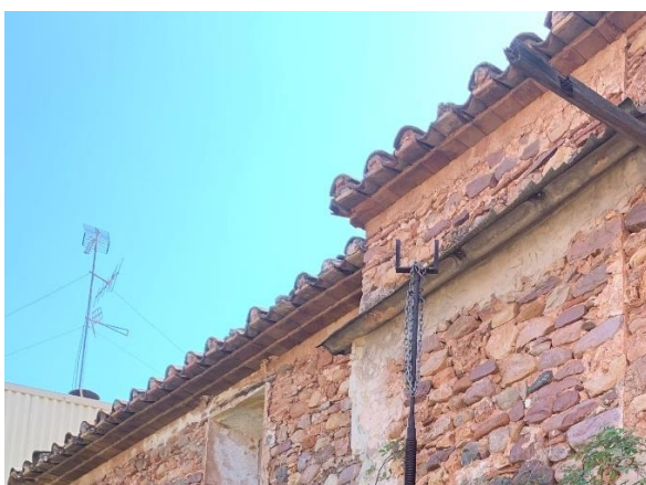
[Fig. 115] Detall del ràfol de rajola en la coberta inclinada. Font: Elaboració pròpia. 2020.
