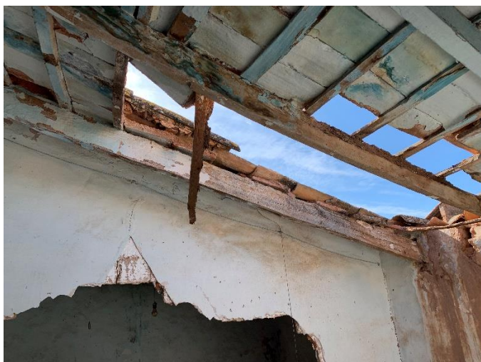
[Fig. 136] Falta de material de coberta facilitant l'entrada d'aigua. Font: Elaboració pròpia. Betxí. 2020.
