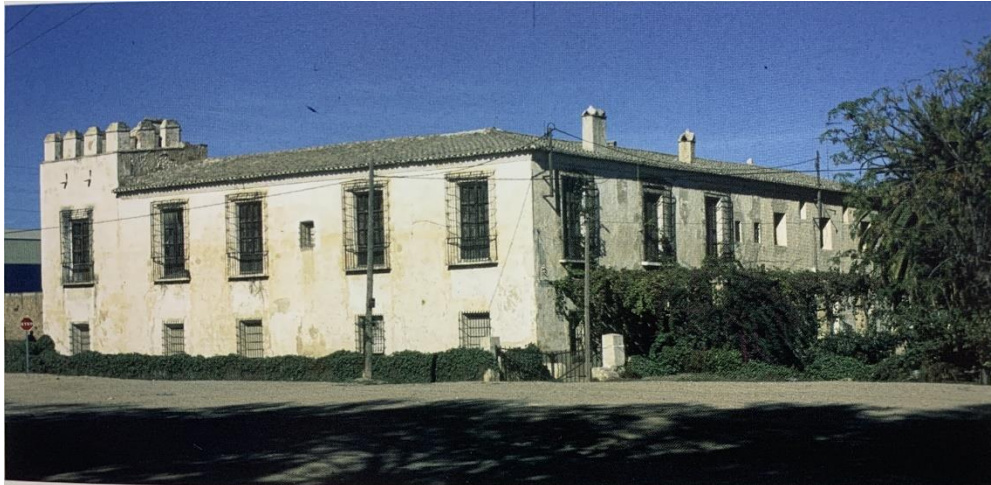
[Fig. 16] Alqueria de la Torre en el camí de Burjassot a València, segle XVIII. " Arquitectura Rural Valenciana ". Font: Miguel Del Rey i Aynat. Gerona. (2011)
