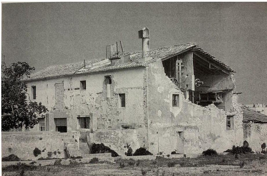
[Fig. 54] Vistes d'un antic molí en ruïnes en Almussafes. La Ribera. La imatge de l'edifici no evidència l'ús al que està destinat, i la seua construcció és idèntica a la de qualsevol casa de dos crugies amb carener sobre la línia central de càrrega. Es pot observar com la idea de construcció d'espai està per damunt de la condició d'ús en les arquitectures de les societats vernacules. L'adequació al medi vindrà donada per l'elecció dels materials i l'ajust particular dels distints elements de l'arquitectura. " Arquitectura Rural Valenciana: tipos de Casas dispersas y analisis de su arquitectura ". Font: Miguel Del Rey i Aynat. València. (1998)
