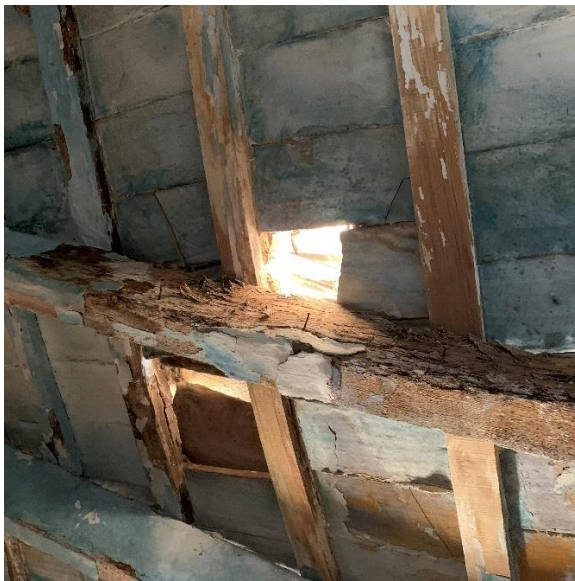
[Fig. 143] Putrefacció present en la fusta de l'estructura. Font: Elaboració pròpia. Betxí. 2020.
