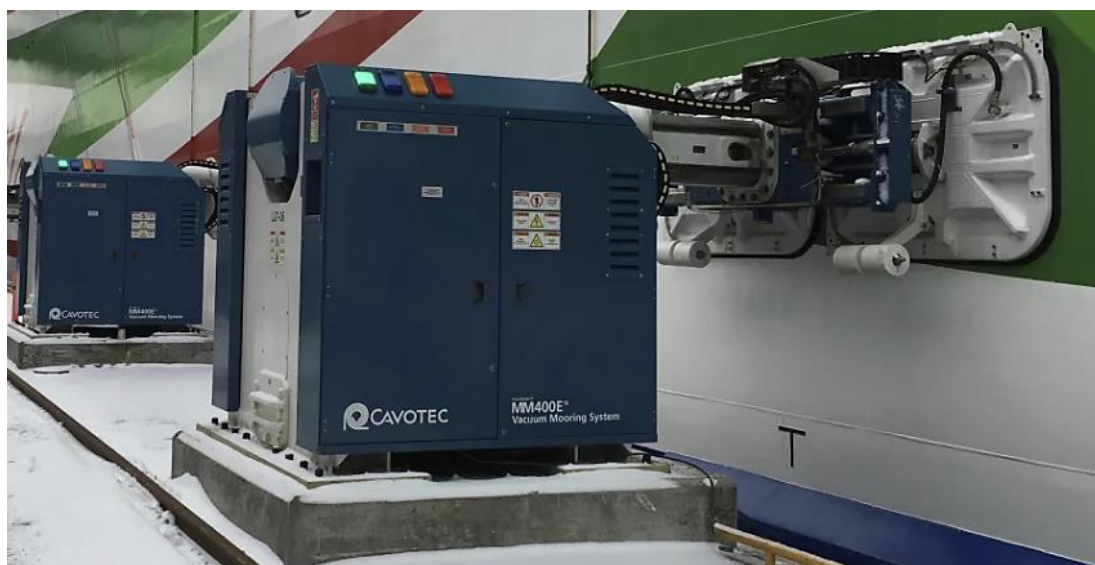
Ilustración 66. Ejemplo de sistema MoorMaster™ instalado en Helsinki en 2016
