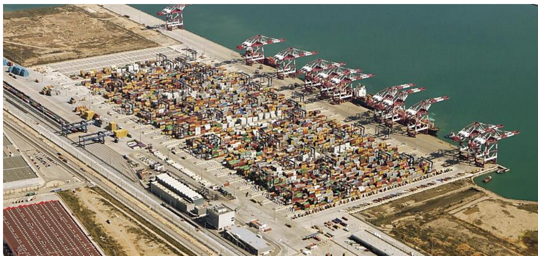
Ilustración 56. Terminal BEST en el Puerto de Barcelona.
