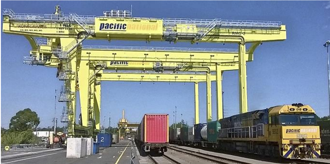
Ilustración 20. RMG sobre vía férrea.
