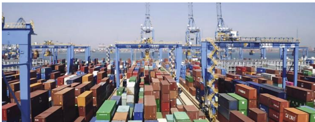
Ilustración 58. Terminal Qingdao New Qianwan Container.
