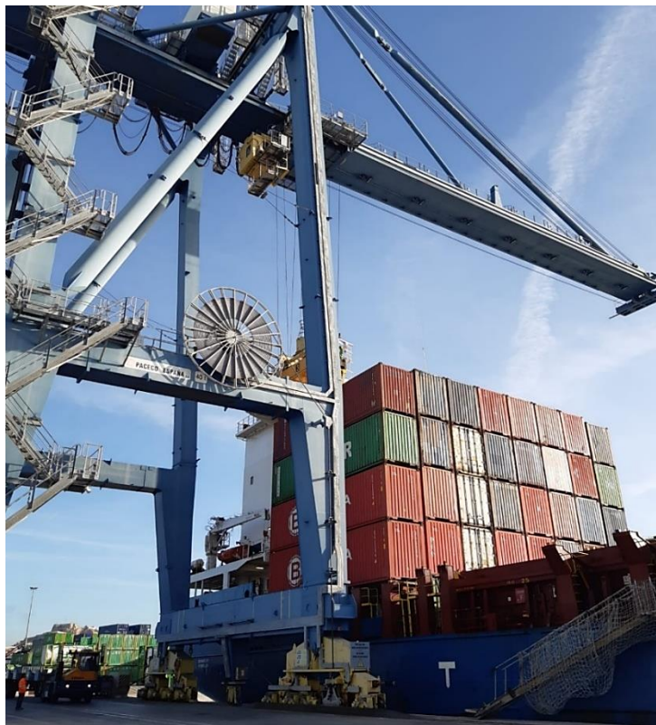
Ilustración 17. Subsistema de carga-descarga en Muelle 23 de TMS
