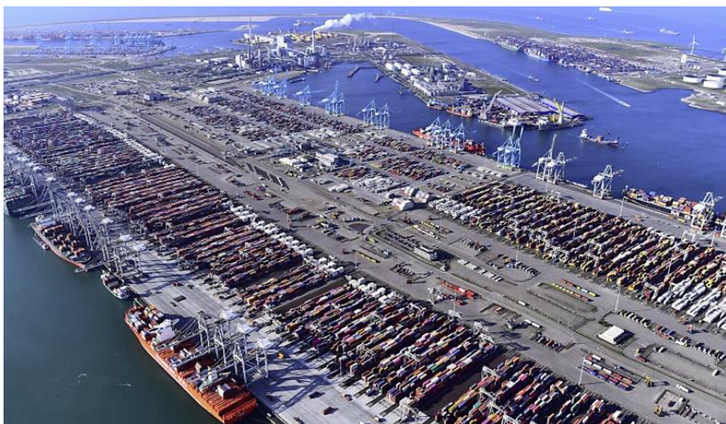
Ilustración 54. ECT Delta Terminal en el puerto de Róterdam.
