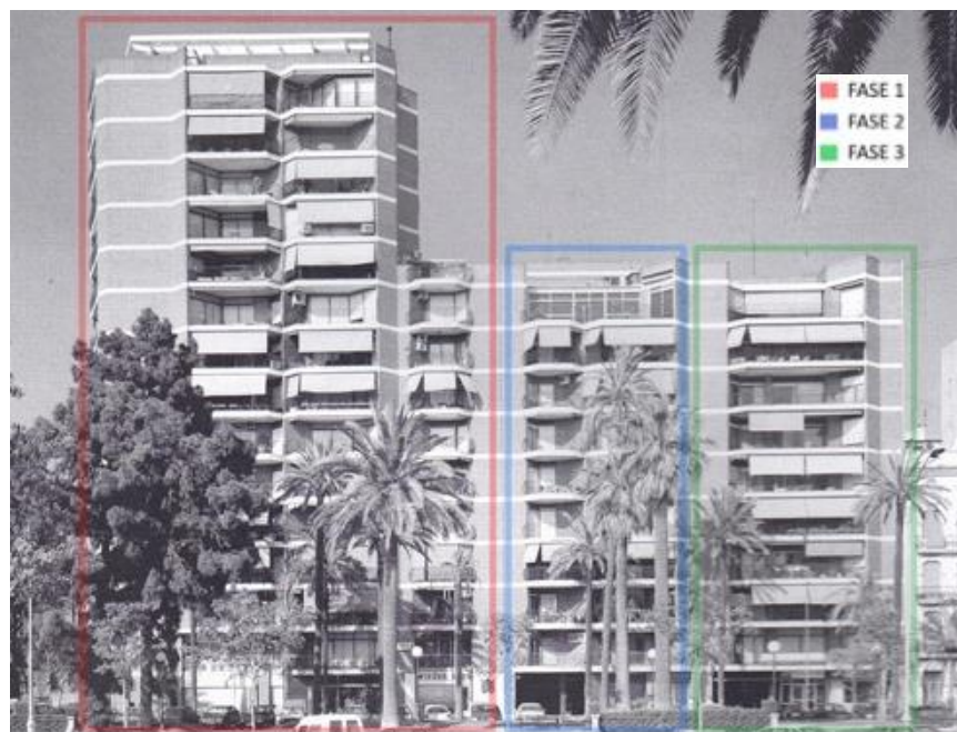
Figura 35. Diferenciación de fases constructivas del edificio de la alameda en la fachada de la Avenida de Pintor José Pinazo. (Libro: Miguel Colomina, Arquitecto )
