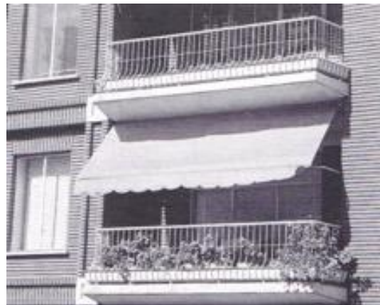
Figura 15. Detalle terrazas del edificio de viviendas de la calle Ruzafa de Valencia. (Libro: Miguel Colomina, Arquitecto )
