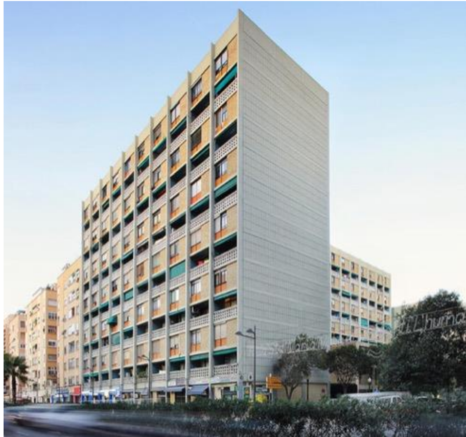
Figura 3. Vista exterior grupo residencial Santa María Micaela. (Fundación DoCoMoMo Ibérico)
