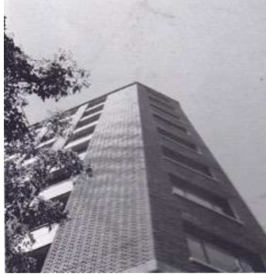
Figura 20. Detalle del chaflán del edificio de viviendas de la avenida Barón de Cárcer. (Libro: Miguel Colomina, Arquitecto )
