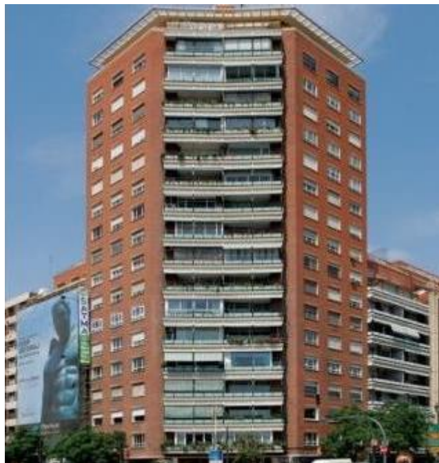
Figura 69. Vista exterior del edificio Gomez Trénor, Valencia. (Colegio Territorial de Arquitectos de Valencia)
