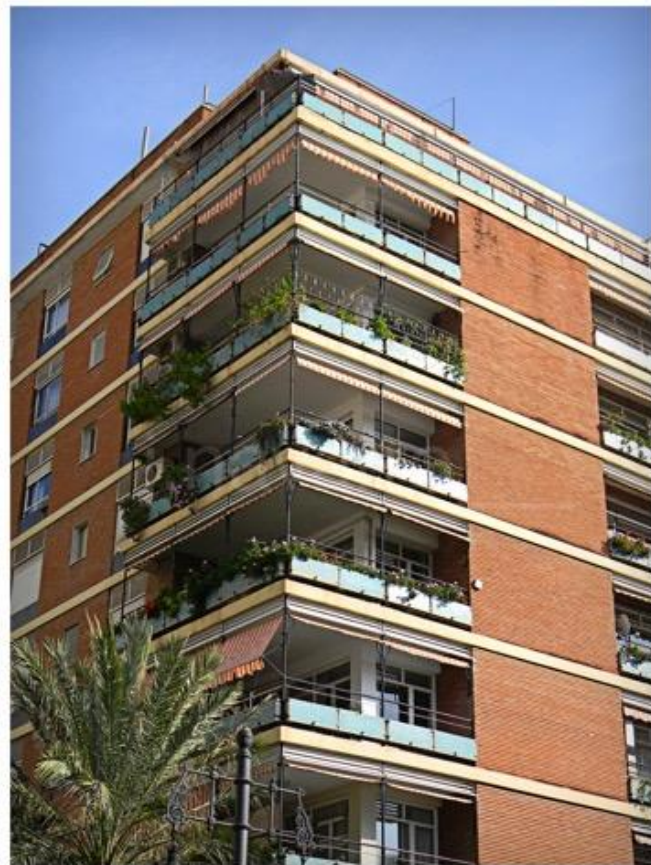
Figura 70. Vista exterior del edificio de Ingeniero de Elcano, Valencia. (Fundación DoCoMoMo Ibérico)
