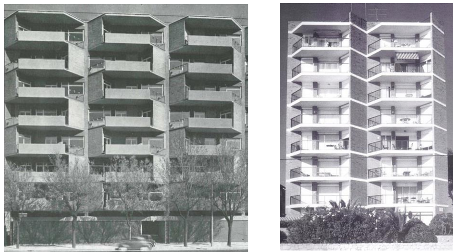
Figura 66. Comparativa entre las fachadas de los dos proyectos. Edificio de Julio G. Lafuente y Gaetano Rebecchini en Roma. ( Informes de la Construcción Vol. 11, nº103, agosto-septiembre de 1958). Edificio Torre del Montañar de Miguel Colomina en Jávea. (Libro: Miguel Colomina, Arquitecto ).
