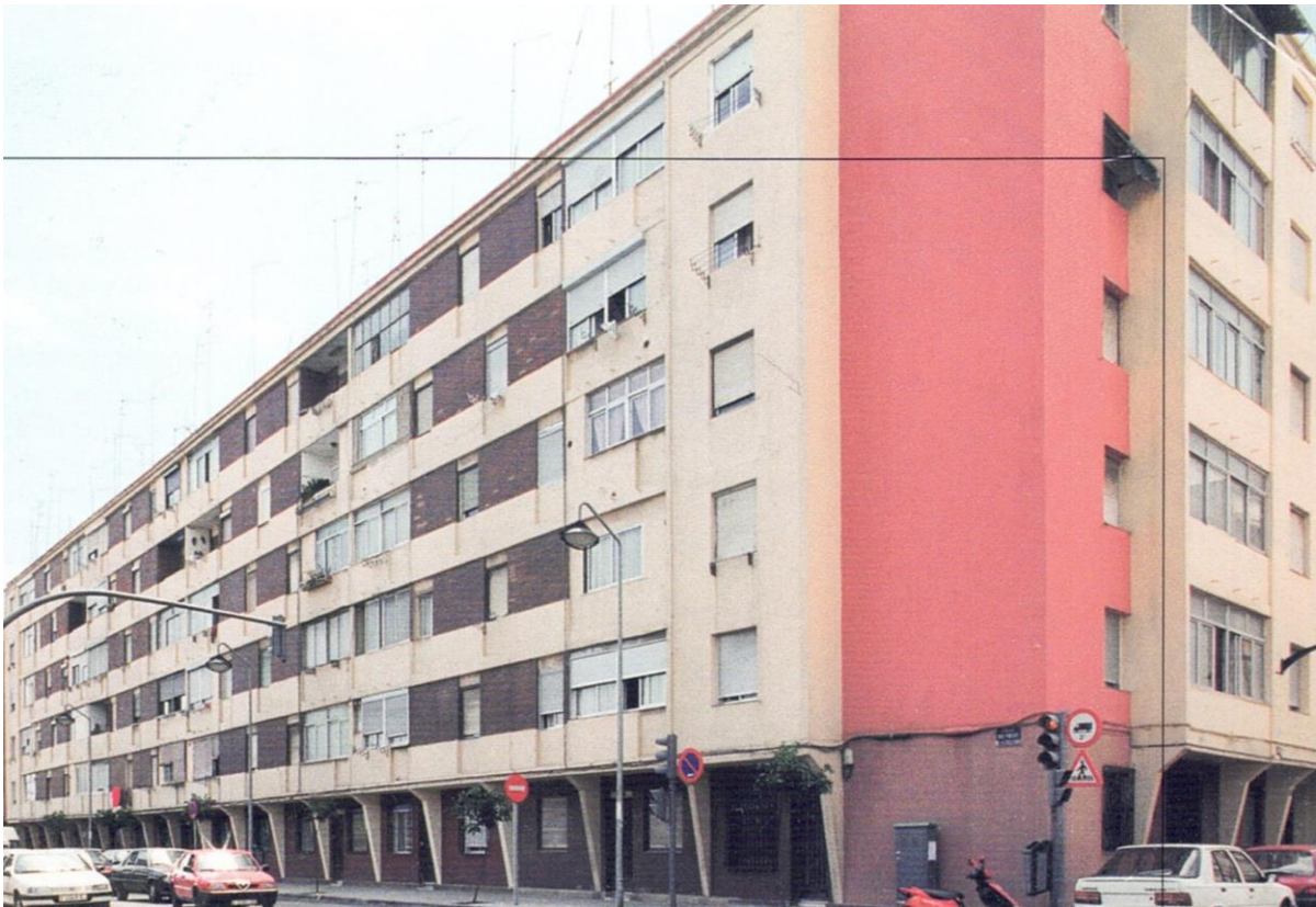
Figura 1. Vista exterior del grupo residencial Stella Maris. (Libro: Registro de arquitectura del s.XX. Comunidad Valenciana )
