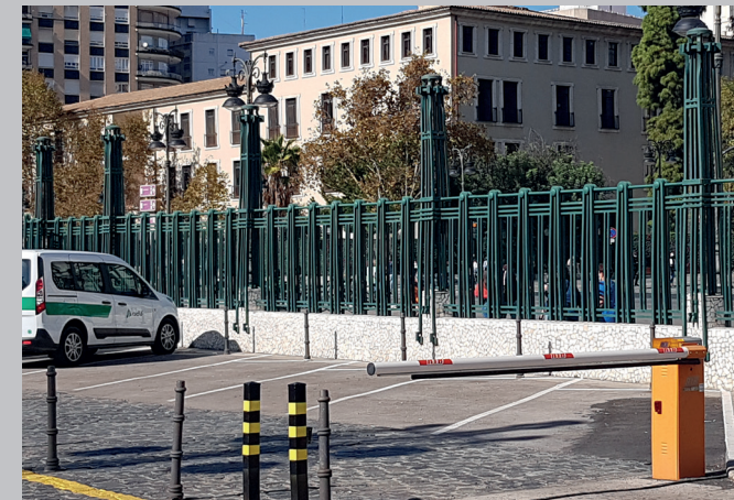
Figura 110: Verja exterior estación Fuente: Imagen propia
