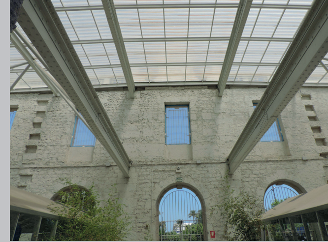
Figura 48: Vigas de ciervo vistas tras la demolición del forjado Fuente: López Peral, Ma A., Louis Cereceda, M., García González, E., 2017
