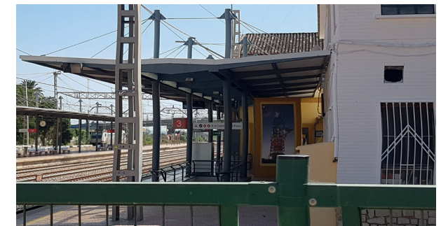
Figura 187: Vista lateral marquesina estación de Sagunto Fuente: Imagen propia
