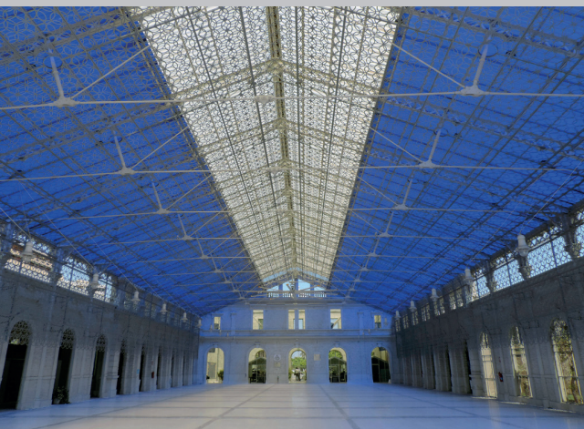
Figura 69: Estado actual (año 2020) de la Estación de Bernalúa Fuente: https://www.casa-mediterraneo.es/nuestra-sede/
