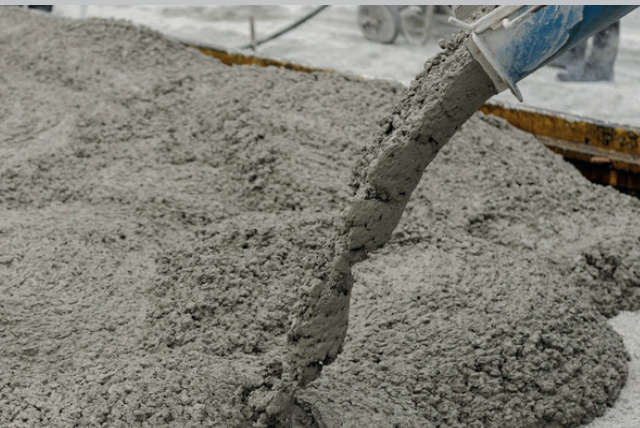
Figura 15: Vertido de cemento Portland Fuente: https://www.elsiglodetorreon.com.mx/
