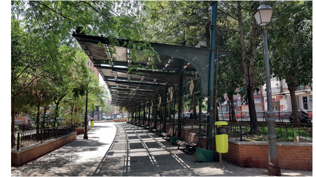
Figura 176: Vista lateral marquesina antigua estación de Jesús Fuente: Imagen propia
