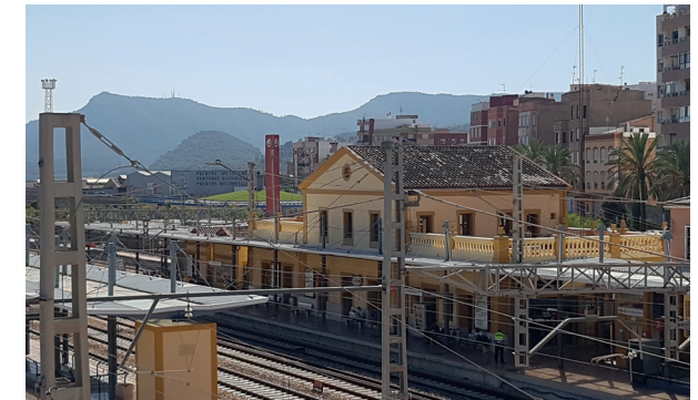
Figura 186: Vista general marquesinas estación de Sagunto Fuente: Imagen propia
