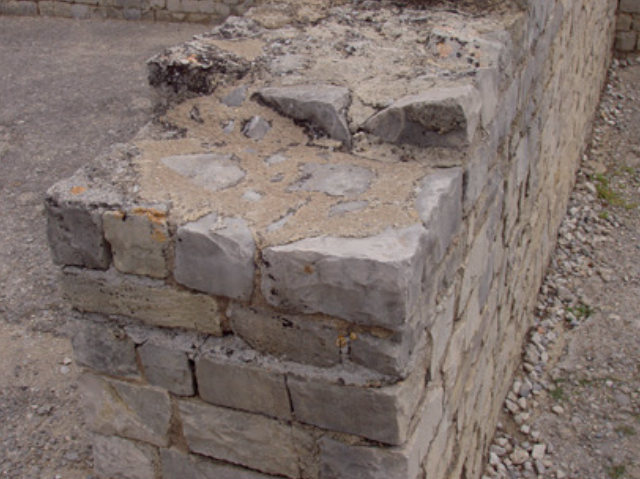
Figura 14: Muro de sillares unidos con Opus Caementicium Fuente: http://aragonromano.ftp.catedu.es/
