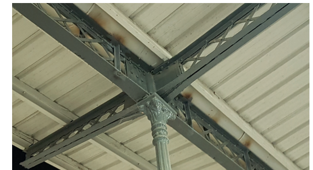
Figura 183: Encuentro columna fundición con viga de celosía
