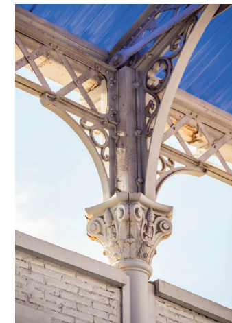
Figura 74: Encuentro cercha-columna de fundición Fuente: https://www.casa-mediterraneo.es/nuestra-sede/
