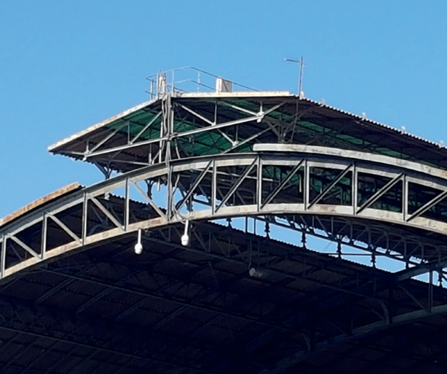
Figura 98: Imagen actual encuentro arco-linterna Fuente: Imagen propia
