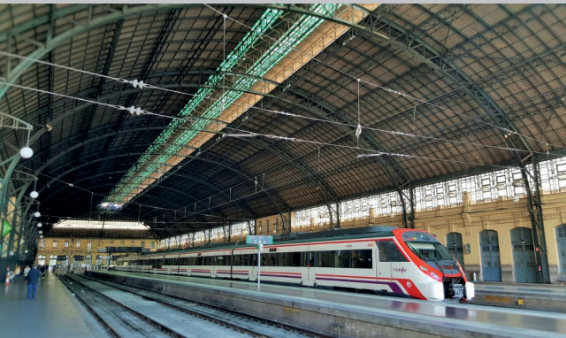
Figura 112: Estado actual cubierta hangar Fuente: Imágen propia
