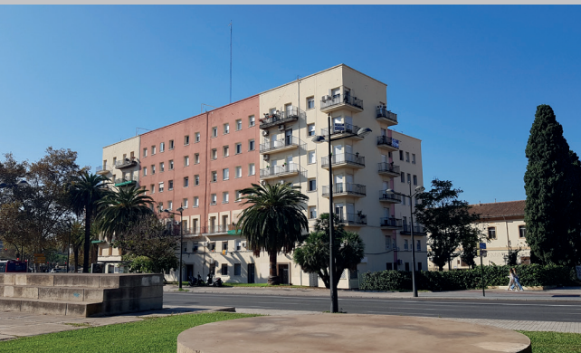
Figura 147: Edificio de viviendas de los trabajadores Fuente: Imagen propia
