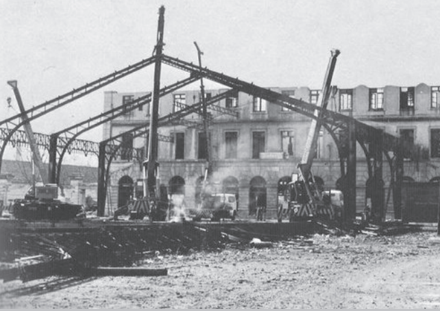
Figura 145: Desmontaje hangar estación Central de Aragón (1974) Fuente: http://www.arquitecturayempresa.es/
