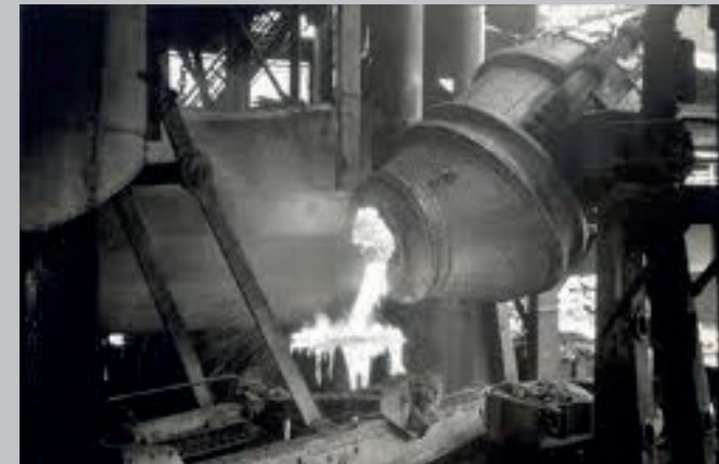
Figura 13: Convertidor Bessemer Fuente: https://www.timetoast.com/
