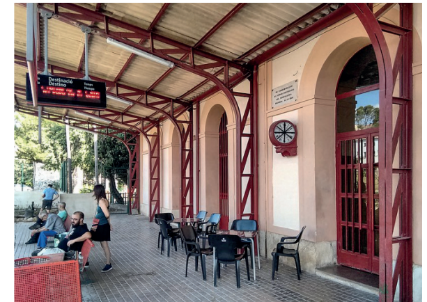
Figura 162: Vista en detalle elementos marquesina estación Requena
