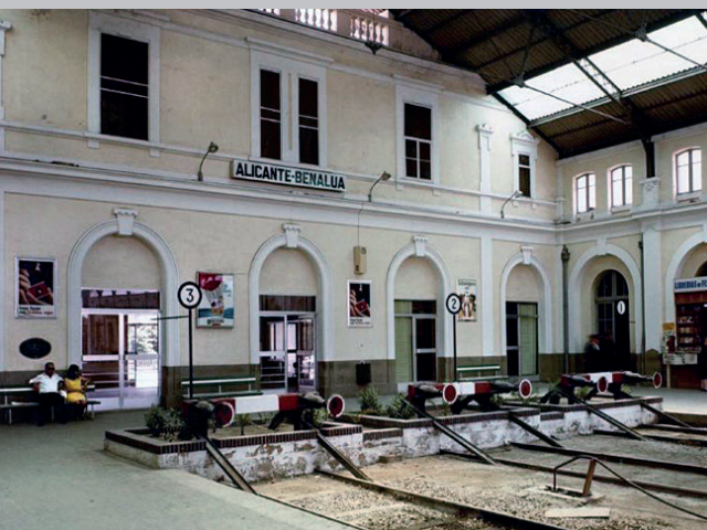
Figura 46: Toperas vías estación de Benalúa Fuente: https://www.pinterest.es/
