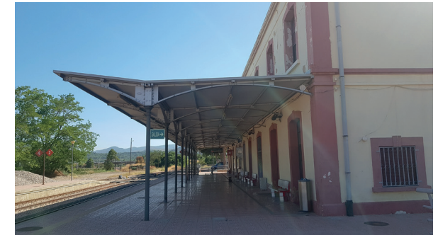
Figura 170: Vista lateral marquesina estación de Segorbe Fuente: Imagen propia
