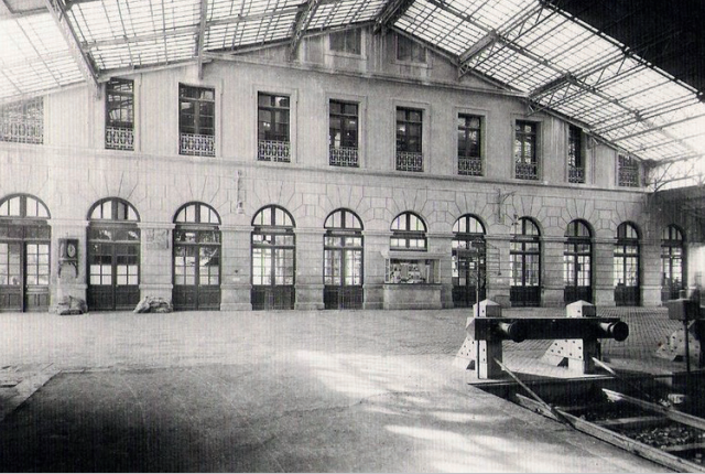
Figura 135: Vigas de enlace entre pórticos Fuente: https://www.arquitecturayempresa.es/
