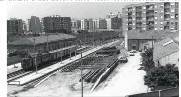
Figura 165: Estación de Marxalenes y cocheras Fuente: https://valenciablancoynegro.blogspot.com/
