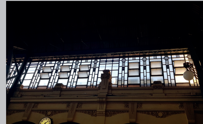
Figura 89: Ventanal lateral Fuente: Imágen propia
