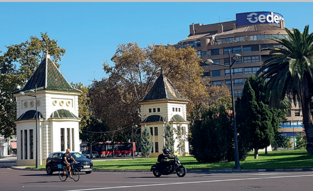
Figura 146: Torres de las aduanas en la actualidad Fuente: Imagen propia
