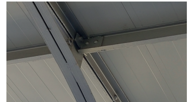
Figuras 173: Encuentro viga con correa Fuente: Imagen propia
