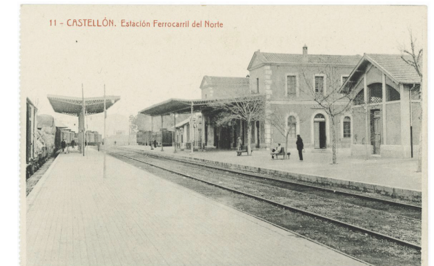
Figura 156: Andenes estación Castellón, Año 1862 Fuente: https://bivaldi.gva.es/
