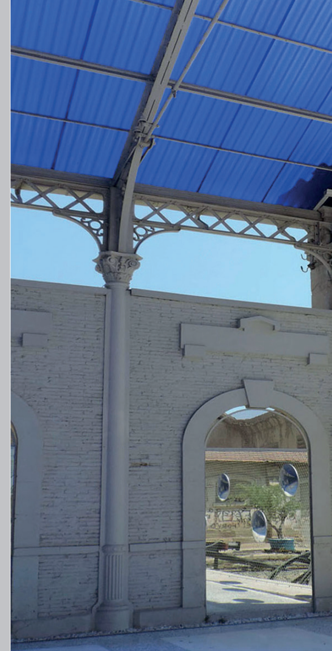
Figura 52: Columna de fundición de la estación de Benalúa Fuente: López Peral, Ma A., Louis Cereceda, M., García González, E., 2017
