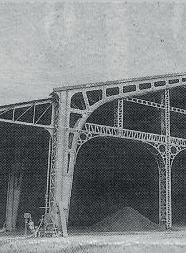
Figura 136: Encuentro marquesina lateral con pórtico Fuente: https://www.arquitecturayempresa.es/
