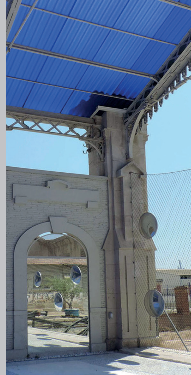
Figura 56: Columna de sillería de la estación de Benalúa Fuente: López Peral, Ma A., Louis Cereceda, M., García González, E., 2017
