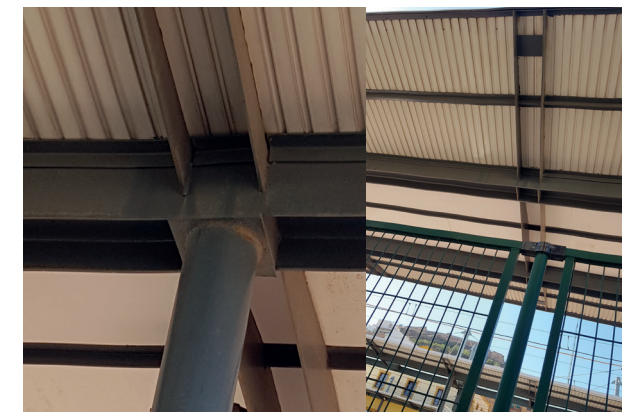
Figuras 188 y 189: Encuentro soporte-viga | Presillas laterales Fuente: Imágenes propias
