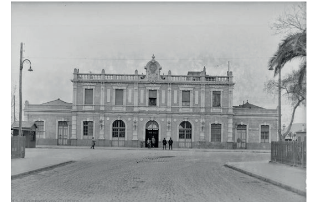
Figura 72: Fachada principal, Año 1890 Fuente: https://www.pinterest.es/pin/68328119326471053/
