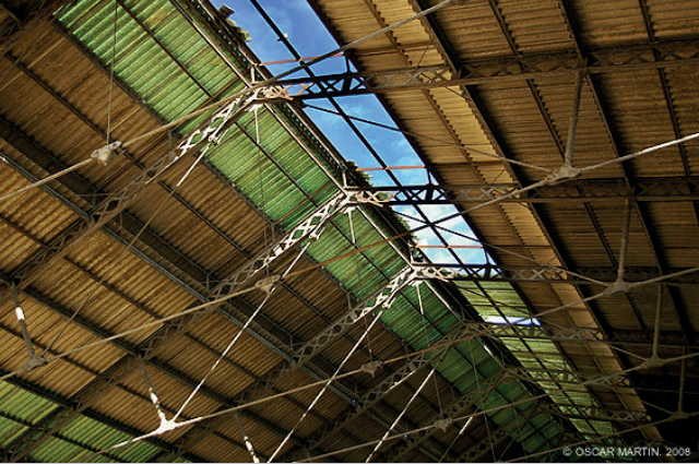
Figura 44: Cerchas hangar de la estación de Benalúa Fuente: http://www.barriodebenalua.es/2008/02/
