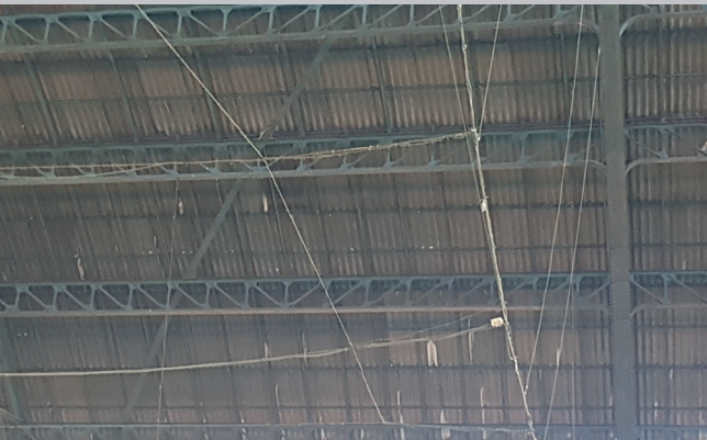
Figura 96: Vigas de conexión Fuente: Imagen propia
