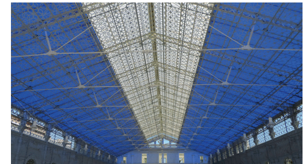
Figura 73: Vista general cerchas durante la rehabilitación Fuente: https://www.casa-mediterraneo.es/nuestra-sede/
