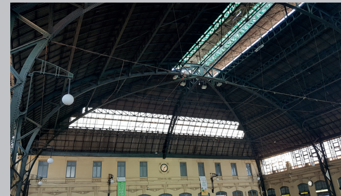
Figura 93: Visión general bóveda rincón de claustro Fuente: Imagen propia
