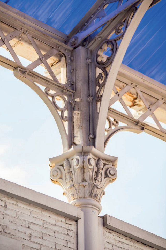
Figura 61: Imagen actual del encuentro cercha-columna de fundición Fuente: https://www.casa-mediterraneo.es/nuestra-sede/
