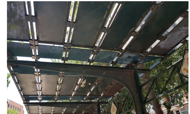
Figura 177: Viga marquesina antigua estación de Jesús Fuente: Imagen propia
