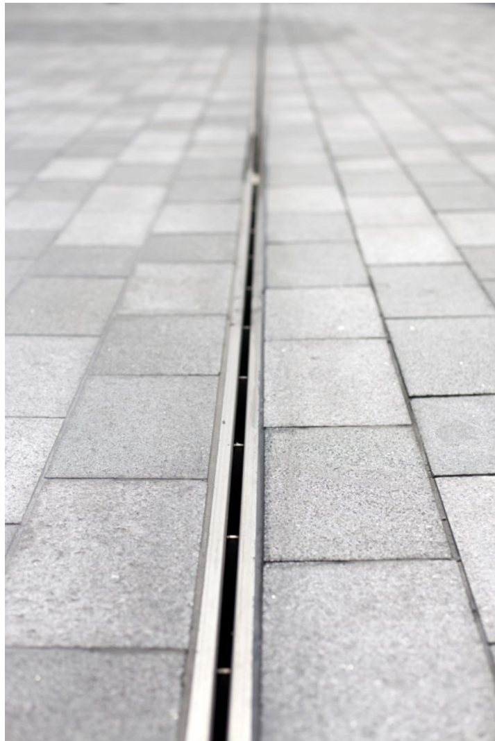
img_95_ejemplo de pavimentación en piedra(www.landezine.com)
