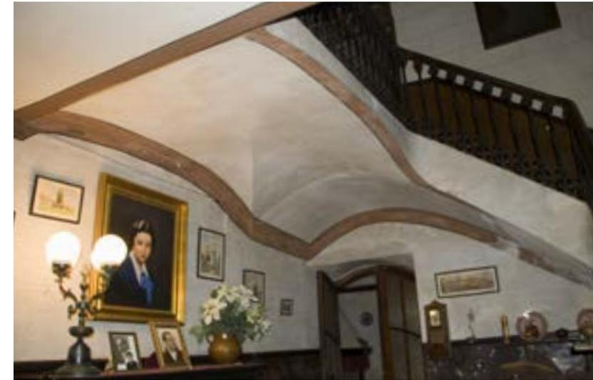
Fig. 20. Bóveda tabicada revirada. Fuente: Fotografía del autor
