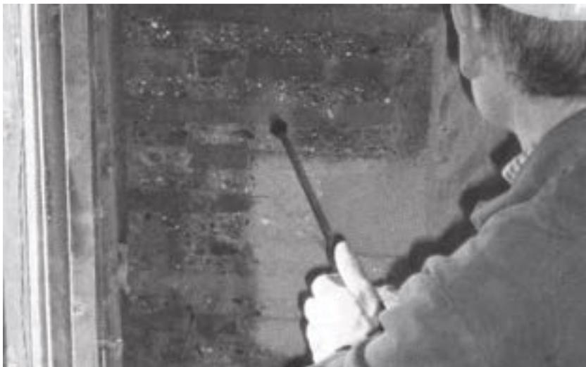
Fig. 115. Consolidación protectora de superficies. Fuente: C. Mileto, F. Vegas
