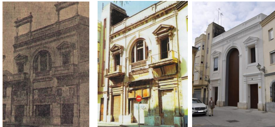
Fig. 39: 01 Fachada de El Musical. 02 Fachada de El Musical deteriorada. 03 Fachada de El Musical actualmente
