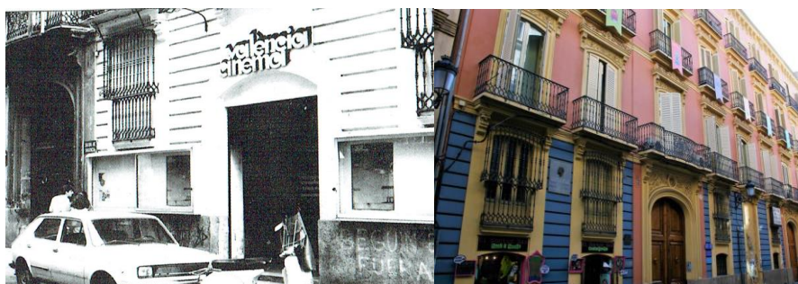
Fig. 26: 01 Fachada del Valencia Cinema. 02 Fachada del edificio actualmente
