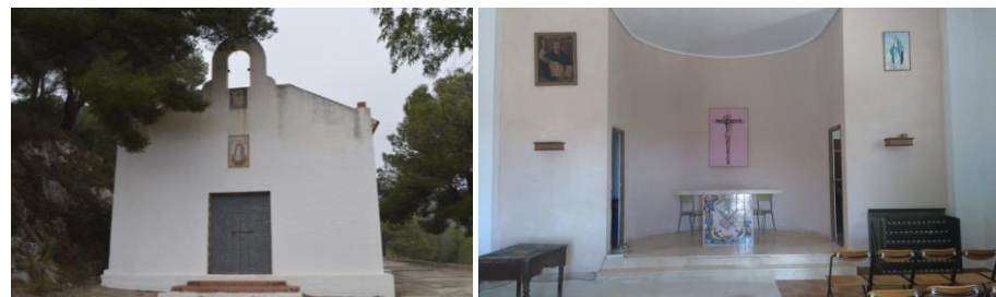
Fig. 75: 01 Fachada de la Ermita. 02 Interior de la Ermita
