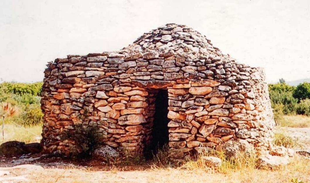
Figura 57: Imagen de una barraca de volta extraída del libro de V. Meseguer: Arquitectura popular de pedra seca al terme de Vinaròs , 143.
