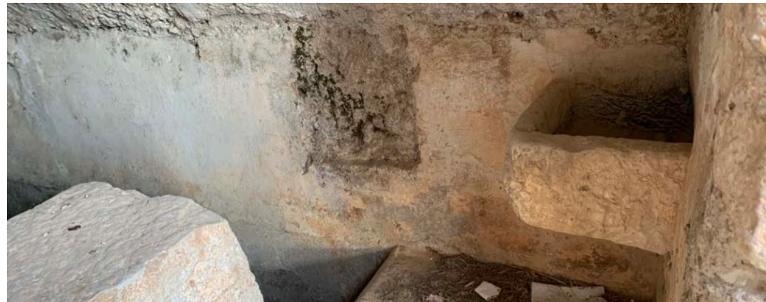
Figura 76: Fotografía de elaboración propia del interior del aljibe.
