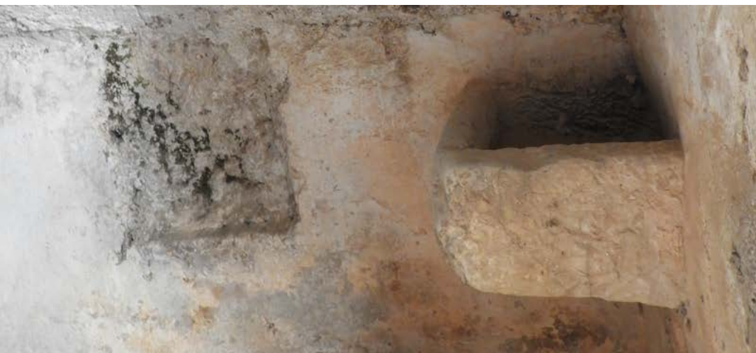
Figura 72: Fotografía de elaboración propia del interior del aljibe.
