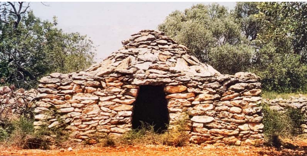
Figura 58: Imagen de una barraca de volta extraída del libro de V. Meseguer: Arquitectura popular de pedra seca al terme de Vinaròs , 149.
