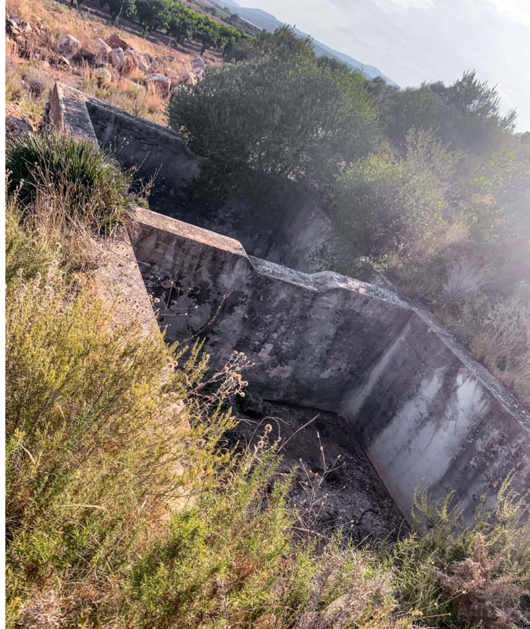
Figura 64: Fotografía de la balsa situada en la Masía Conill, realización propia.
