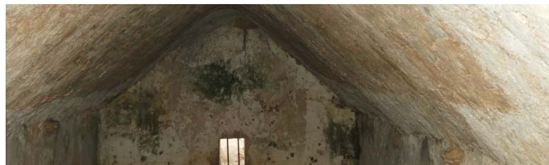
Figura 68: Fotografía de elaboración propia del interior del aljibe.
