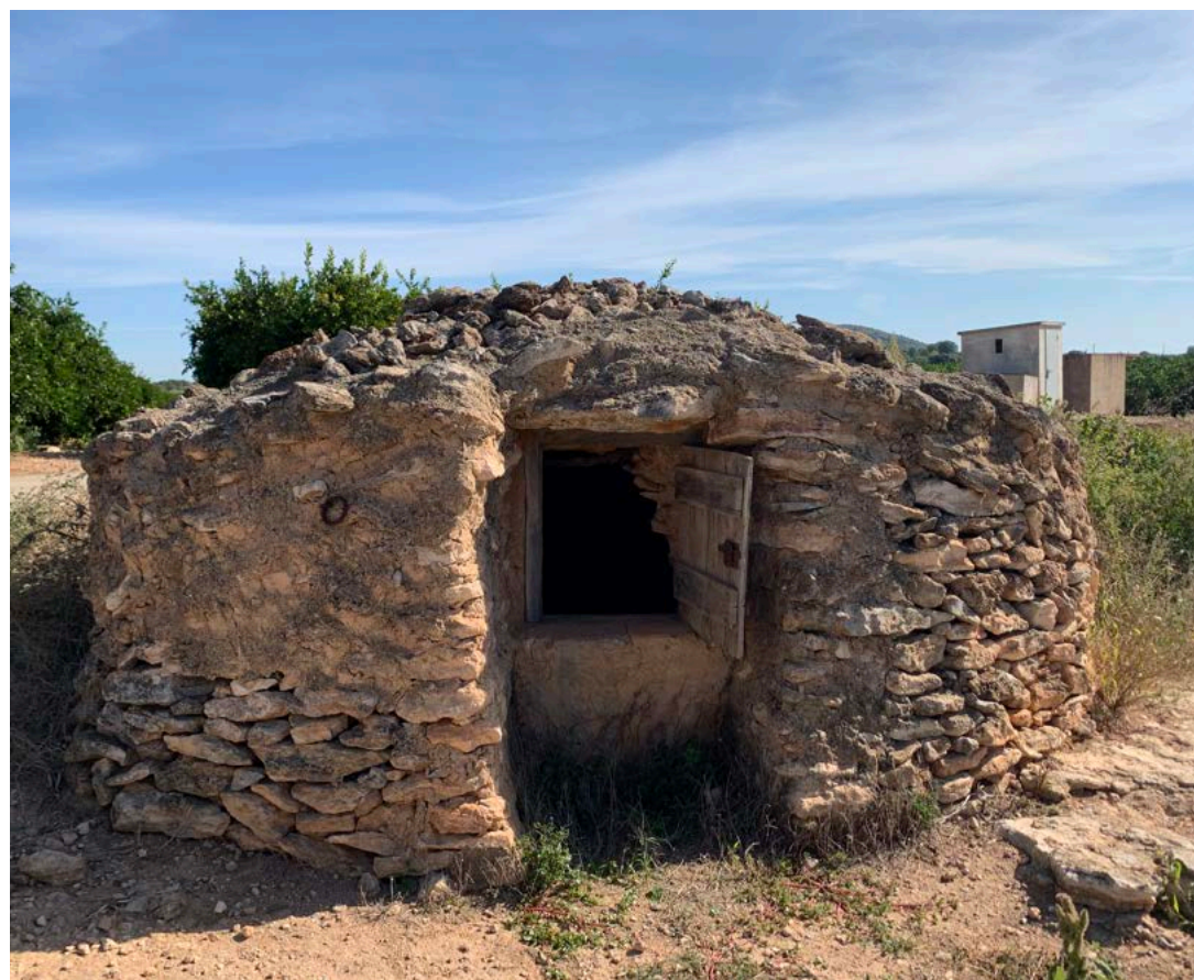
Figura 56: Fotografía de elaboración propia de una cisterna.
