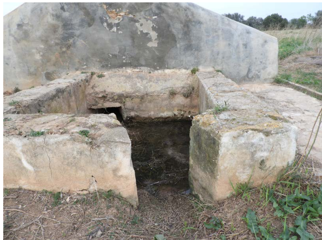
Figura 87: Fotografía de elaboración propia del colector del aljibe.
