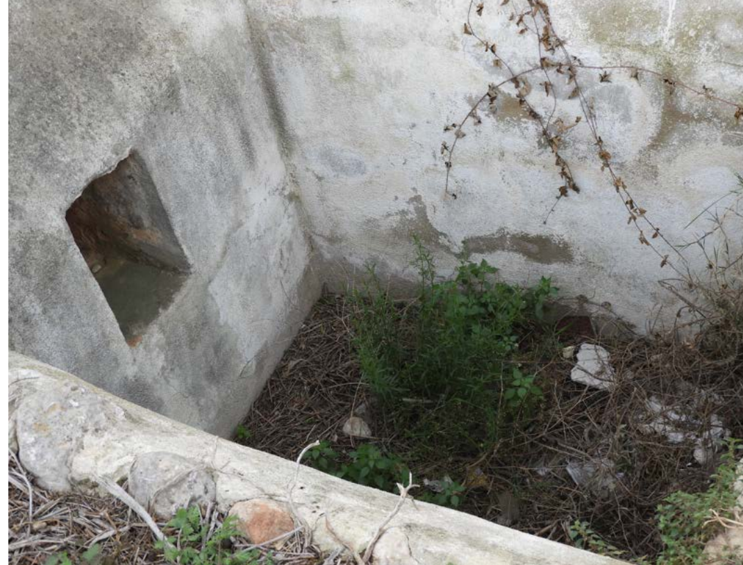
Figura 73: Fotografía de elaboración propia del colector del aljibe.
