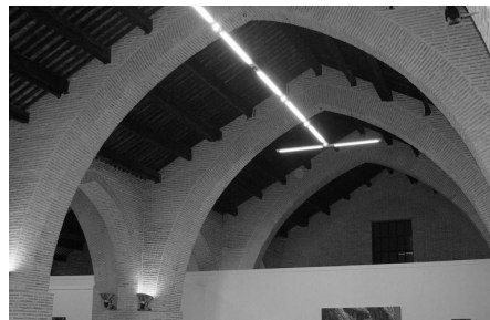
Figura 2.11_Vista interior: Arcos diafragmáticos.
