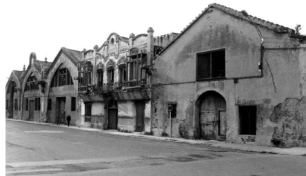
Figura 2.27_Atarazanas del Puerto de Valencia, antes de su rehabilitación. Años 60.
