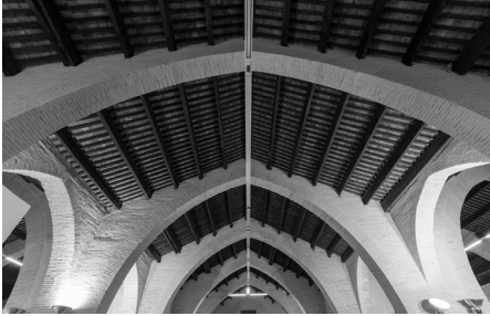
Figura 2.14_ Vista interior del edificio: Se puede observar las correas de madera y los tableros de ladrillos.
