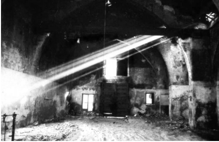
Figura 2.25_Atarazanas del Puerto de Valencia, antes de su rehabilitación. Años 60.
