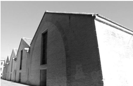
Figura 2.16_ Vista exterior: Parte trasera del edificio, arcos tabicados.
