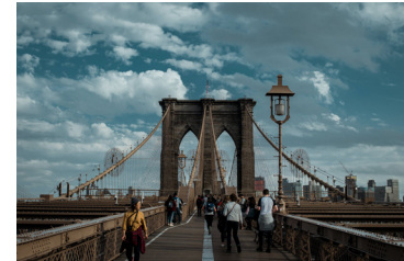
Fig.2 Puente en Nueva York. Autor: Fernando Gonzalez. Fuente: www.pexels.com
