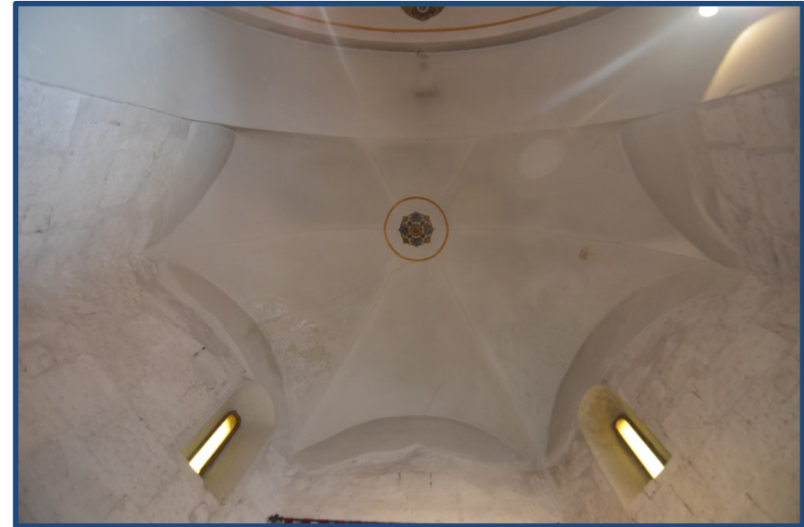
Figura 4.269- Vista de bóveda existente hoy, en el interior de la torre antigua del campanario, con las pequeñas ventanas, situada junto a la entrada lateral de la iglesia de Santa María de Ontinyent. (2020).
