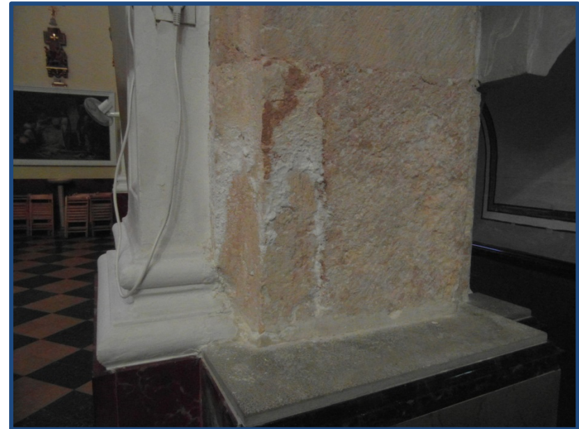
Figura 5.55- Eflorescencias aparecidas en la base del soporte, y de las que también hemos tomado muestras para analizar (2013)
