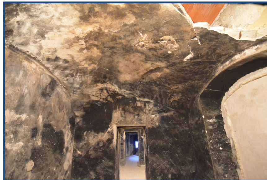
Figura 4.253- Vista de la parte superior de la tercera capilla lateral del lado de la Epístola en la Iglesia de San Bartolomé de Vallada, donde vemos que ya no tenemos las bóvedas de crucería, tramo que ya pertenece a la ampliación de Jordà Selva. (2020).
