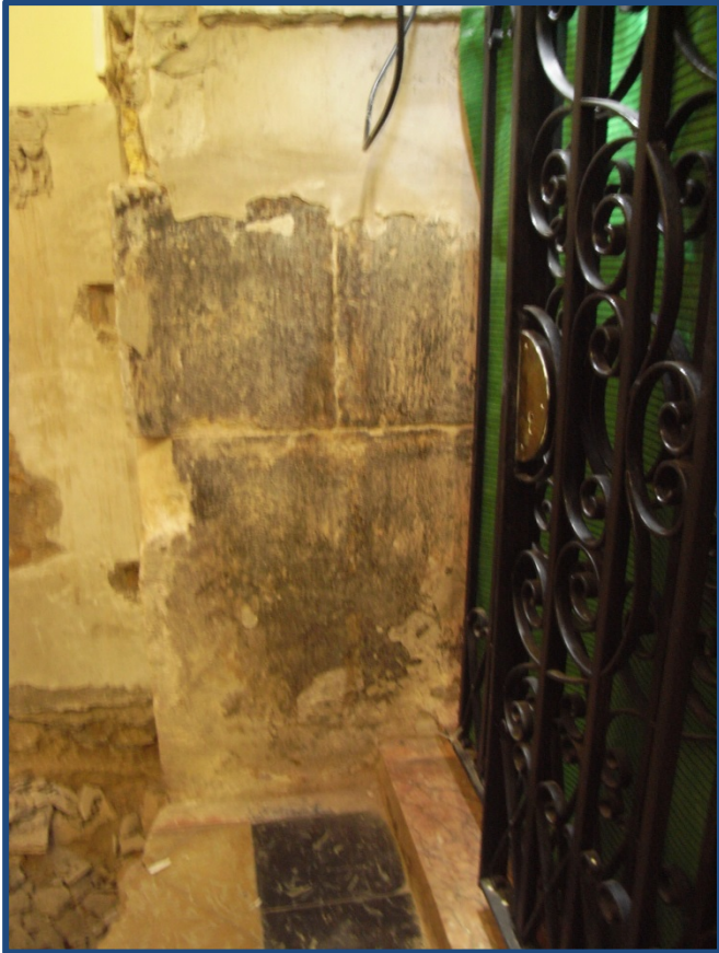
Figura 5.37.- Vista de los soportes laterales situados en el baptisterio, aparecidos durante las obras. (2013)
