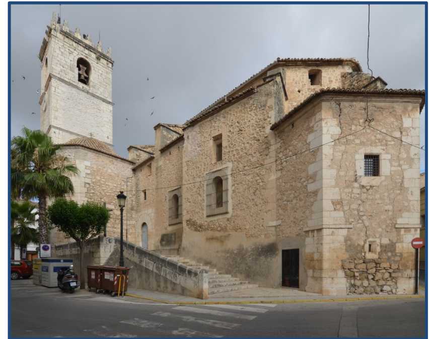
Figura 1.53. Vista exterior de la Iglesia parroquial de Santa María Magdalena de L'Ollería, con vista a la cabecera de la Iglesia, campanario y la entrada por la llamada puerta “dels Grisons”. (2016).
