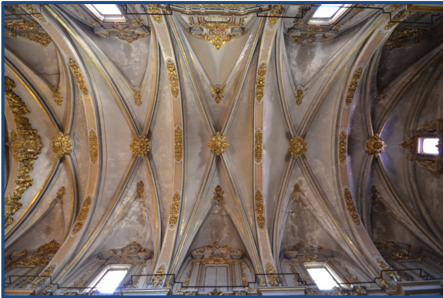
Figura 4.89- Vista de la bóveda actual de la nave central. Observamos el falseado de yeso que cubre la bóveda original. (2016)
