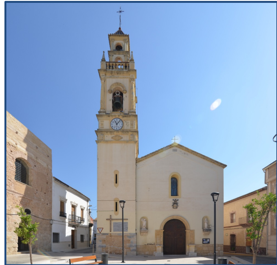
Figura 4.162- Vista fachada principal iglesia de SanMiguel y Santa María Magdalena de Massalavés. A la izquierda del templo, podemos ver los restos de la torre musulmana recientemente restaurada. (2017)
