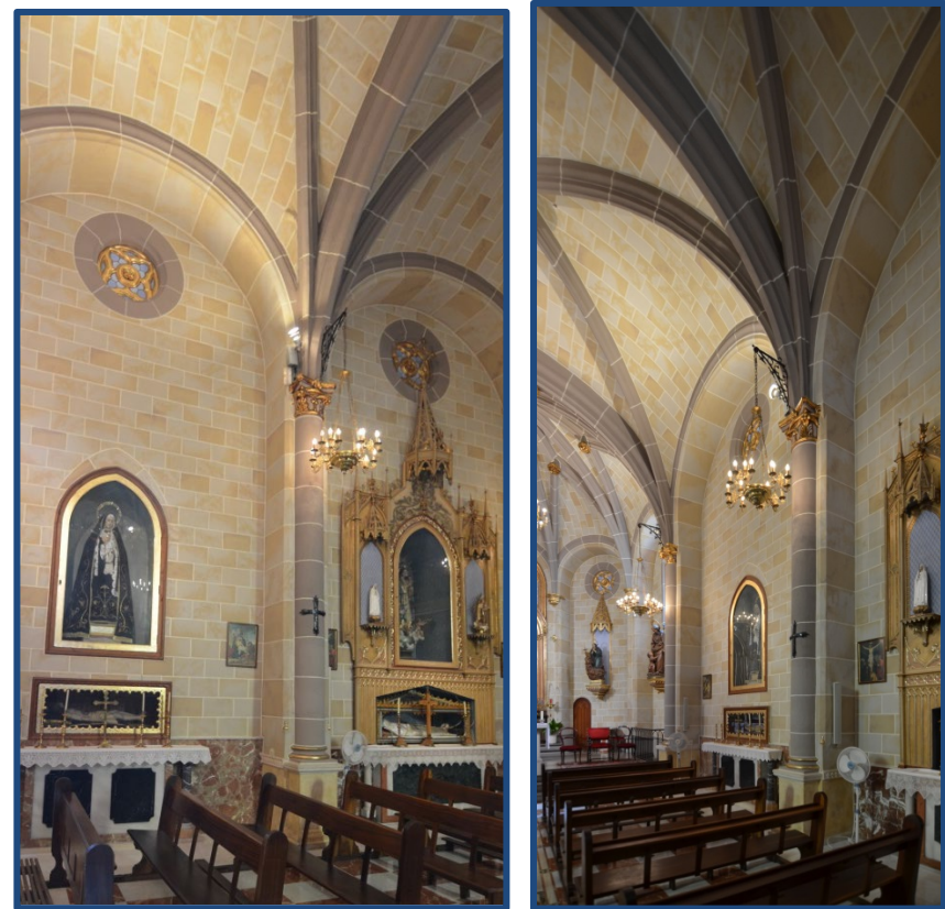
Figura 4.165 – 4.166 - Vistas interiores con los altares entre columnas dando a la nave principal de la iglesia de San Miguel y Santa María Magdalena de Massalavés, .. (2016)
