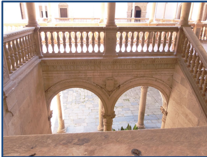
Figura 3.31.- Vista interior patio Castillo de La Calahorra, con el nombre del Marqués en el dintel de la escalera. (2014).
