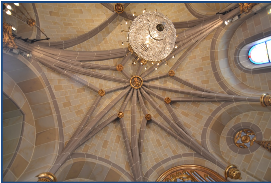
Figura 4.183- Vista de la bóveda de crucería situada sobre el altar de la iglesia de San Miguel y Santa María Magdalena de Massalavés (2016)
