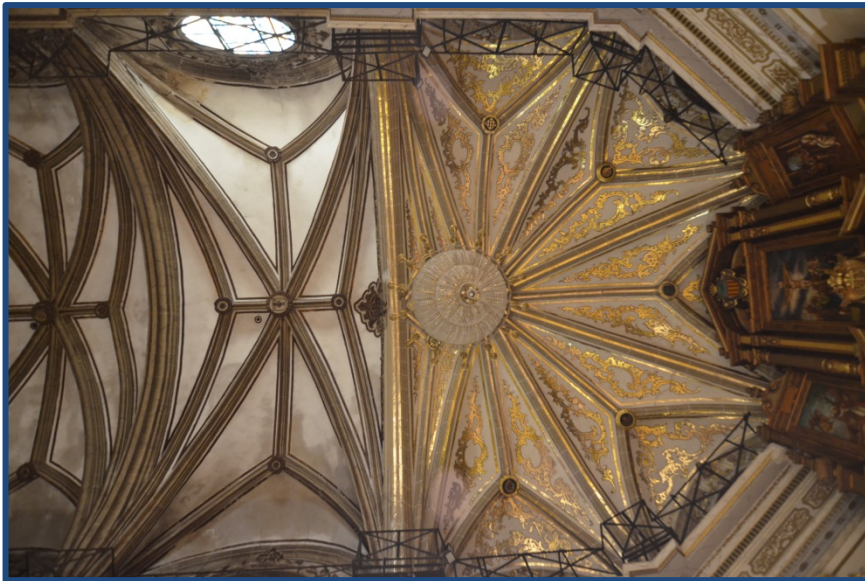
Figura 4.117- Vista de la parte superior del presbiterio, con la bóveda estrellada sobre la cabecera ochavada, así como el comienzo de las bóvedas de la nave central. (2016)
