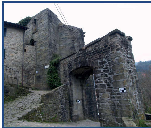
Figura 1.14. Ejemplo de colocación de dianas, imagen extraída del Curso de Levantamiento. (Merlo & Aliperta, 2014)
