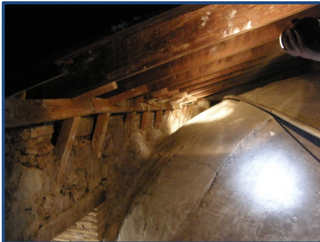
Figura 5.110 y 5.111. Arriba vista desde el interior de la cubierta de la Capilla de la Comunión, con la conexión entre la bóveda de cañón y la bóveda esférica de la capilla, y ventana reciente para aireación. Abajo, encuentro de la vigería de madera con los muros. (2013)
