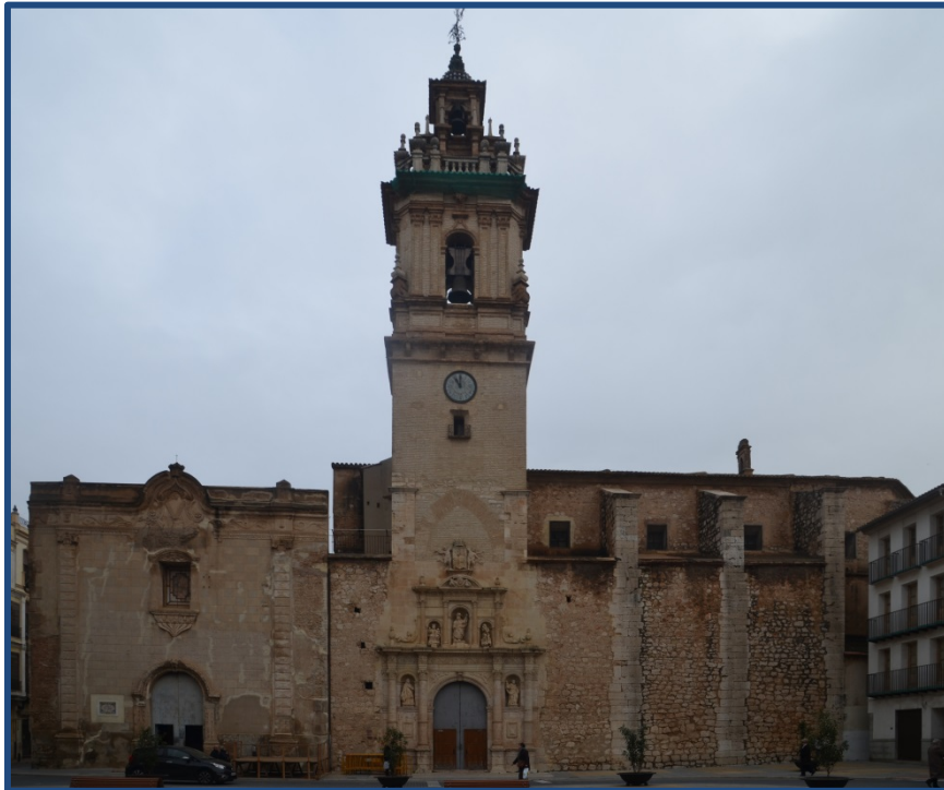
Figura 4.223- Fachada de la Iglesia de San Jaime de Algemés, donde podemos observar el campanario situado sobre la portada renacentista, así como el arco de descarga ojival, situado sobre la misma (2020).
