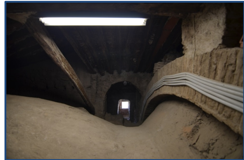
Figura 6.21. Vista del extradós de la bóveda vaída que cubre el presbiterio (izquierda), en la iglesia del Salvador de Cocentaina. (2017)
