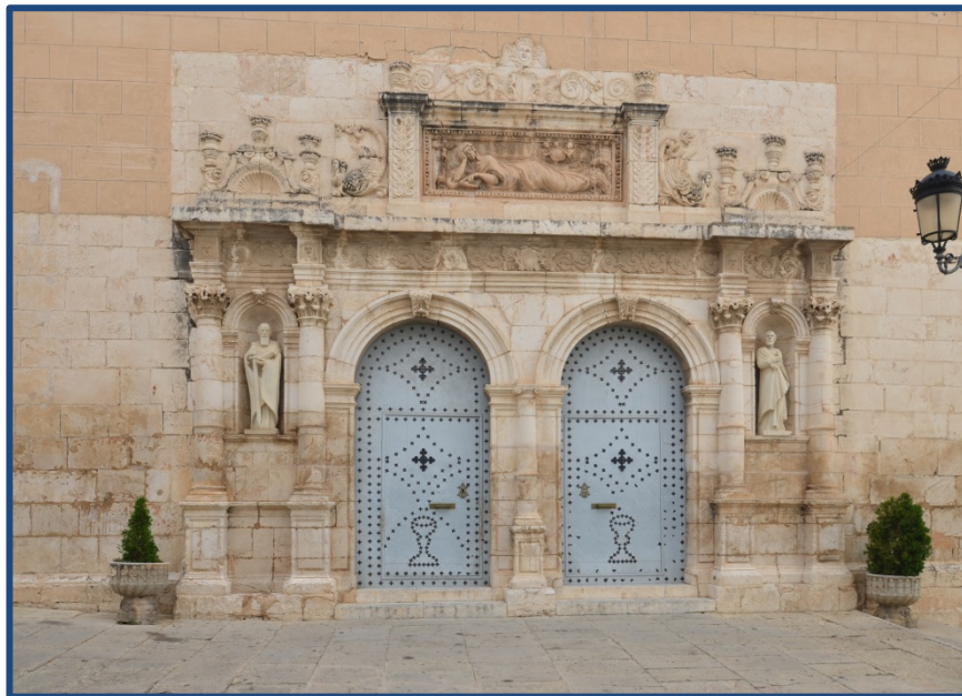
Figura 4.160- Vista entrada principal iglesia de Santa María Magdalena de L'Olleria, donde podemos ver la portada renacentista (2020)
