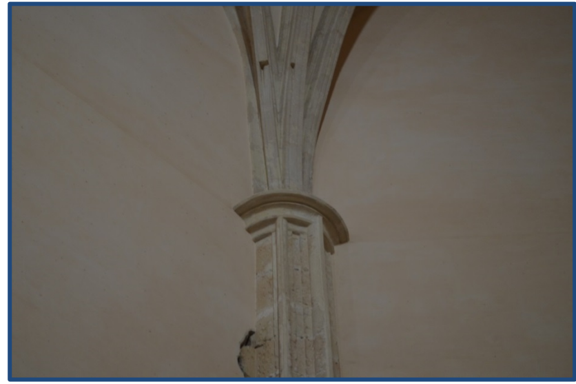
Figura 4.9.- Vista del remate de los soportes del presbiterio, donde se simplifican los capiteles con una sección semicircular. (2018)
