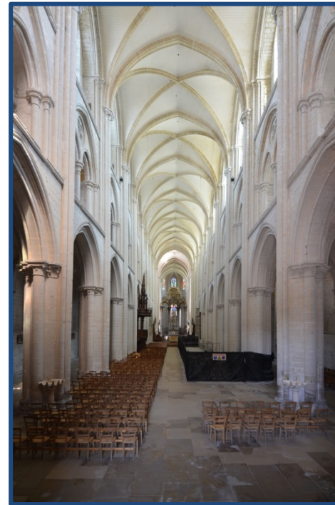
Figura 3.17- Abadía de Fécamp, vista nave principal interior. (2017)
