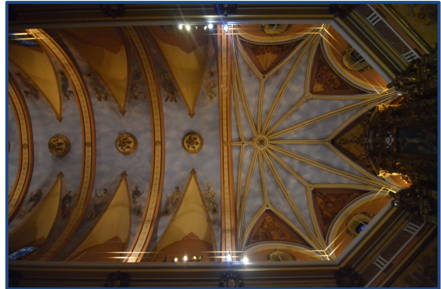
Figura 4.246- Vista del interior de la Iglesia de San Bartolomé de Vallada, bóveda estrellada cabecera ochavada y bóveda de cañón de la nave central.. (2020)
