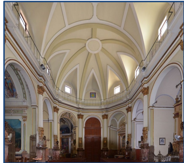
Figura 4.45.- Vista actual de la antigua cabecera del templo, como vemos recubierta por la cúpula barroca realizada en yeso, que simula la bóveda estrellada. Como veremos en las imágenes posteriores, bajo la decoración barroca, todavía perduran las bóvedas de crucería y las claves de bóveda decoradas. (2016)
