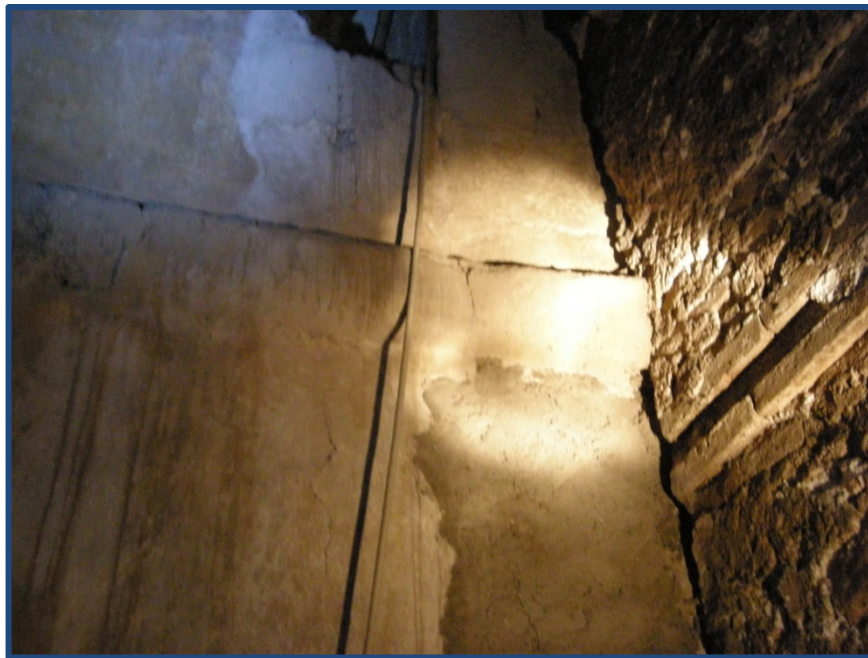
Figura 5.42- Molduras hoy ocultas, en las paredes laterales del campanario. Lo cual nos indica que ésta pared quedaba al exterior. Lo podemos ver en la imagen antigua (s. XVIII) en perspectiva mostrada con anterioridad. (2012)
