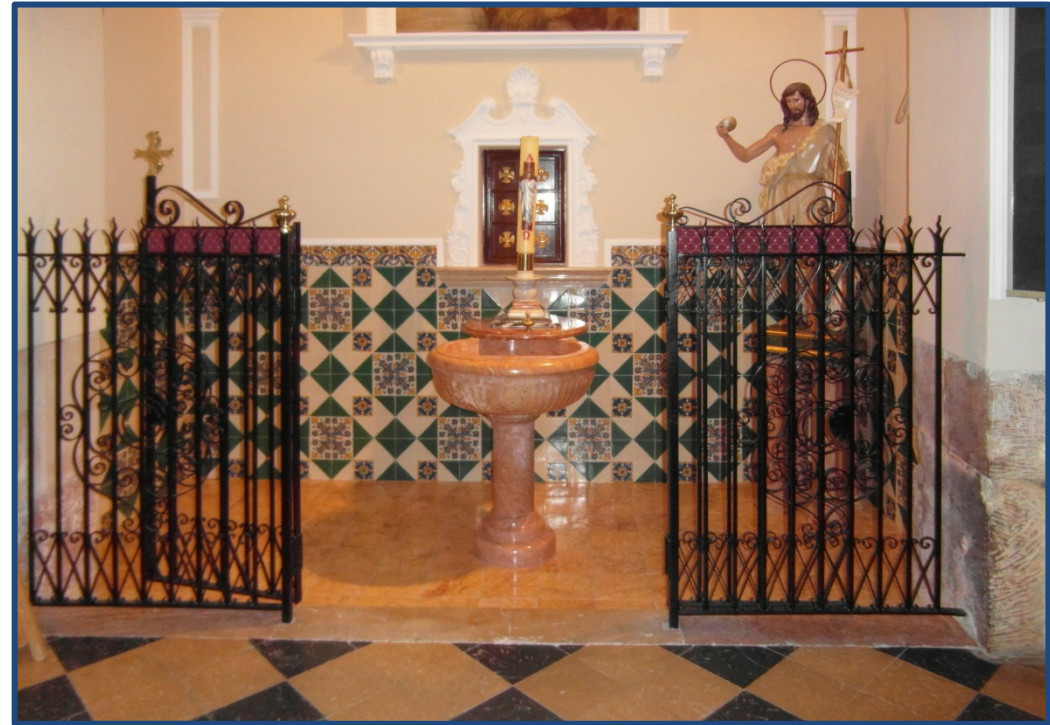
Figura 5.38- Vista del baptisterio tras las obras de remodelación, donde podemos observar los sillares encontrados que se han dejado vistos a ambos lados de la capilla. (2013)
