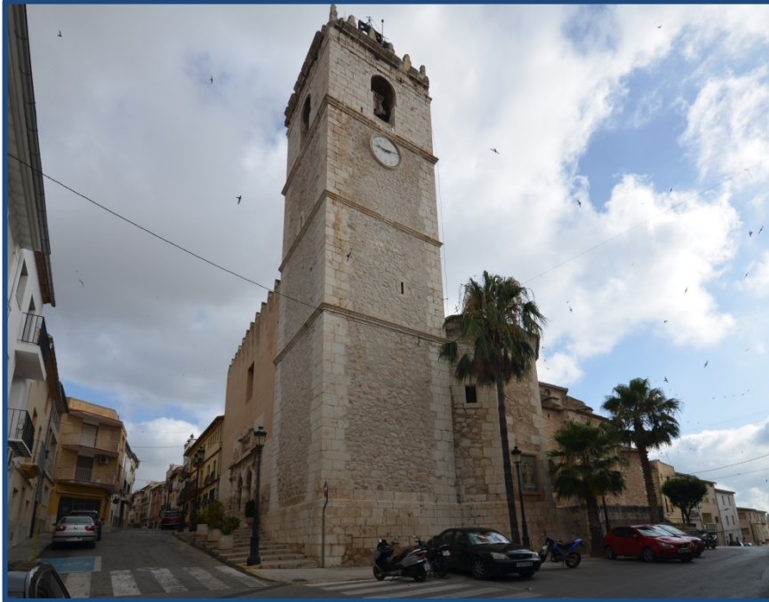
Figura 5.49- Vista de la torre campanario de Santa María Magdalena de l'Olleria. Podemos observar la similitud entre los cuerpos construidos de ésta torres, el cuerpo de campanas y el que podemos ver en Alberic. (2013)
