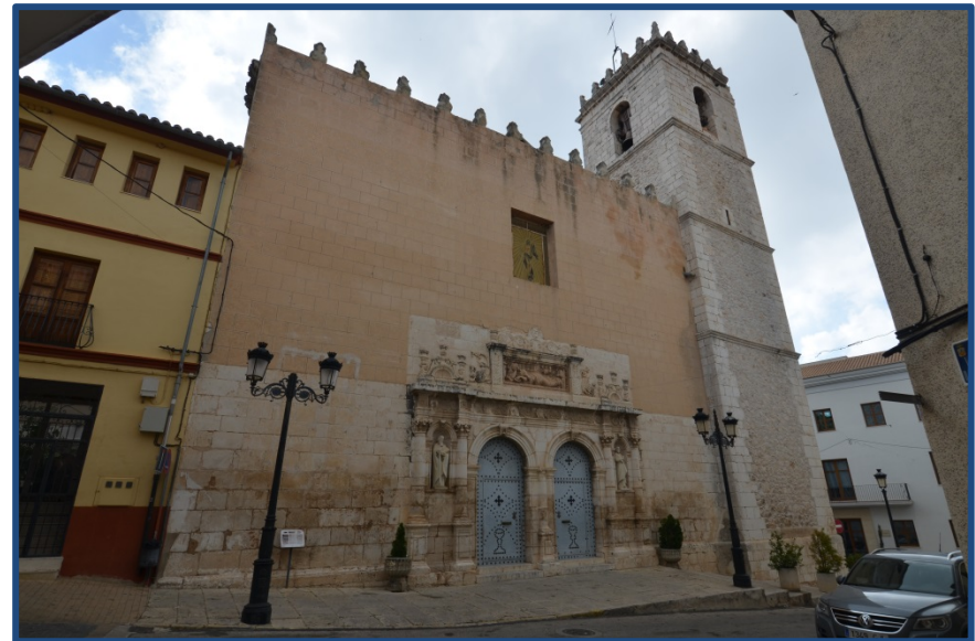
Figura 4.157- Vista Fachada principal iglesia de Santa María Magdalena de L'Olleria. (2020)
