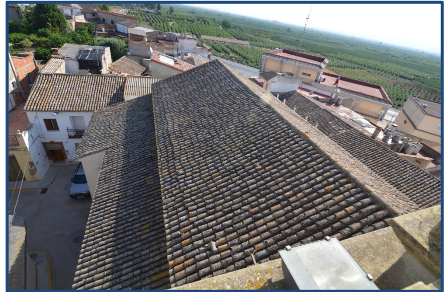
Figura 4.174- Fotografía tomada desde el campanario, donde podemos ver las cubiertas de la iglesia de Massalavés. A la derecha la cubierta de la nave central. (2016)
