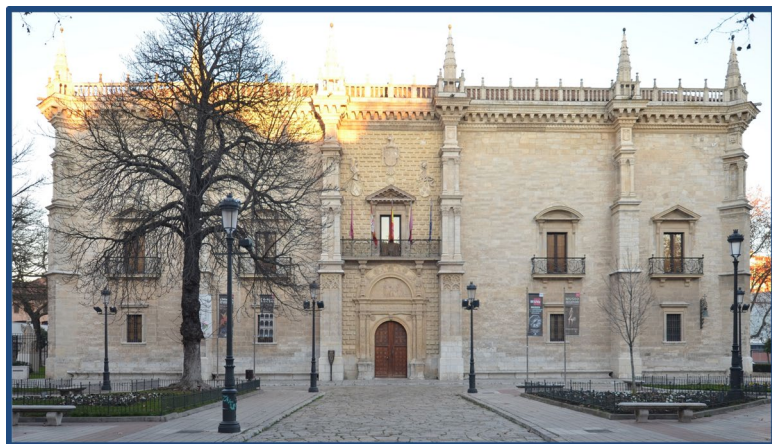
Figura 3.9.- Fachada Colegio Santa Cruz de Valladolid. (2014)
