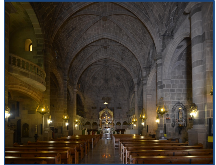
Figura 1.60.- Vista del interior de la iglesia de Castalla, con vistas a la cabecera donde podemos ver la cabecera mediante acabado ochavado. (2020)
