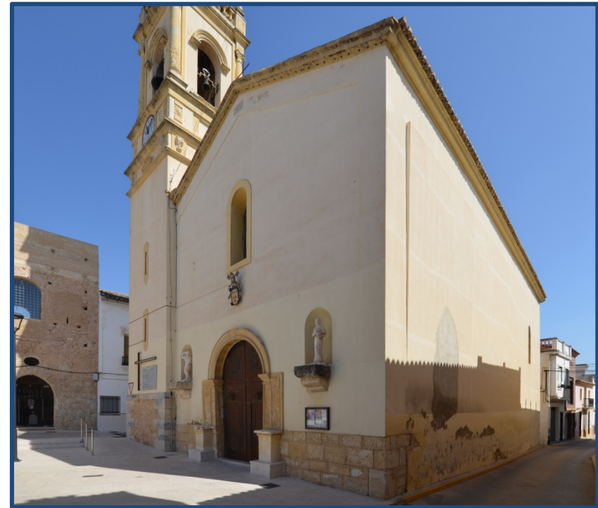
Figura 1.54- Vista de la fachada de la Iglesia de Massalavés con el campanario añadido a principios del siglo XX. (2016).
