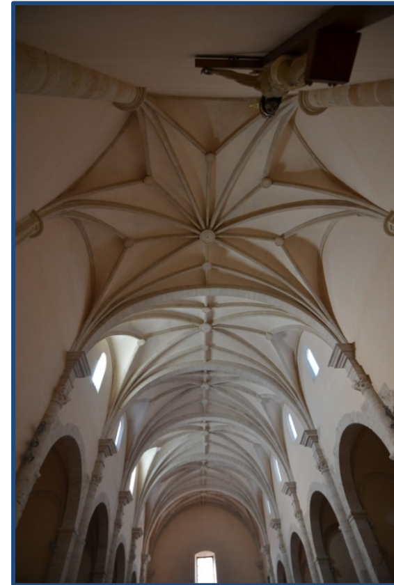
Figura 4.2.- Vista interior de la cubrición de la nave principal, con la cubrición del ábside en primer plano, y la disposición de columnas y capiteles a lo largo de la misma. (2018)
