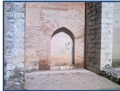
Figura 4.37, 4.38, 4.39 y 4.40.- Vistas del interior de San Roc de Ternils, con la techumbre de madera sobre los arcos góticos, y arriba dos puertas de salida. Podemos observar en la de la derecha, el arco apuntado realizado en ladrillo. Abajo derecha podemos ver el acabado del la cornisa. (2010)
