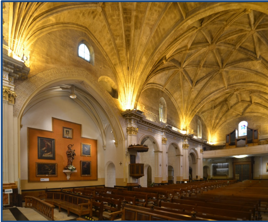
Figura 4.272- vista interior desde el crucero hacia las capillas laterales del lado del Evangelio de la iglesia de Santa María de Ontinyent. (2020).
