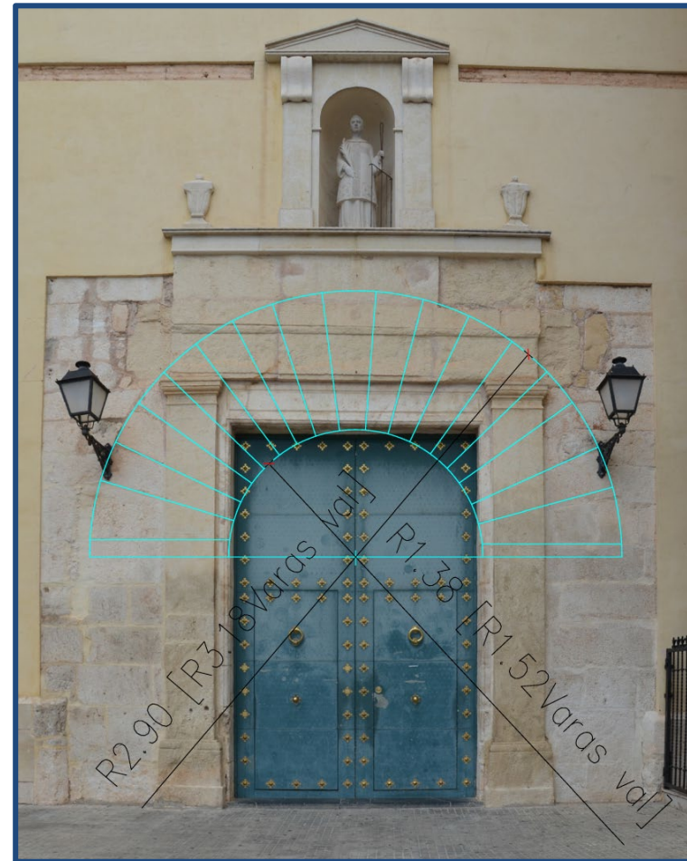
Figura 5.40- Fotografía rectificada mediante el programa ASRIX, de la fachada de la Iglesia de San Lorenzo de Alberic, donde tras la portada vemos el arco referenciado en la anterior imagen, y su medición en metros y varas valencianas... (2013)
