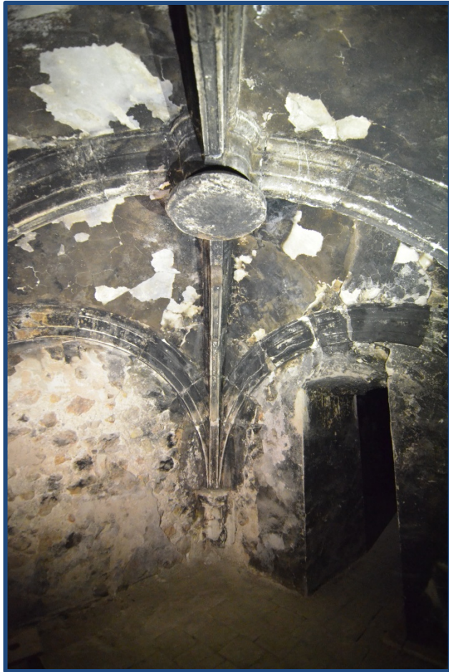
Figura 4.250- Vista de la parte superior de la primera capilla lateral del lado de la Epístola en la Iglesia de San Bartolomé de Vallada, donde vemos las bóvedas de cruceira realizadas por Gamieta y hoy ocultas. (2020).
