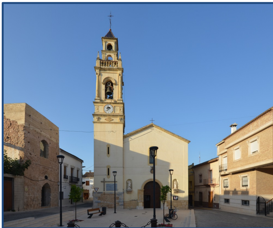
Figura 4.177- Fachada principal de la iglesia de Massalavés, con el campanario levantado a principios del siglo XX a la izquierda. (2017)
