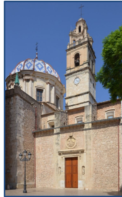
Figura 4.41.- Vista Exterior de la actual Iglesia de Nuestra Señora de la Asunción de Carcaixent, desde la plaza con vistas a la cúpula y la torre campanario. Sobre la portada podemos ver los contrafuertes originales de la iglesia construida en el siglo XVI, y la cual estamos investigando. (2016)
