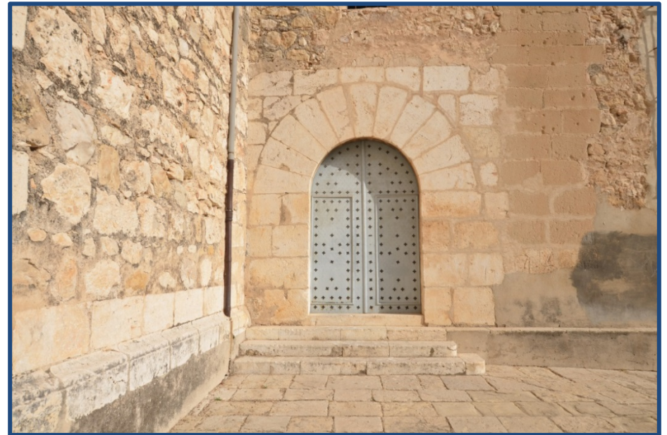
Figura 4.113- Vista del acceso lateral a la iglesia, l la puerta “ dels grisons ”. (2016)
