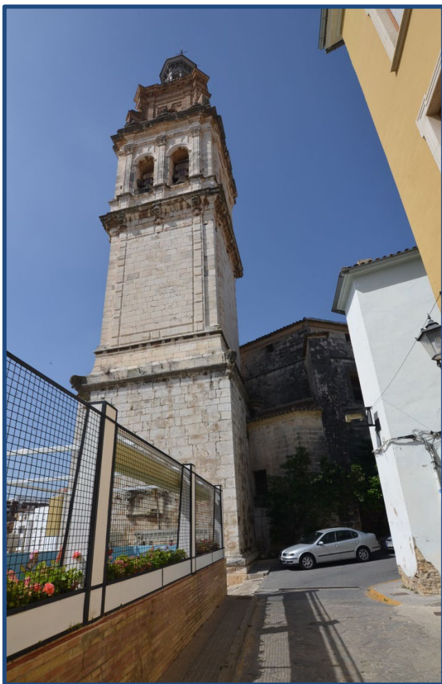
Figura 4.270- Vista del campanario actual, situado junto a la cabecera de la iglesia de Santa María de Ontinyent. (2020).
