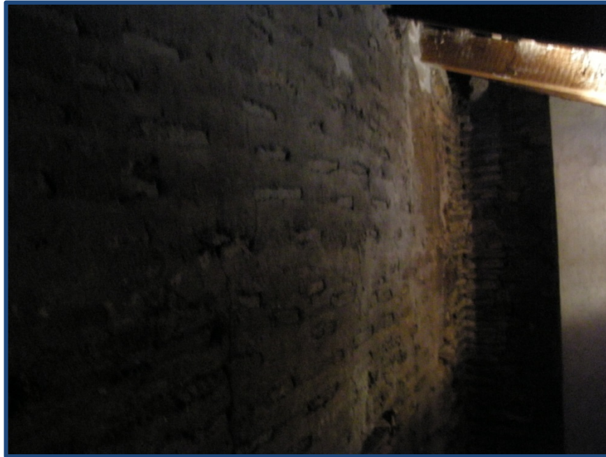
Figura 5.114. Vista del muro de ladrillo que separa la iglesia de la capilla de la comunión, y donde están apoyadas las vigas de madera que soportan la cubierta sobre las bóvedas. (2013)
