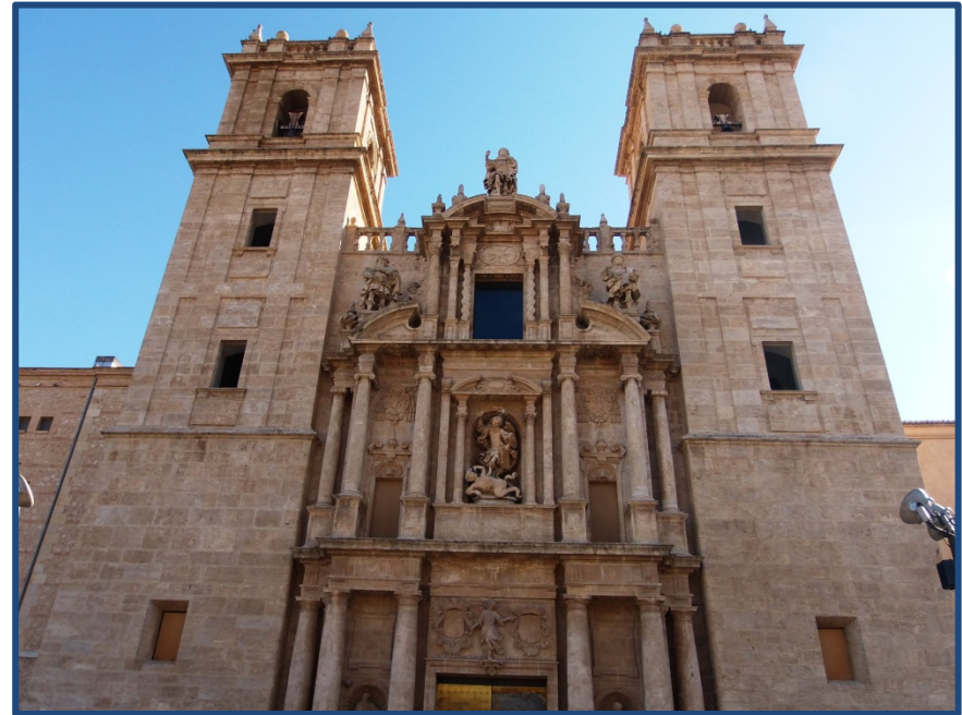
Figura 6.5- Vista de la fachada del Monasterio de San Miguel de los Reyes de Valencia. (2013)
