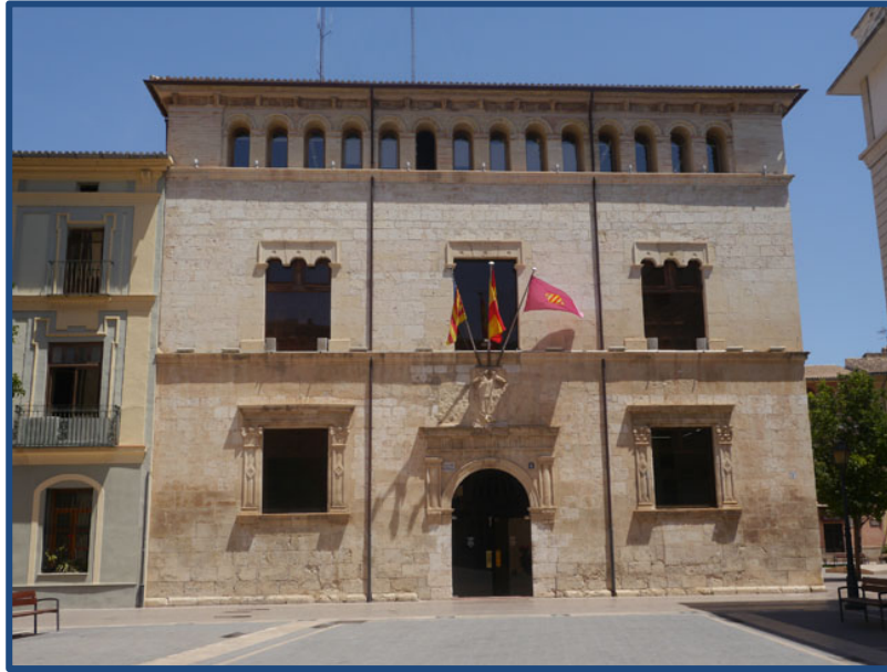
Figura 2.83. Fachada de la casa de la villa de Alzira, con claros elementos del nuevo lenguaje renacentista. Toda aparece labrada en piedra, excepto el último piso que se añadió, y está realizado de ladrillo. (2018).
