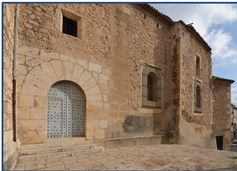
Figura 4.125- Puerta de entrada por el Surestes de la Iglesia. Puerta “dels Grisons”. (2016)
