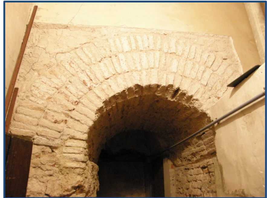
Figura 5.46- Arco de entrada a la escalera de subida al campanario. (2012)
