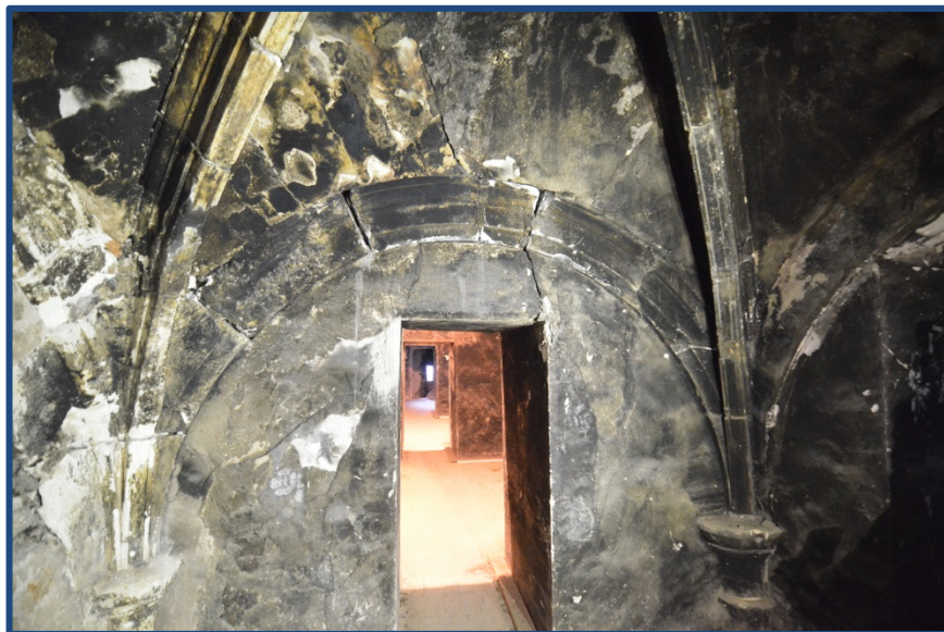
Figura 4.252- Vista de la parte superior de la segunda capilla lateral del lado de la Epístola en la Iglesia de San Bartolomé de Vallada, donde vemos los arranques de los nervios de las bóvedas de crucería y el pasillo que nos comunica toda ésta parte superior. (2020).
