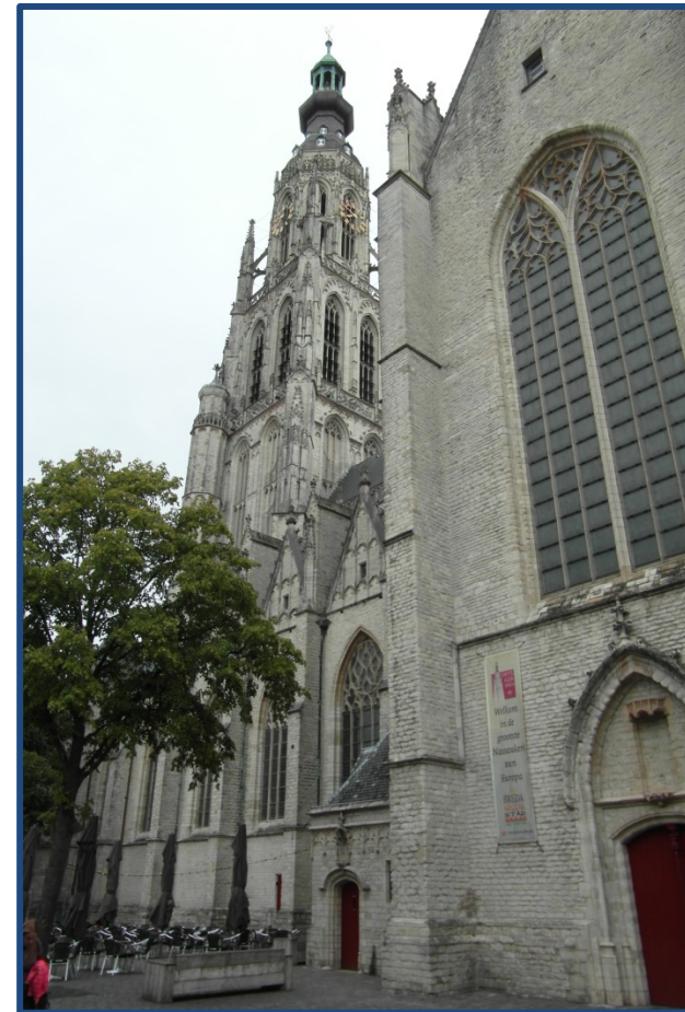
Figura 6.2.- Vista exterior de la Colegiata de Breda, con la torre campanario y acceso lateral a la misma. (2015)
