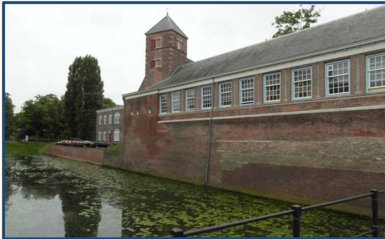
Figura 3.86- Detalle lateral puerta entrada Palacio de Breda, donde podemos observar las defensas realizadas así como el foso que rodea el Palacio. (2017)
