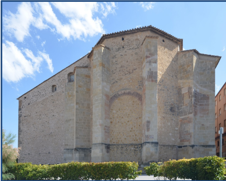
Figura 4.291.- Vista del exterior de la Iglesia de Nuestra Señora de la Asunción de Castalla, desde el lado Este, con el exterior de la cabecera en primer plano. (2020)
