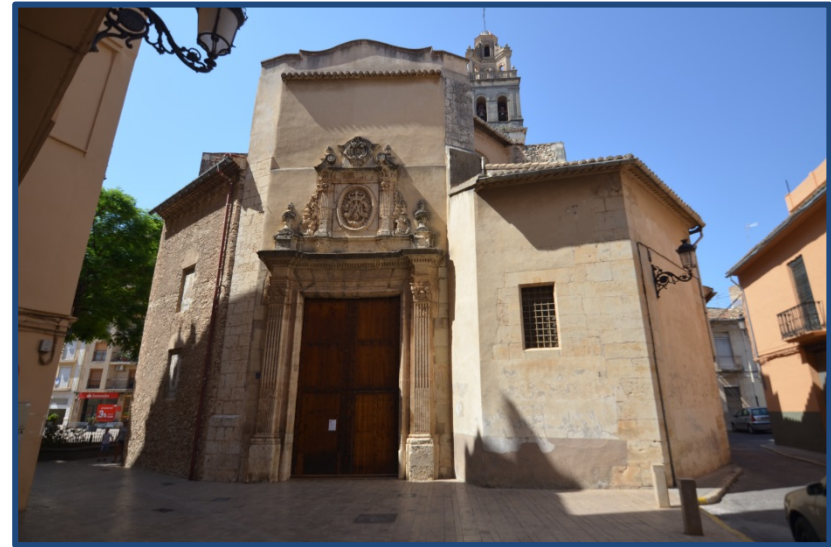
Figura 4.34.- Puerta de entrada situada al Nordeste, que coincide con la antigua cabecera de la iglesia, tanto gótica como la ampliación realizada con posterioridad entre los años 1551-1570, realizada por los maestros Guillem Torres y Domènec Gamieta. (2016)
