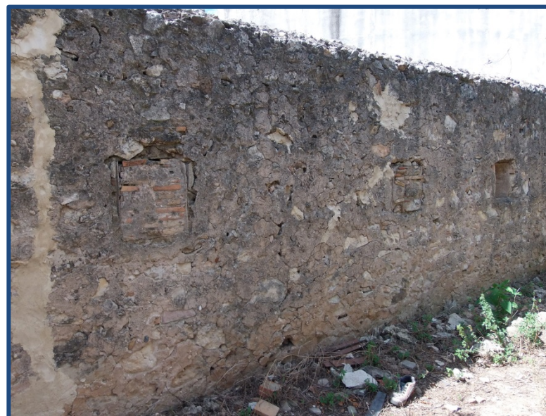
Figura 3.136- Foto de restos de murallas de Alberic que todavía podemos ver en algunas de las traseras de las viviendas actuales. Podemos ver que no se trata de muros defensivos en sí, realizadas con pequeños trozos de piedras y cantos rodados, y con una sección de unos 25-30 cm. (2013)
