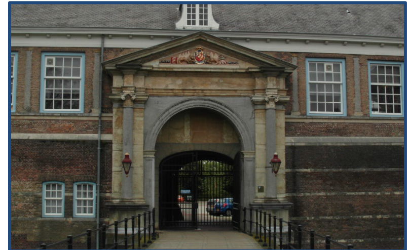
Figura 3.87- Detalle puerta entrada Palacio de Breda, a la que se accede sobre un puente para salvar el foso defensivo. (2017)
