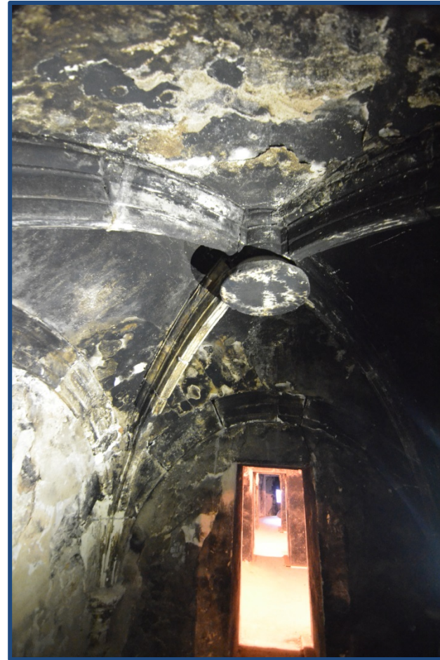
Figura 4.251- Vista de la parte superior de la segunda capilla lateral del lado de la Epístola en la Iglesia de San Bartolomé de Vallada, donde vemos las bóvedas de cruceira y el pasillo que nos comunica toda ésta parte superior. (2020).
