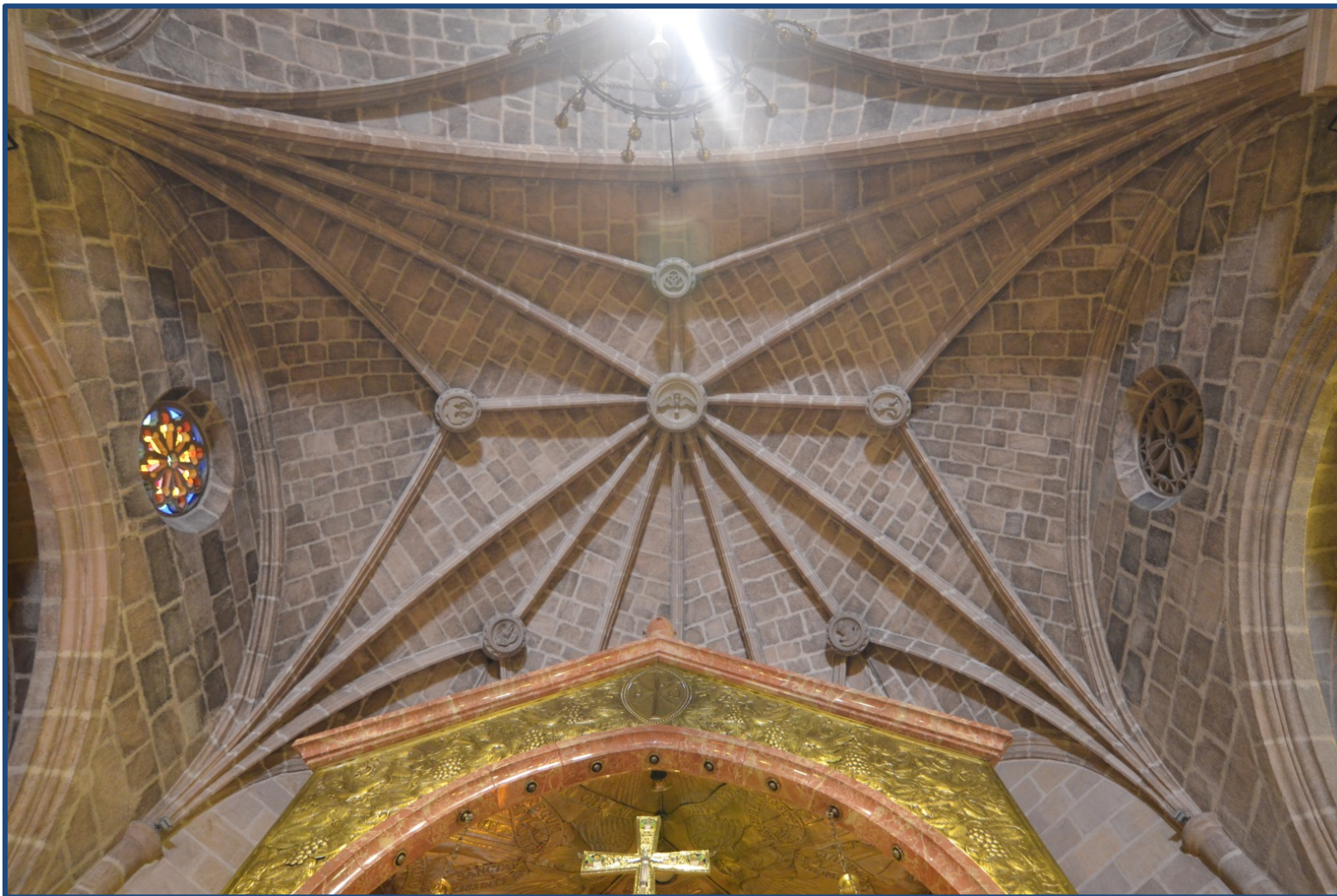
Figura 4.293- Vista de la bóveda de crucería, de la cabecera de la Iglesia de Nuestra Señora de la Asunción de Castalla. (2020)
