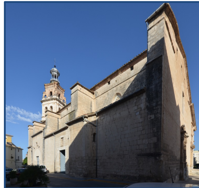
Figura 4.276- Vista exterior desde la plaza de la Vila, de la Iglesia de Santa María de Ontinyent (2020).
