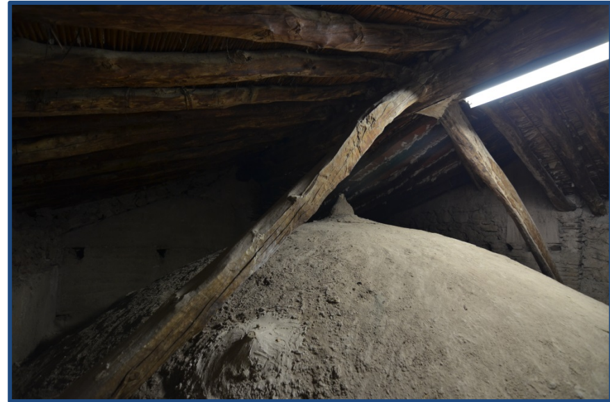
Figura 4.219- Vista del interior de la cubierta de San Salvador de Cocentaina, con la vigería de madera. (2017).
