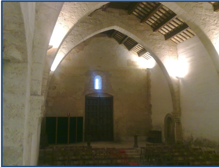
Figura 4.36.- Vistas del interior de San Roc de Ternils, con la techumbre de madera sobre los arcos góticos, al fondo vemos la puerta de entrada con una ventana sobre ella. A la derecha lo que parece una puerta de acceso a la sacristía, hoy inexistente. (2010)
