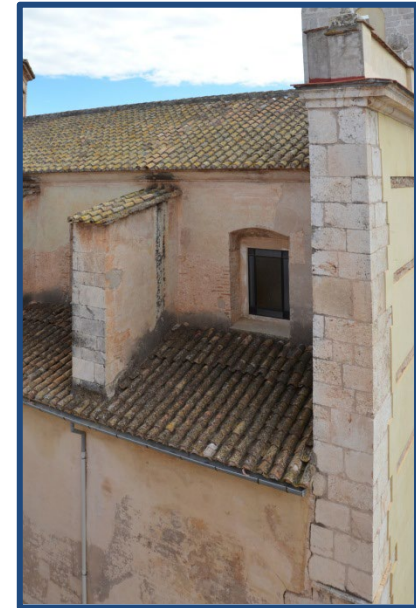
Figura 5.115. Vista de la parte de la fachada y de los contrafuertes, donde vemos la utilización de piedra en las esquinas. (2013)
