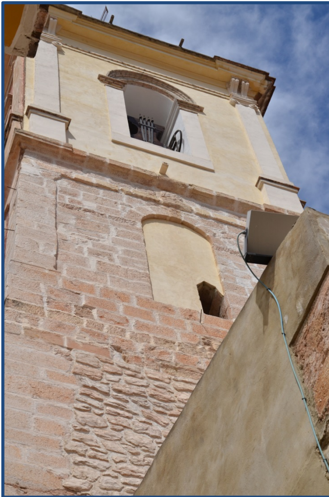
Figura 5.47- Vista del campanario por su cara sureste, donde podemos contemplar el antiguo cuerpo de campanas en el tramo tercero. Sobre las dos ventanas existente en el plano del siglo XVIII. (2013)
