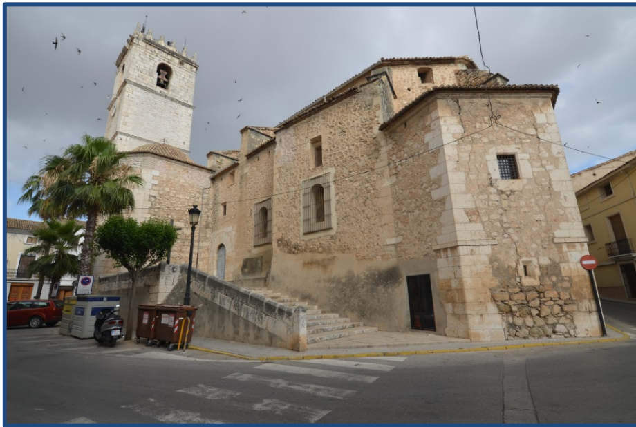
Figura 4.112- Vista de la Iglesia de Santa María Magdalena de L'Olleria, donde podemos ver la capilla adyacente a la cabecera del templo, y la escalera de acceso a la puerta “ dels grisons ”, así como los contrafuertes en la parte superior. (2016)
