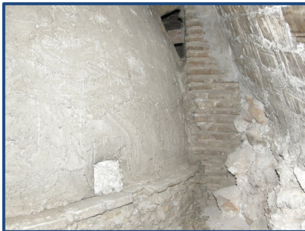
Figura 5.102 y 5.103. Arriba vista de la bóveda de la zona de paso entre la iglesia y la capilla de la comunión, y abajo extradós de dicha bóveda. (2013)
