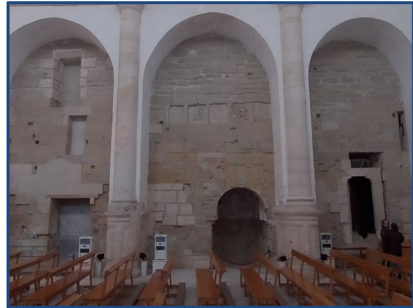
Figura 5.32.- Interior de la Iglesia de San Juan de Almería, con los restos a la vista de su pasado como mezquita mayor de Almería. En el centro podemos observar el lugar dedicado a la antigua qibla.
