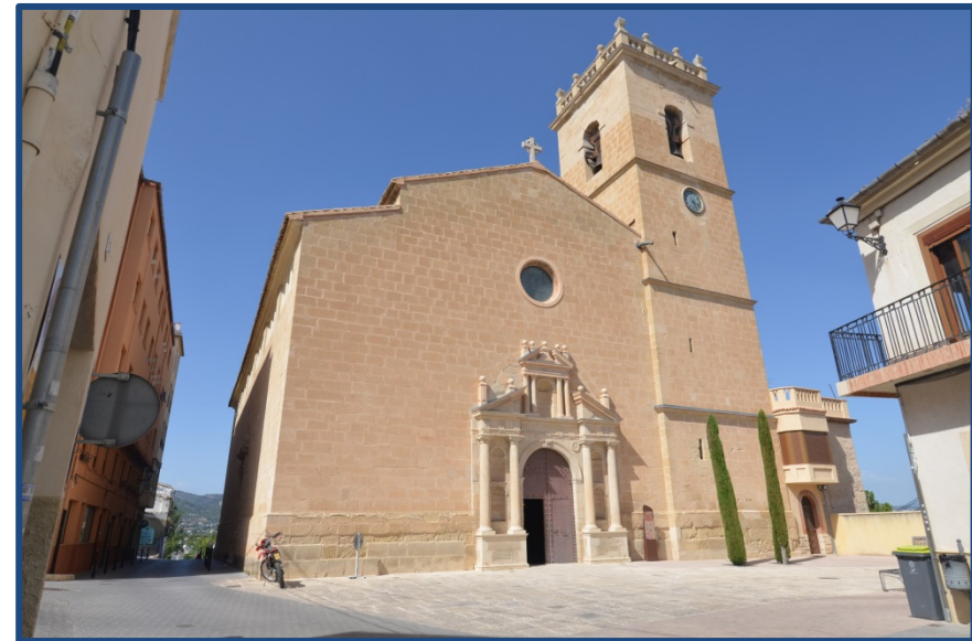
Figura 4.283.- Vista de la portada de la Iglesia de Nuestra Señora de la Asunción de Castalla, vista desde la Calle Mayor de la población. (2020)
