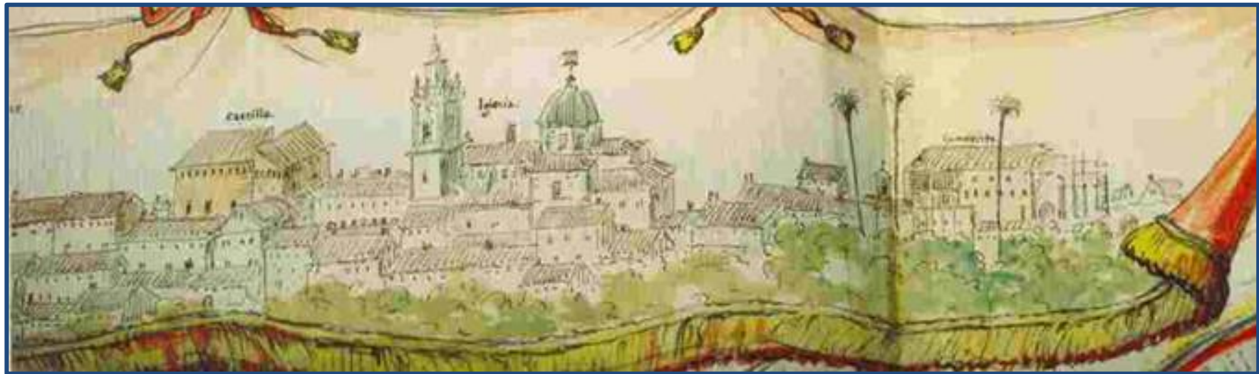
Figura 5.16.- Vista de población de Alberic, tomada durante la primera década del siglo XVIII. Vemos la iglesia con la cúpula realizada, así como en la parte derecha el Convento de Nuestra Señora de Los Ángeles que está en construcción. Imagen extraída de: (Giménez Chornet, 2017)
