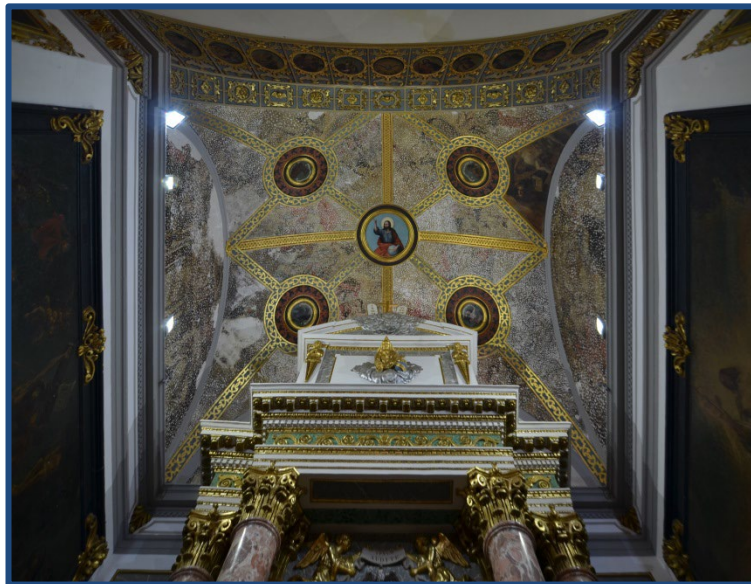
Figura 6.20. Vista de la bóveda vaída, que cubre el presbiterio, en la iglesia del Salvador de Cocentaina. (2017)
