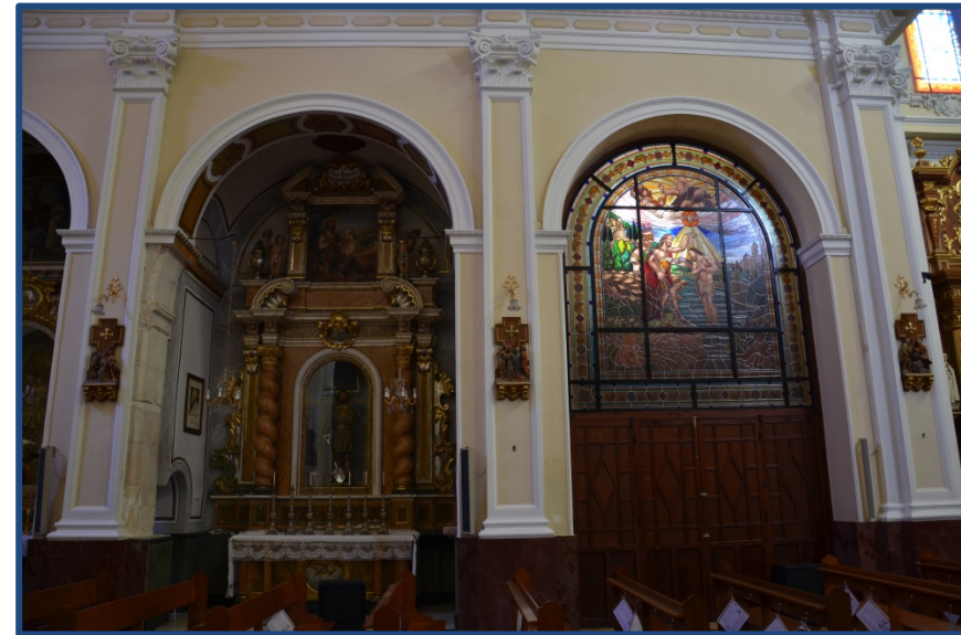
Figura 5.36.- Vista de la capilla de San Isidro, a la izquierda, con la pilastra descubierta en las obras realizadas, y que ha quedado como testigo del templo que se construyó en el siglo XVI. (2013)
