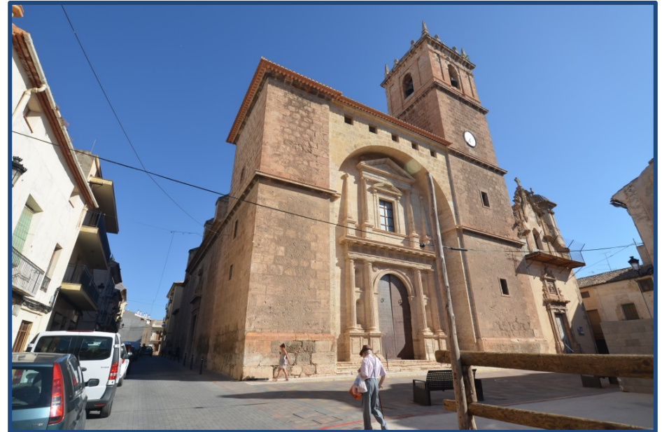
Figura 4.12.- Vista de la fachada de la Iglesia de Ayora, y de la calle adyacente, ejemplo de calle de casco antiguo e histórico de la población. (2018)
