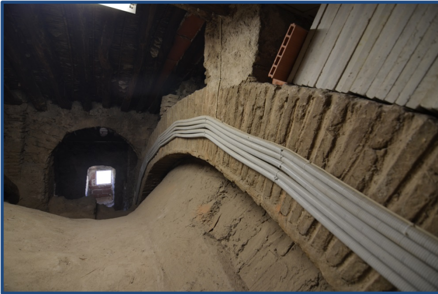
Figura 4.220- Vista del interior de la cubierta de San Salvador de Cocentaina, con el arco de ladrillo macizo que nos separa el altar de la nave principal. (2017).
