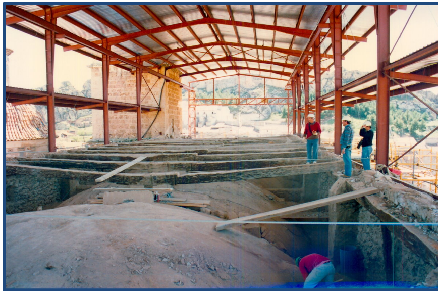
Figura 4.10.- Vista de la ejecución de las obras de reforma de la cubierta, con la sobrecubierta realizada para proteger de las inclemencias del tiempo, y a la vista las bóvedas y soportes de madera de la nave central. Fotografía obtenida de la web de Consellería. (2017)
