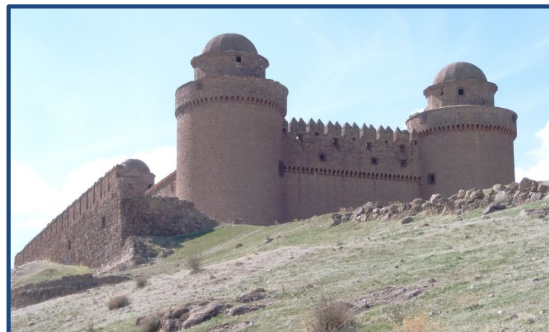
Figura 3.34.- Vista del Castillo-Palacio de la Calahorra visto desde el exterior. (2014).
