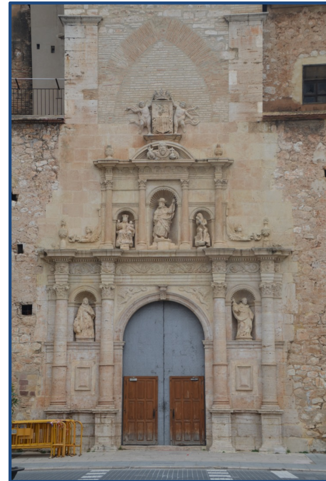
Figura 4.161- Vista entrada principal iglesia de Sant Jaume de Algemés donde podemos ver la portada renacentista realizada por Domènec Gamieta. (2020)
