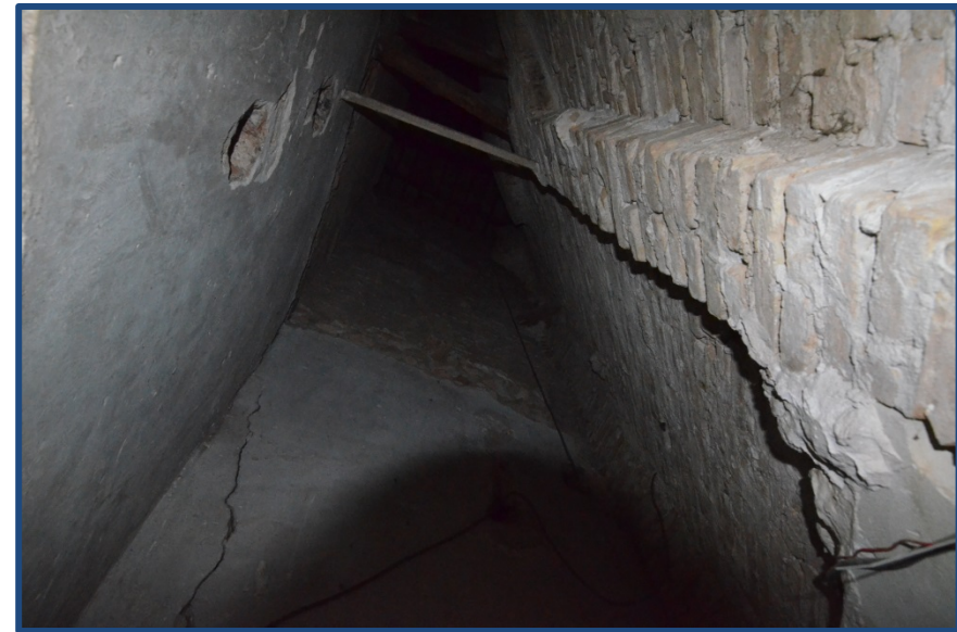
Figura 4.184- Vista de la zona del trasaltar, en concreto el espacio dedicado a trastero, y que en su zona superior podemos contemplar los diferentes elementos constructivos para realizar el ochavamiento de la cabecera. (2016)
