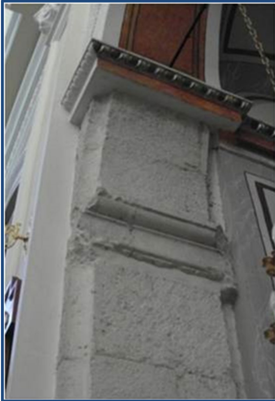
Figura 1.3.- Vista soporte izquierdo entrada capilla de S. Isidro en la Iglesia de S. Lorenzo de Alberic. Elemento correspondiente al templo hoy desaparecido. (2010).
