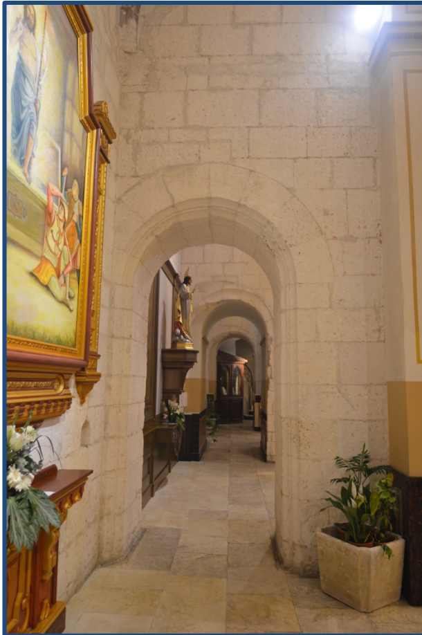
Figura 4.265- Vista de las capillas laterales y del pasillo que y arcos que las comunican, de la Iglesia de Santa María de Ontinyent, realizados en la ampliación del maestro Joan de Batea, para ampliar la anchura de la iglesia. (2020).
