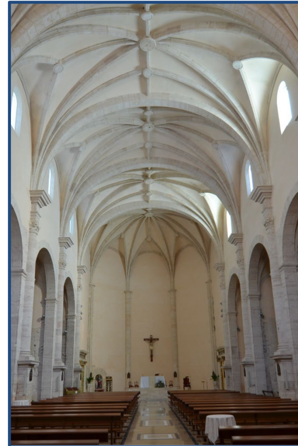
Figura 4.7.- Vista del presbiterio, que no está elevado sobre el suelo de la nave principal, solamente está elevado la mesa central, y donde podemos ver la diferencia de ornamentación de los soportes. (2018)
