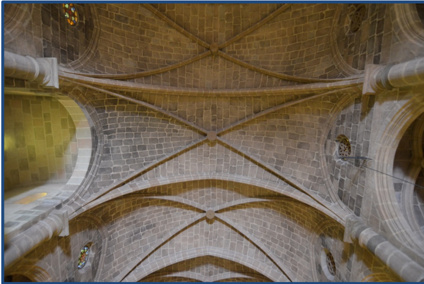
Figura 4.287.- Vista de las bóvedas de crucería de la nave de la Iglesia de Nuestra Señora de la Asunción de Castalla. (2020)
