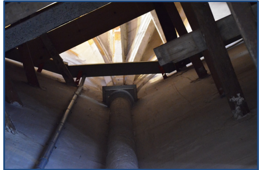
Figura 4.83 - Detalle de la parte superior del soporte, donde vemos el capital desde donde parten los nervios que sujetan la plementería, y que forman la bóveda estrellada de la cabecera del templo. (2016)
