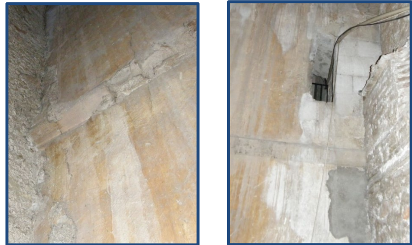
Figura 5.43 y 5.44- Molduras hoy ocultas, en la pared lateral del campanario, vistas desde otro ángulo. (2012)
