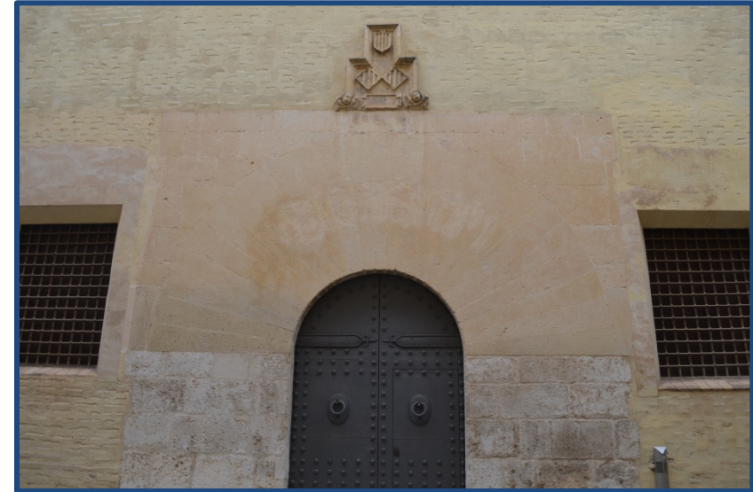
Figura 3.134- Vista de la fachada del Almudín de Xàtiva, con la puerta con grandes dovelas y con el cerramiento realizado con tapia valenciana, así como tres escudos reales situados en la parte superior. La imagen está tomada tras la restauración realizada por los Arquitectos Grassi i Portaceli. (2016)
