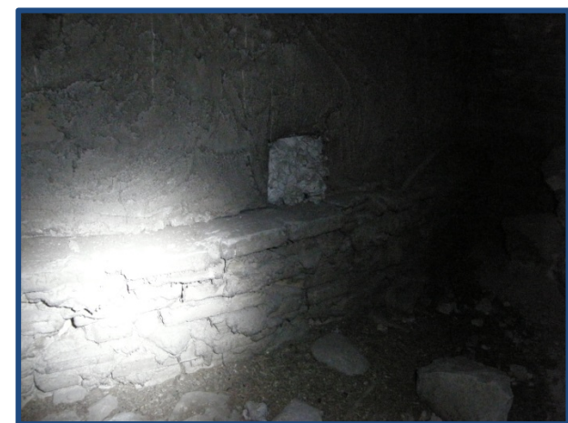
Figura 5.104 y 5.105. Arriba vista del extradós de la bóveda, y cubrición de la misma mediante vuelta de ladrillos. Abajo, parte inferior del extradós de la bóveda. (2013)
