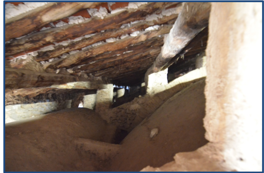
Figura 4.221- Vista del interior de la cubierta de San Salvador de Cocentaina, con las bóvedas de la nave central y las de las capillas laterales, bajo la cubierta de madera (2017).
