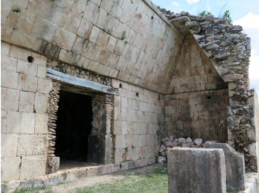
Figura 13. Bóveda del cuarto oeste de la Casa de las Tortugas de Uxmal (Fotografía de Laura Gilabert).
