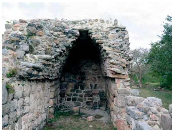
Figura 4. Bóveda del Edificio CA-6 en el Grupo Ah Canul de Oxkintok (Fotografía de Laura Gilabert).
