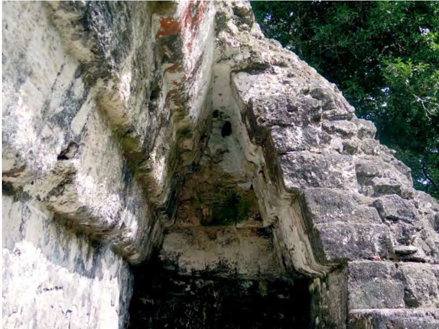
Figura 10. Bóveda escalonada con dovelas Petén en el Palacio de las Ventanas de Tikal (Fotografía de Laura Gilabert).
