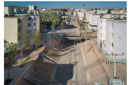
Fig 93.Estado actual del canal de aguas residuales. Fotografía de Jaime Navarro. Obtenido de http://rozanamontiel.com/proyectos/fresnillo/
