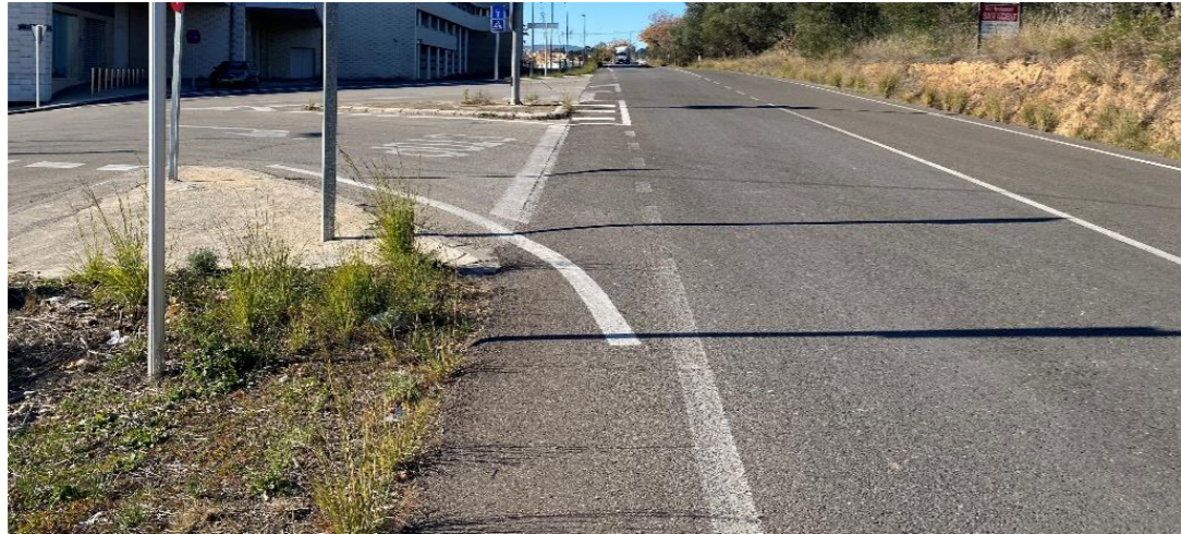
FIGURA 30. ESTADO ACTUAL ADECUADO CV-650 (FUENTE: PROPIA)
