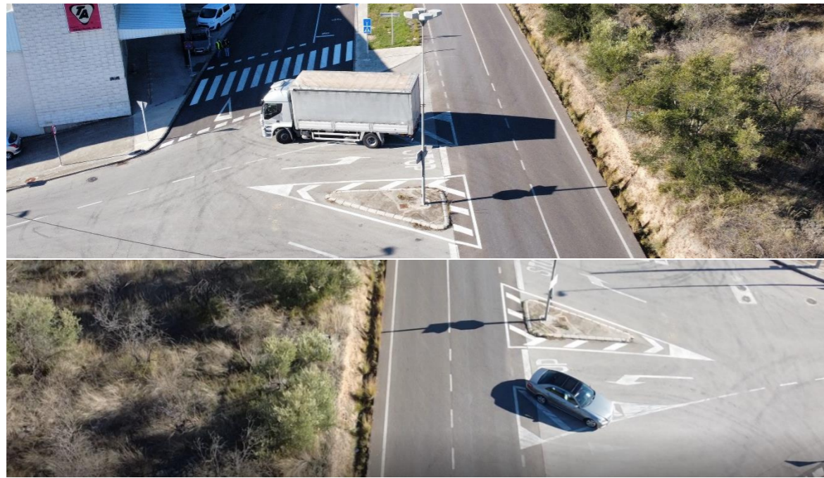
FIGURA 38. PRINCIPALES PROBLEMAS RELACIONADOS CON LA SEÑALIZACIÓN HORIZONTAL (FUENTE: PROPIA DRON)
