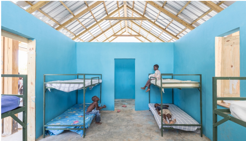
Fig. 42. Imagen dormitorio. Fuente: Marco Cappelletti, Plataforma Arquitectura .
