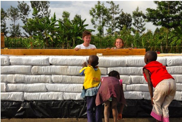
Fig. 28 y 29. Construcción con sacos de tierra y procesamiento de la madera. Fuente: Odysseas Mourtzouchos, Plataforma Arquitectura .
