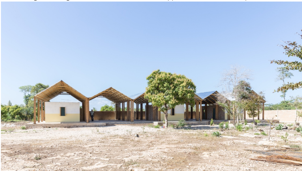
Fig. 39. Imagen del conjunto. Fuente: Marco Cappelletti, Plataforma Arquitectura .
