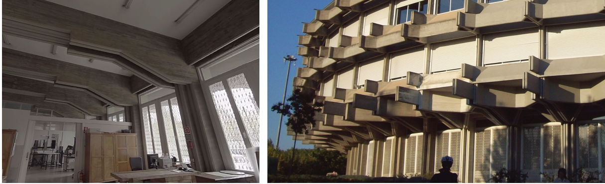
Figura 96. Izq. Pilar de planta baja y regruesamiento de la viga en su parte interior [Yorokobu, 2016]
