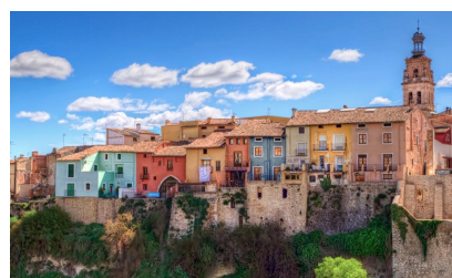
Fig. 27. Vista de las casas que se encuentran en los restos de la muralla del barrio de la Vila, Ontinyent
