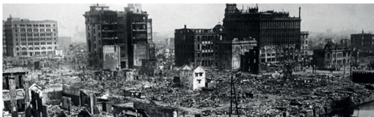
Figura 92: Destrucción tras el Gran Terremoto de Kanto
