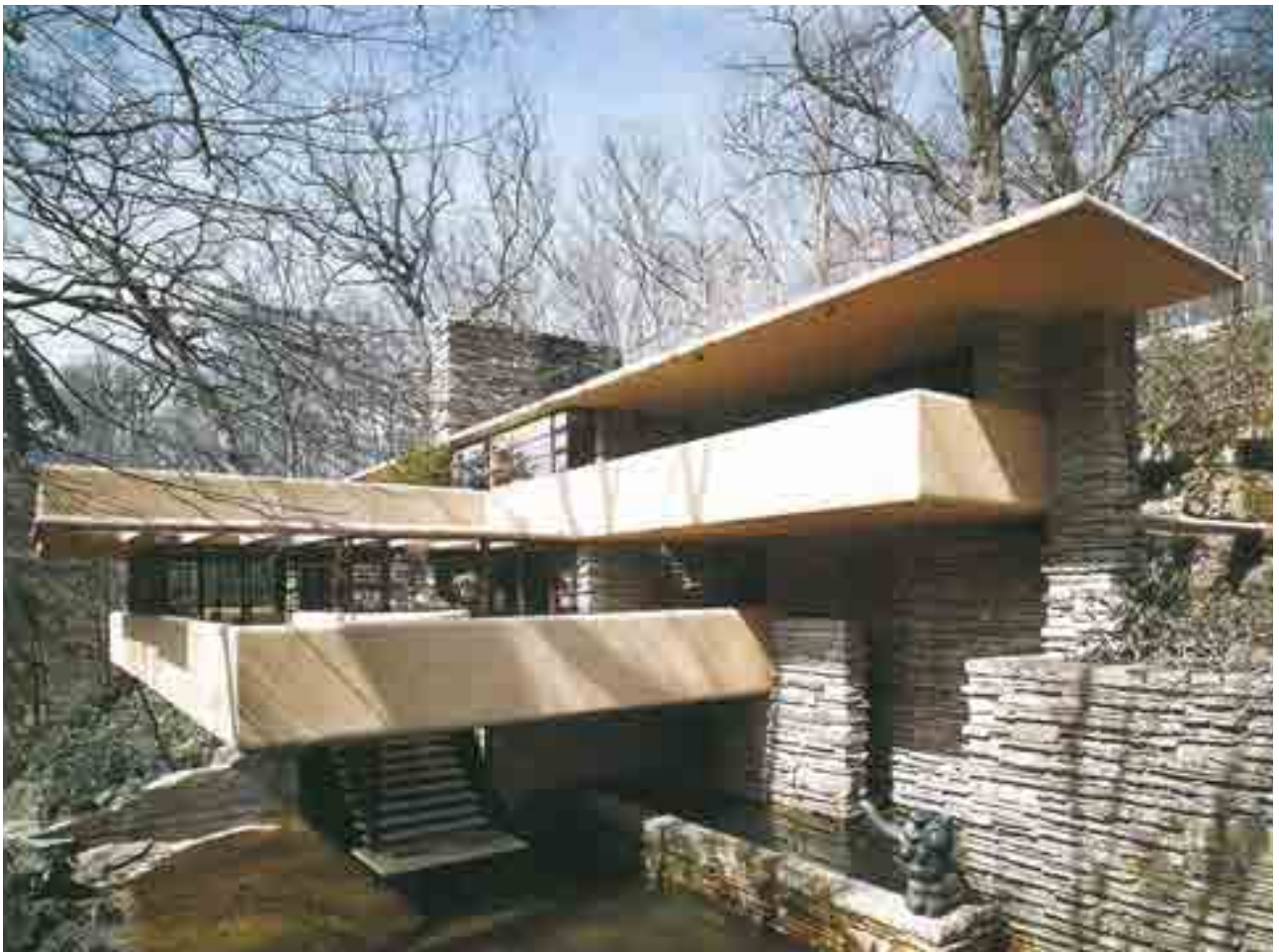
Frank Lloyd Wright, Fallingwater . Bear Run (Pennsylvania), 1934-37. Cubierta del patio central.
