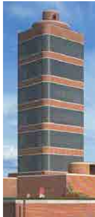
Figuras 78 a 80 Frank Lloyd Wright, Harold Price Tower . Oklahoma, 1952. Secuencia construc- tiva del forjado.
