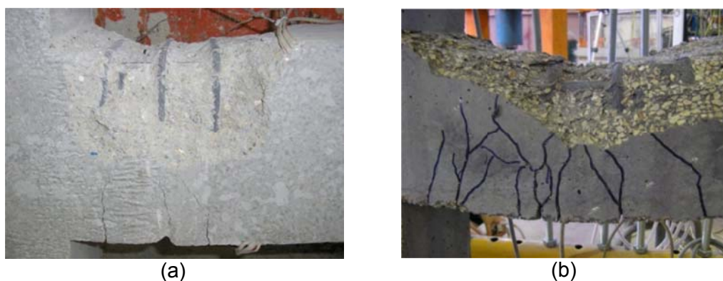
Figura 5.10 Ensayos con nivel de daño 4 (a) N30-15-C3-2-45 y (b) H90-10.5-C3-2-30
