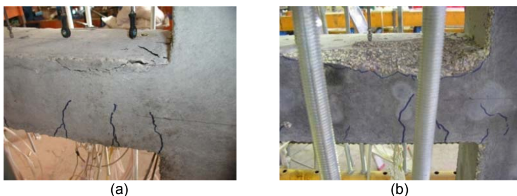
Figura 5.9 Ensayos con nivel de daño 3 (a) N30-10.5-C0-2-30 y (b) H90-10.5-C0-2-15
