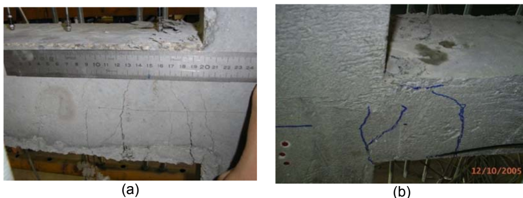
Figura 5.7 Ensayos con nivel de daño 1 (a) N30-10.5-C0-2-00 y (b) H90-10.5-C0-2-00
