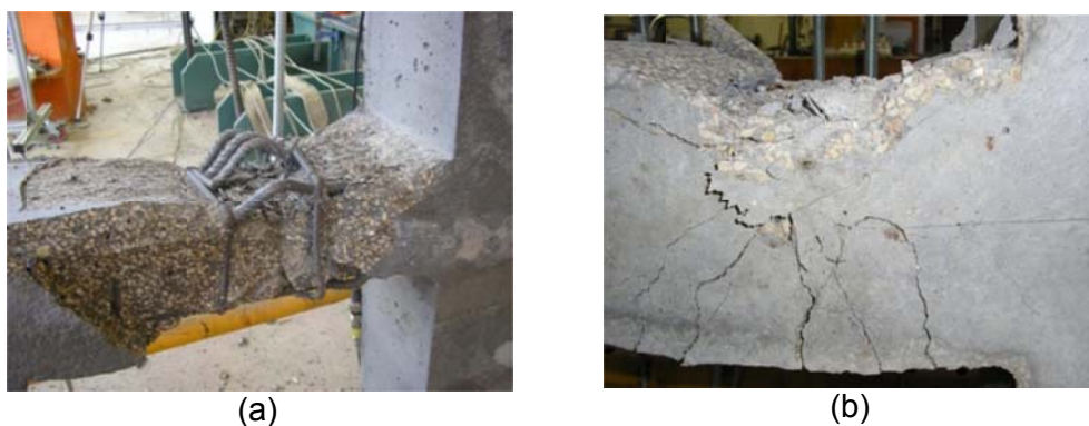
Figura 5.11 Ensayos con nivel de daño 5 (a) H90-10.5-C0-2-45 y (b) H60-10.5-C0-2-30
