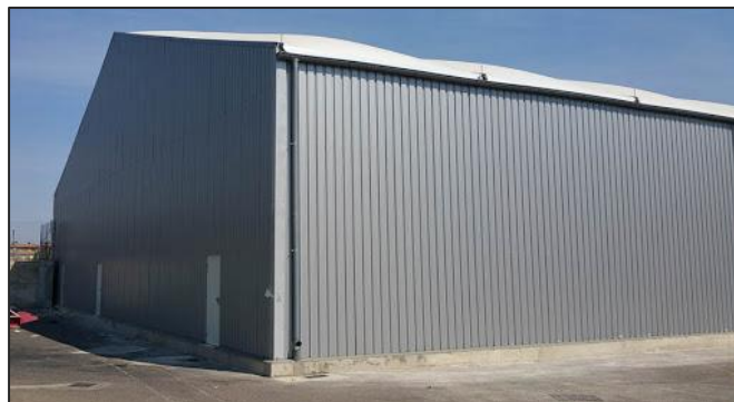
ILUSTRACIÓN 15: CARPA CON CERRAMIENTOS LATERALES DE PANEL SÁNDWICH
