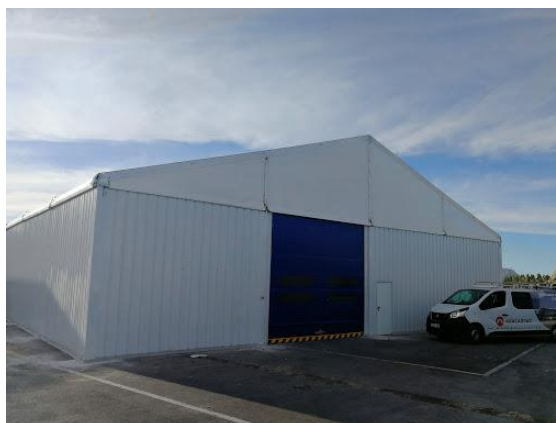
ILUSTRACIÓN 16: CARPA CON CERRAMIENTOS LATERALES DE CHAPA GRECADA
