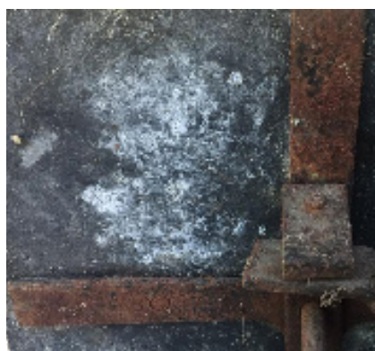
Figura 68. Detalle de carbonatos por debajo de una de las plataformas de pesaje.
