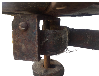
Figura 52. Suciedad y depósitos biológicos sobre uno de los brazos de la obra.
