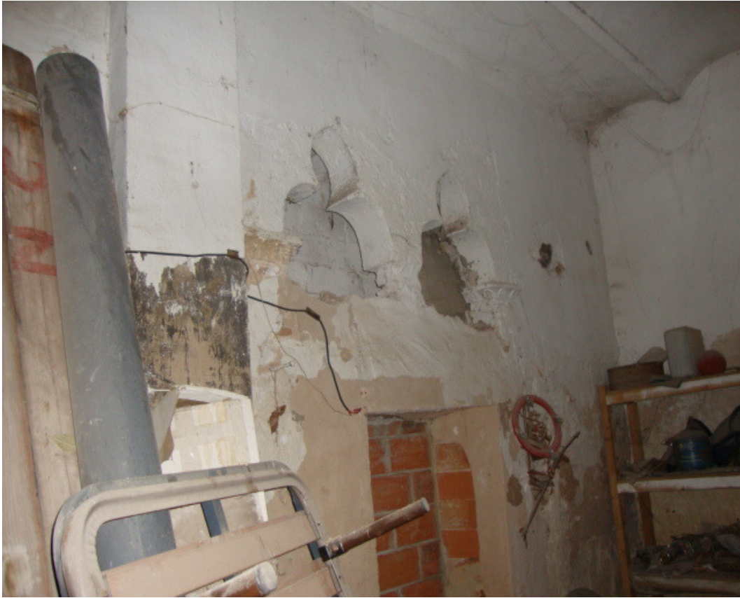
Restos encontrados - ventanas alquería árabe en planta baja
