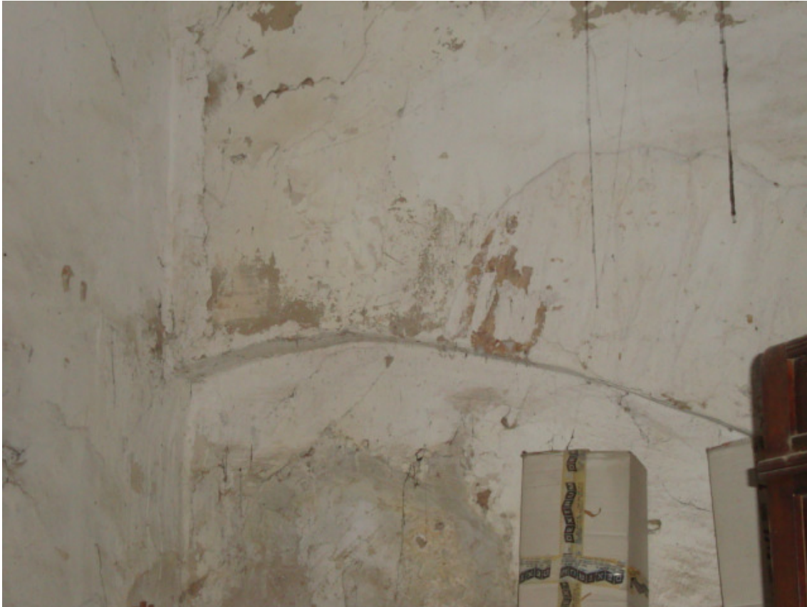
Restos encontrados - medio arco de alquería árabe en planta baja
