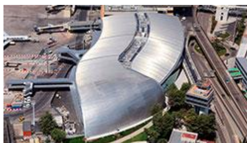
Figura 9 – Vista aérea terminal T2 Fuente:[8]
