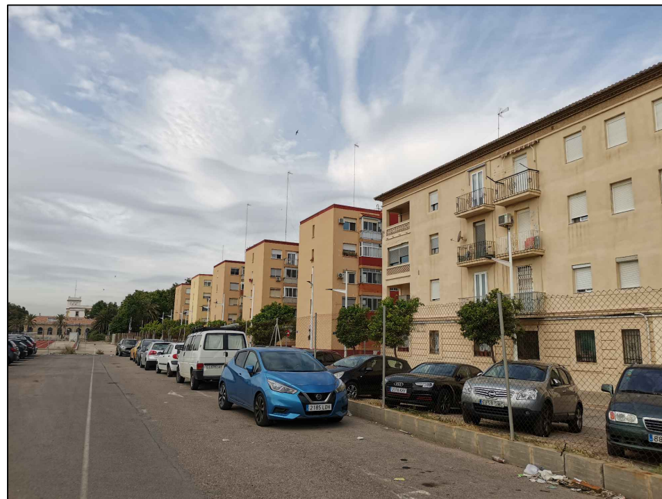
Edificios colindantes al oeste de la parcela
