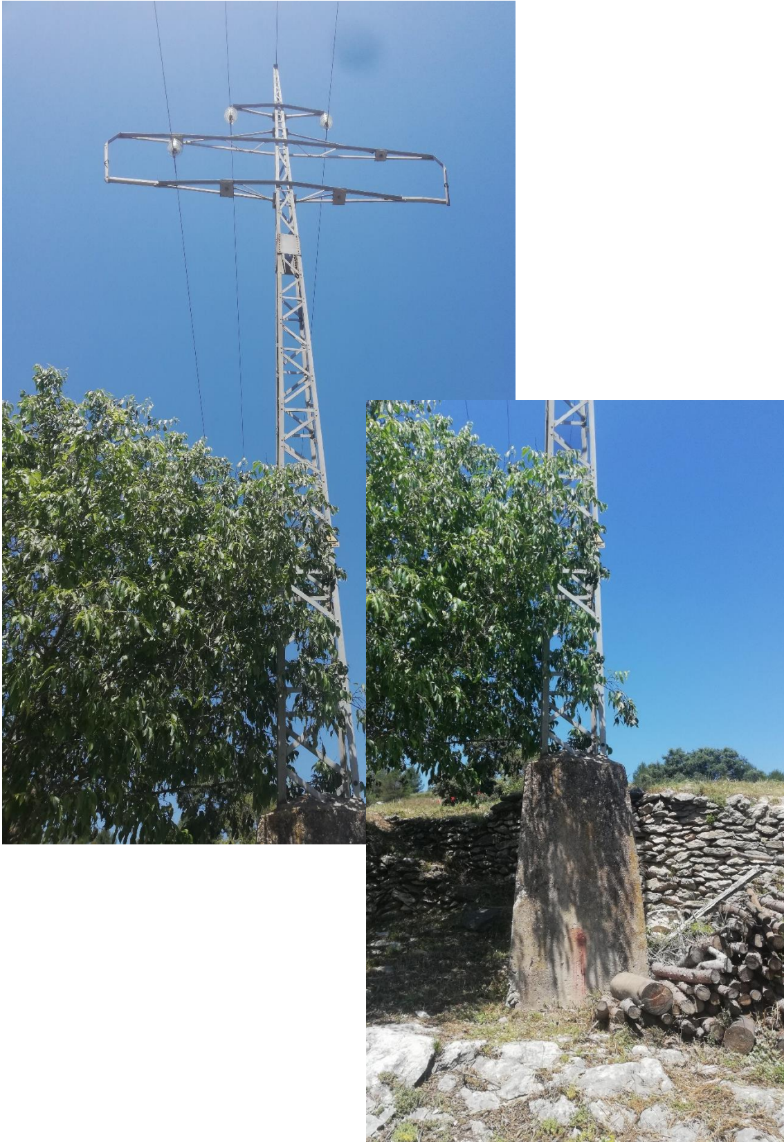
Apoyo Nº 2 del tipo C-500 (R.U) a sustituir y desplazar por una C1000-14E con cruceta CBTA-C1-1500 y cadenas de amarre del tipo bastón de 30 kV. Forrado de puentes, grapas y conexiones para la protección de la avifauna.
