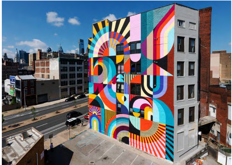
Fachada de servicio de edificio habitacional, existe una administración y notable mantenimiento en el total del edificio, como resultado las intervenciones artísticas son gestionadas evitando el daño de propiedad. (Fuente: Revista: Pexel)
