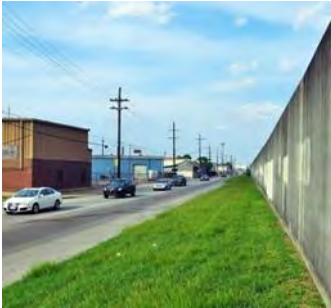
Muros que obstruyen el contacto visual entre los edificios y las calles (Fuente: © Daniel Lobo, vía Flickr).
