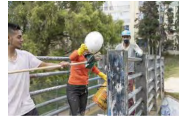
Limpieza de columnas y barandas en puente de "Sendero de colores" (Fuente: Bicistema).
