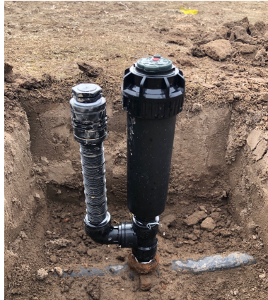
Figura 26. Toma para medir presiones.
