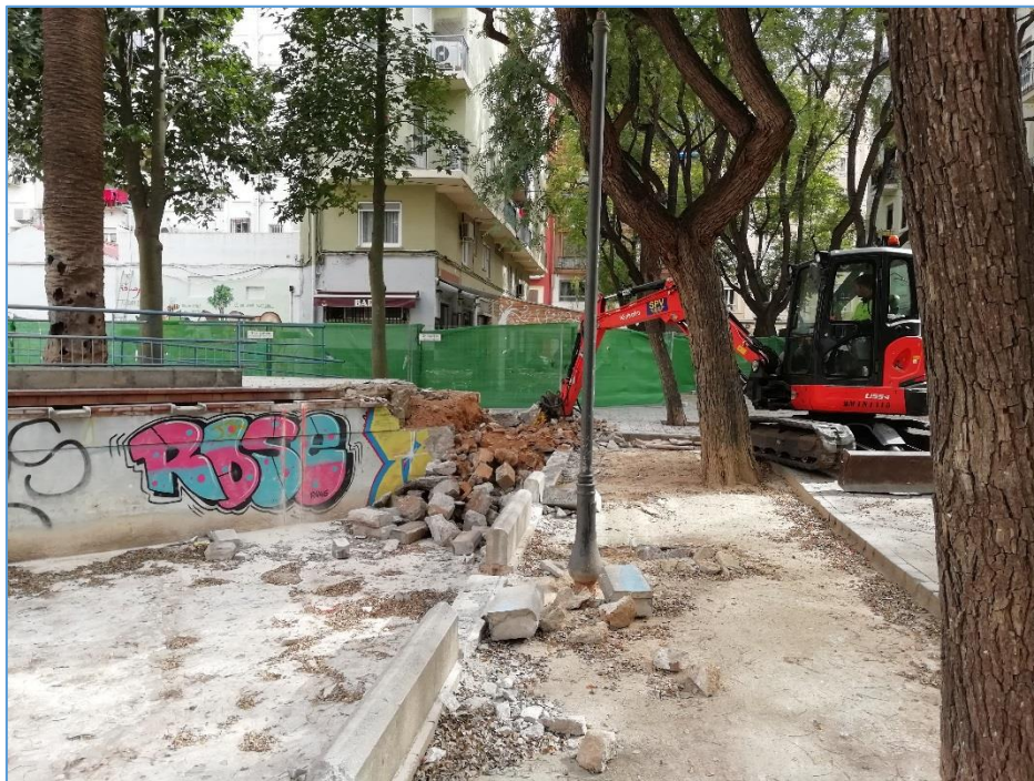
Imagen 16. Retroexcavadora rompiendo elementos constructivos.
