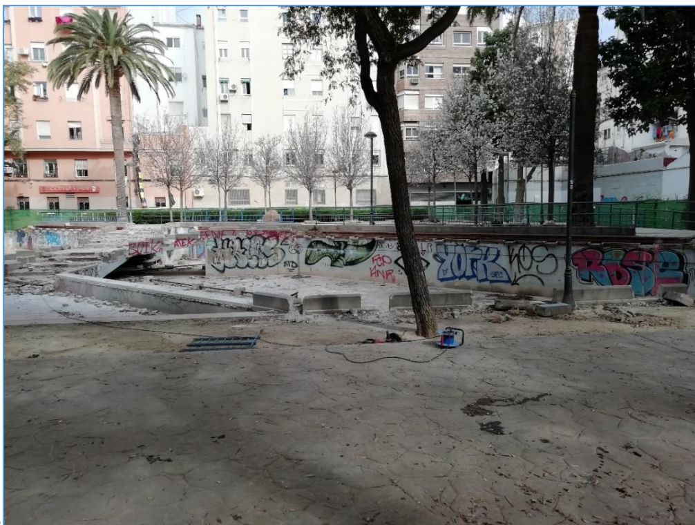
Imagen 6. Demolición de la fuente original.
