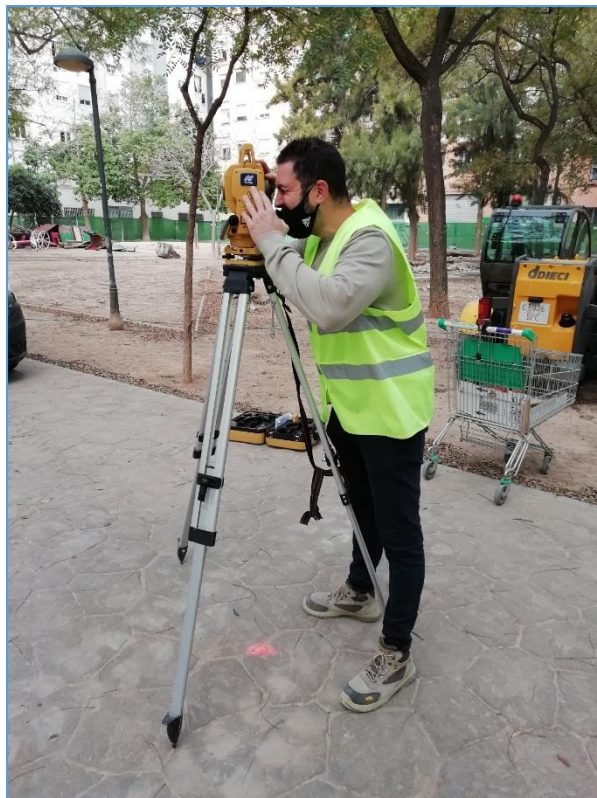
Imagen 10. Topógrafo replanteando puntos sobre el terreno.
