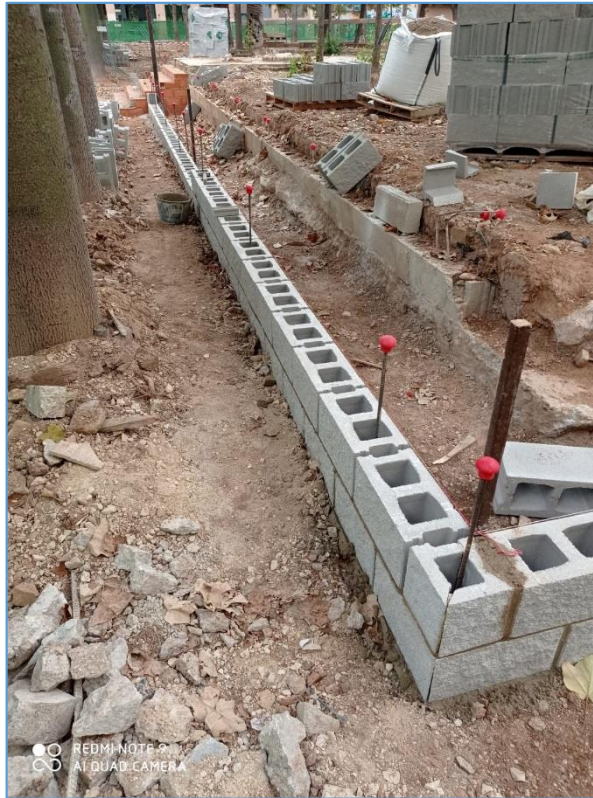
Imagen 11. Varillas de replanteo con seta de protección anti golpe.
