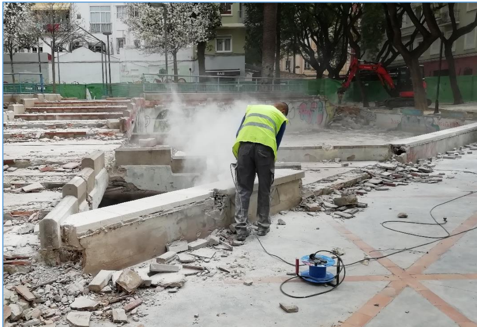
Imagen 14. Corte con radial de elemento constructivo.
