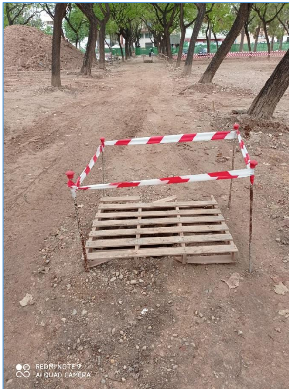
Imagen 12. Cierre y balizamiento de arqueta.
