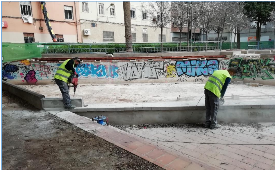
Imagen 15. Dos operarios demoliendo elementos constructivos.
