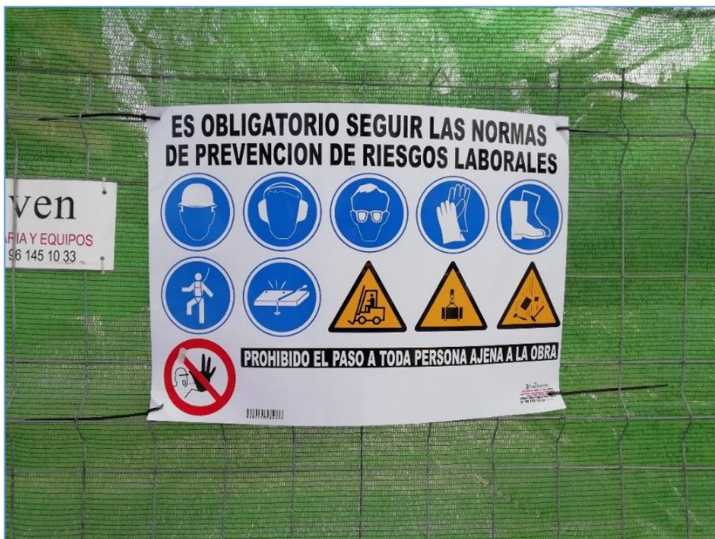
Imagen 2. Señalización de seguridad en acceso a obra.
