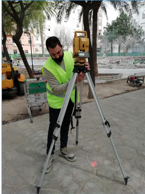
Imagen 9. Topógrafo plantando la estación total para replanteo de puntos.
