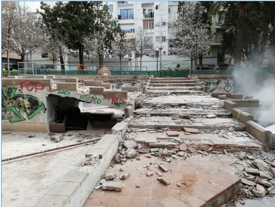
Imagen 17. Demolición de la fuente original.
