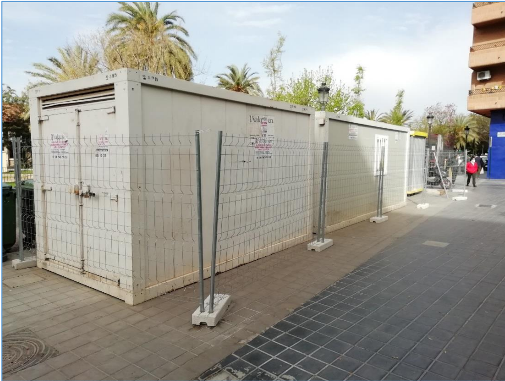
Imagen 3. Caseta de obra.
