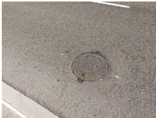
Fotografía 3: Pozo de registro situado en C/Cuadra Morteras
