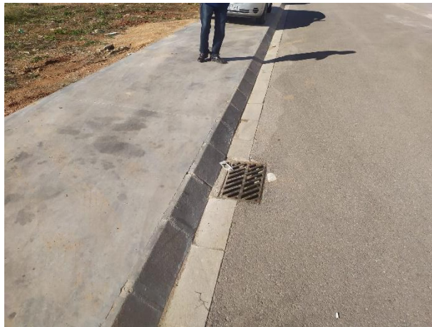
Fotografía 5: Hilera de imbornales situado en C/Polonia dirección C/Cuadra Morteras
