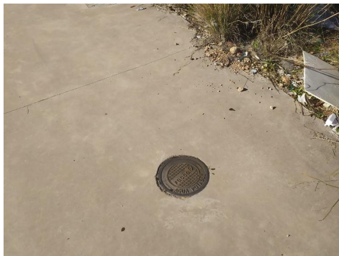
Fotografía 1: Tapa de acceso a la llave de corte situada en la C/ Polonia
