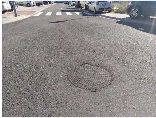
Fotografía 2: Pozo de registro y dirección del agua residual en C/Polonia hacia C/Cuadra Morteras
