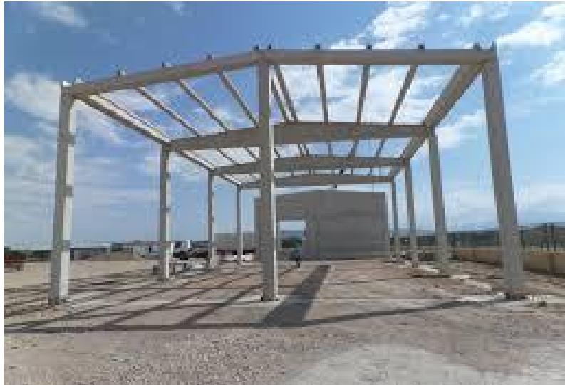
Ilustración 2: Estructura de hormigón prefabricado. (Fuente: Arquestil)
