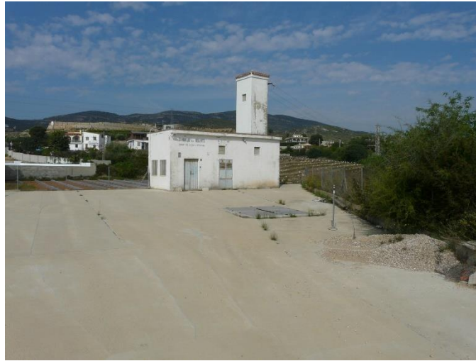
Figura 6: Ubicación pozo del corral (trampilla gris) y caseta para el control y monitorización de la bomba vertical
