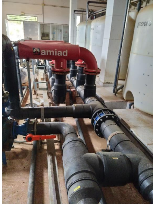
Figura 17: Equipos de filtrado de tipo malla conectados en paralelo y depósitos para fertirrigación (derecha de la fotografía)
