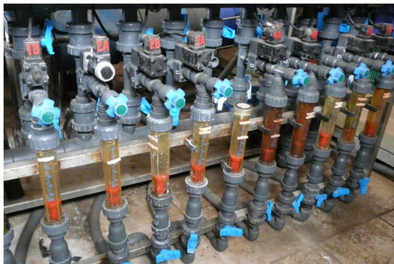
Figura 13: Sistema de fertirrigación adoptado en el cabezal
