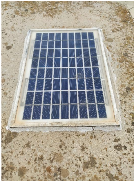
Figura 22: Célula fotovoltaica para abastecimiento energético de la central remota, que gestiona la apertura de las válvulas en función de la señal recibida del autómata del cabezal
