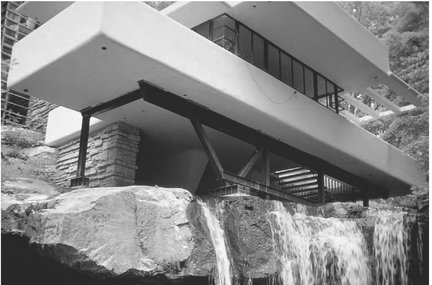
Imagen 4.06 Instalación de apuntalamiento provisional completada
