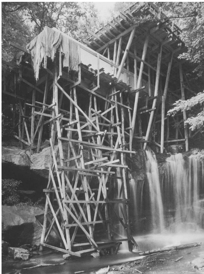
Imagen 4.01 Construcción de Casa de la Cascada, vista de andamios, 1936
