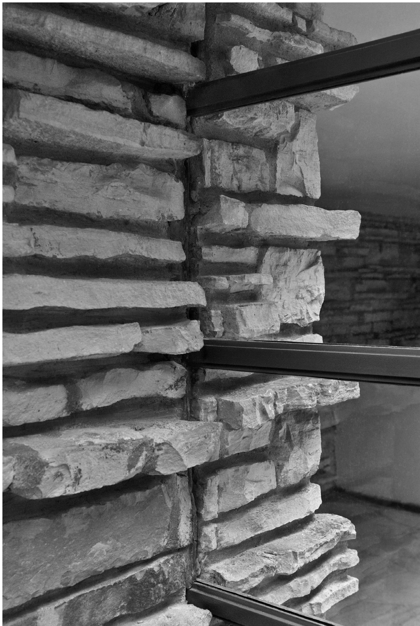
Imagen 3.09 Detalle de ventana con carpintería oculta en el muro de mampostería
