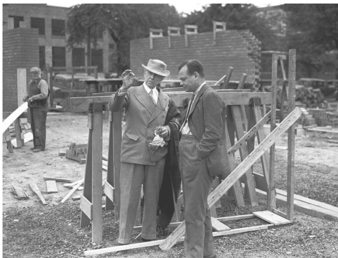
Imagen 2.02 Frank Lloyd Wright en plena construcción del edificio Johnson Wax, 1936
