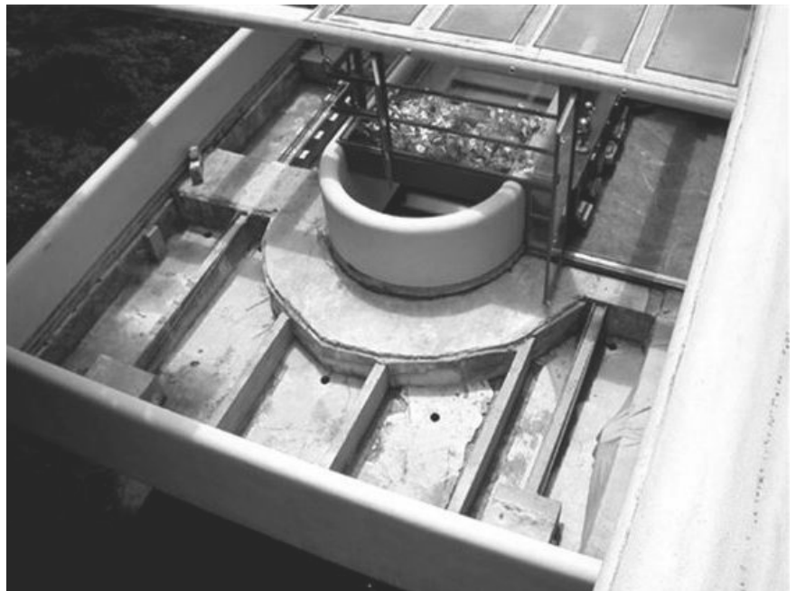
Imagen 4.05 Levantamiento temporal de pavimento durante las intervenciones de rehabilitación
