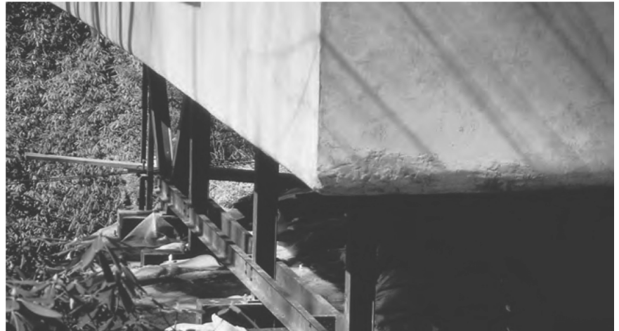
Imagen 4.04 Instalación de apuntalamiento provisional de las terrazas
