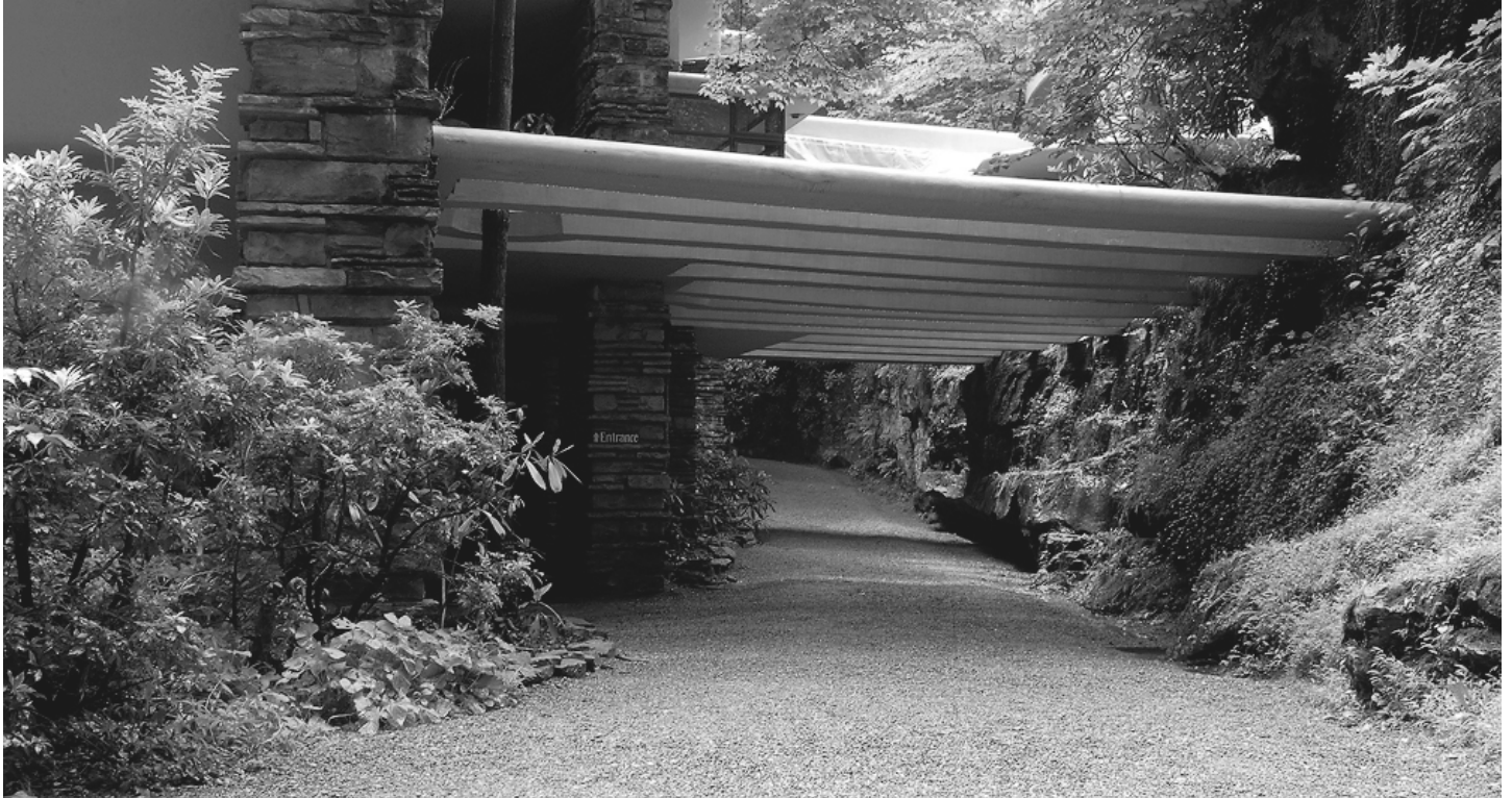
Imagen 3.05 Pérgola de vigas de hormigón armado en la fachada norte de la vivienda
