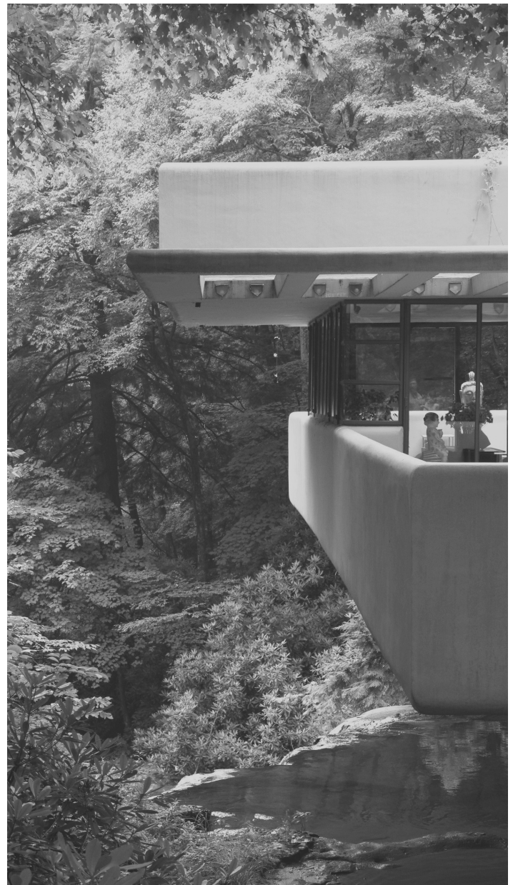
Imagen 3.03 Voladizo de la sala de estar sobre la cascada y el arroyo
