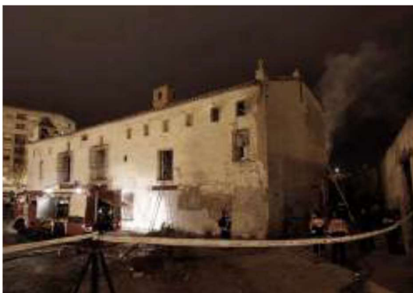
Imagen 4. Fotografía del incendio, 2011.
