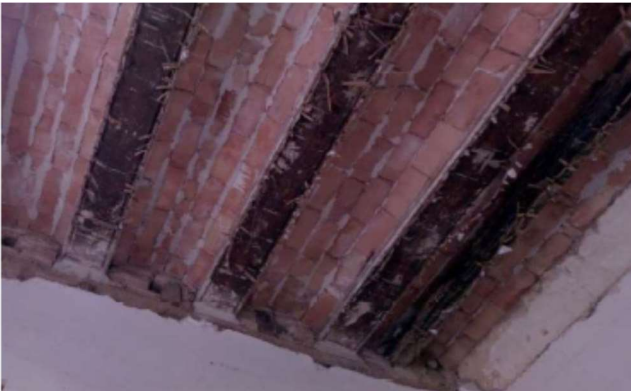
Imagen 16. Fotografía del forjado principal, 2020.
