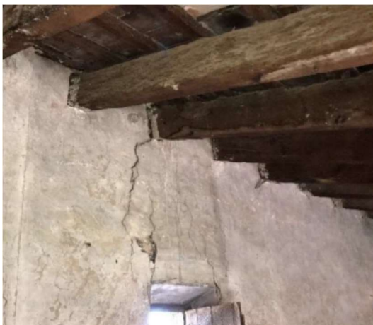
Imagen 28. Fotografía de la unión del forjado de cubierta con muro, 2020.
