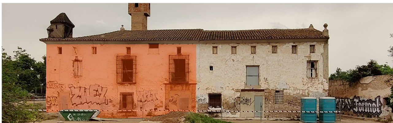
Imagen 7. Situación de los muros de fábrica de ladrillo en la fachada principal de la Alquería de Falcó, 2021.
