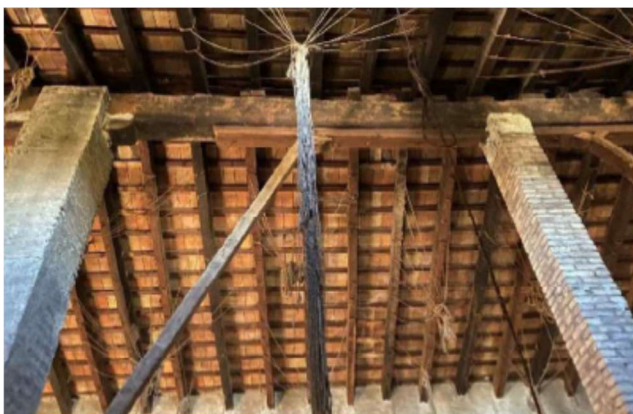
Imagen 32. Fotografía de la cubierta de la alquería de Falcó, 2020.
