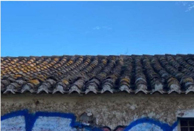
Imagen 20. Fotografía de la cubierta de la alquería de Falcó, 2020.
