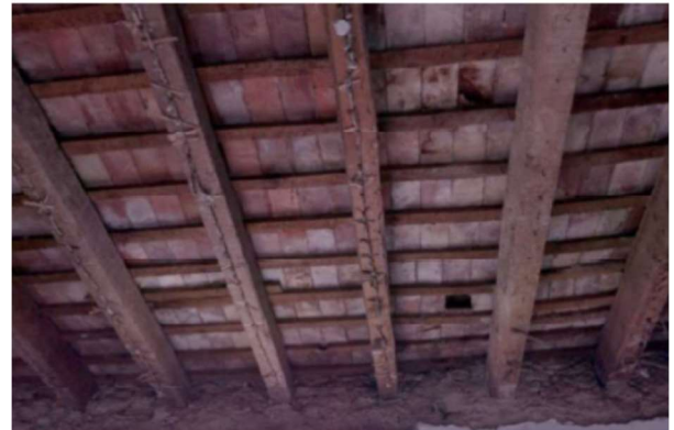
Imagen 17. Fotografía del forjado secundario, 2020.
