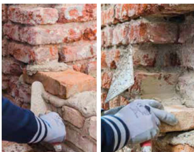
Imagen 36. Fotografía de la colocación del nuevo mortero y nuevas piezas.
