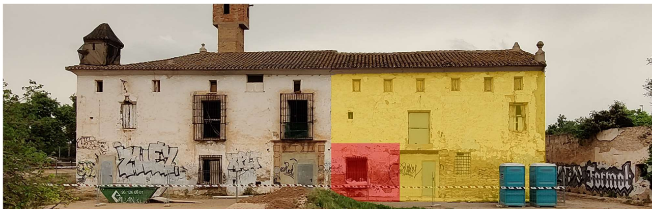
Imagen 10. Situación de los muros de tapia valenciana y de ladrillo encofrado en la fachada principal de la Alquería de Falcó, 2021.
