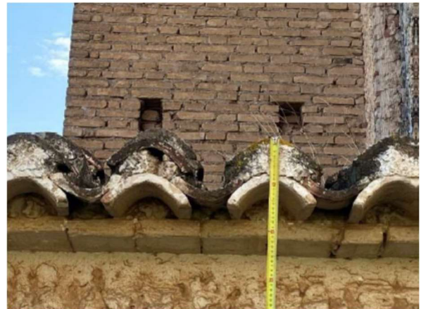
Imagen 21. Detalle de la cubierta de teja sobre rastreles de madera.
