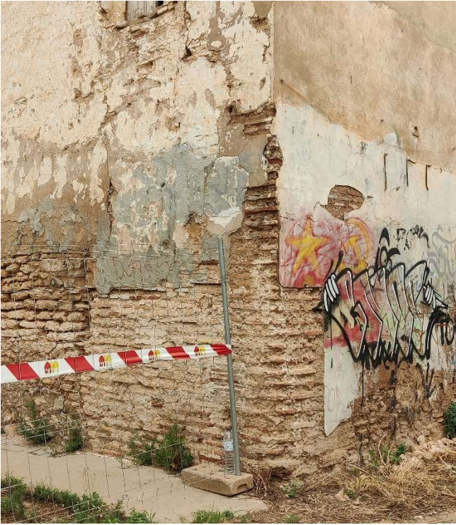
Imagen 13. Fotografía de la fachada norte en esquina con la este, 2021.
