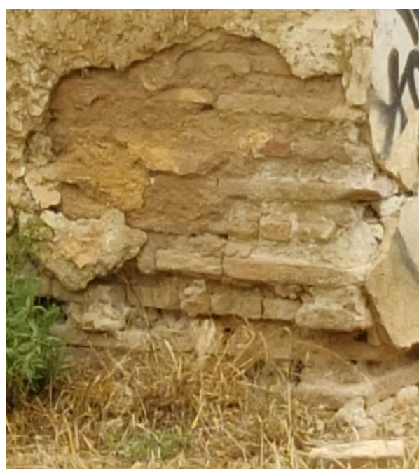
Imagen 9. Fachada oeste de la Alquería de Falcó, 2021.
