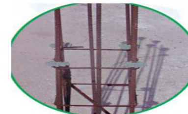
COLOCACIÓN EN PILARES
