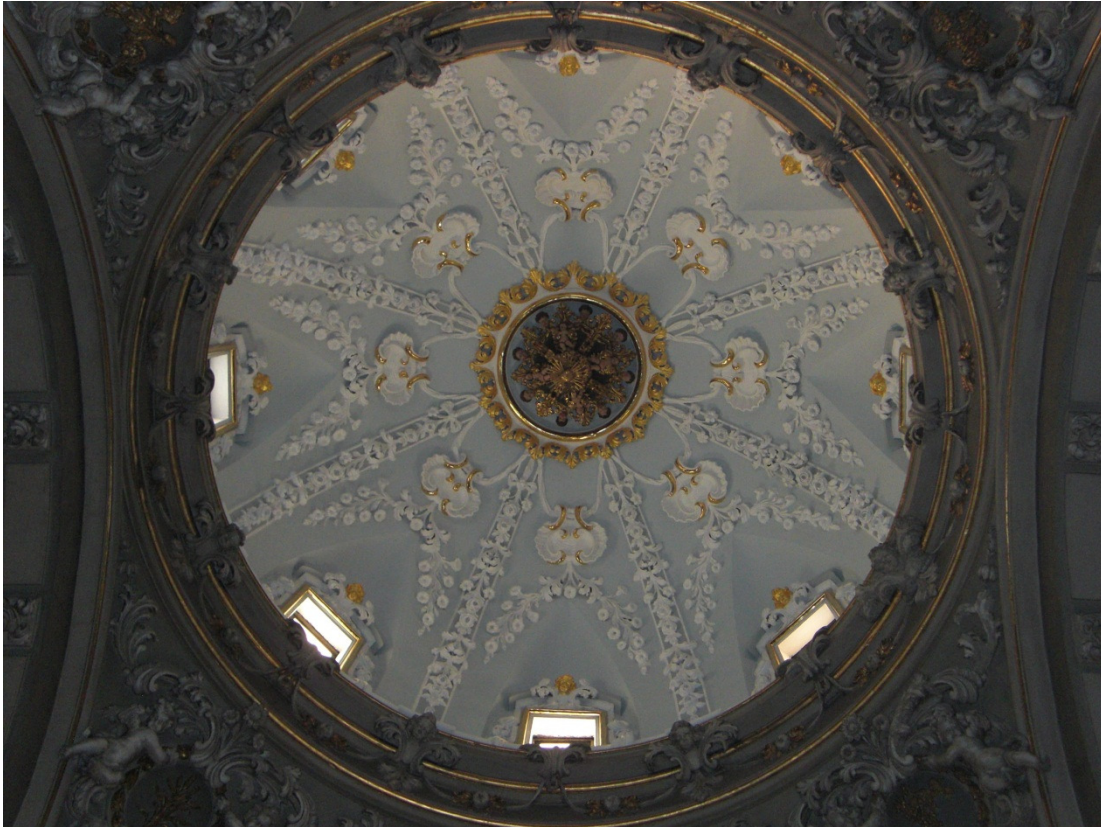
Foto 6. Foto interior de la cúpula en toda su magnitud.
