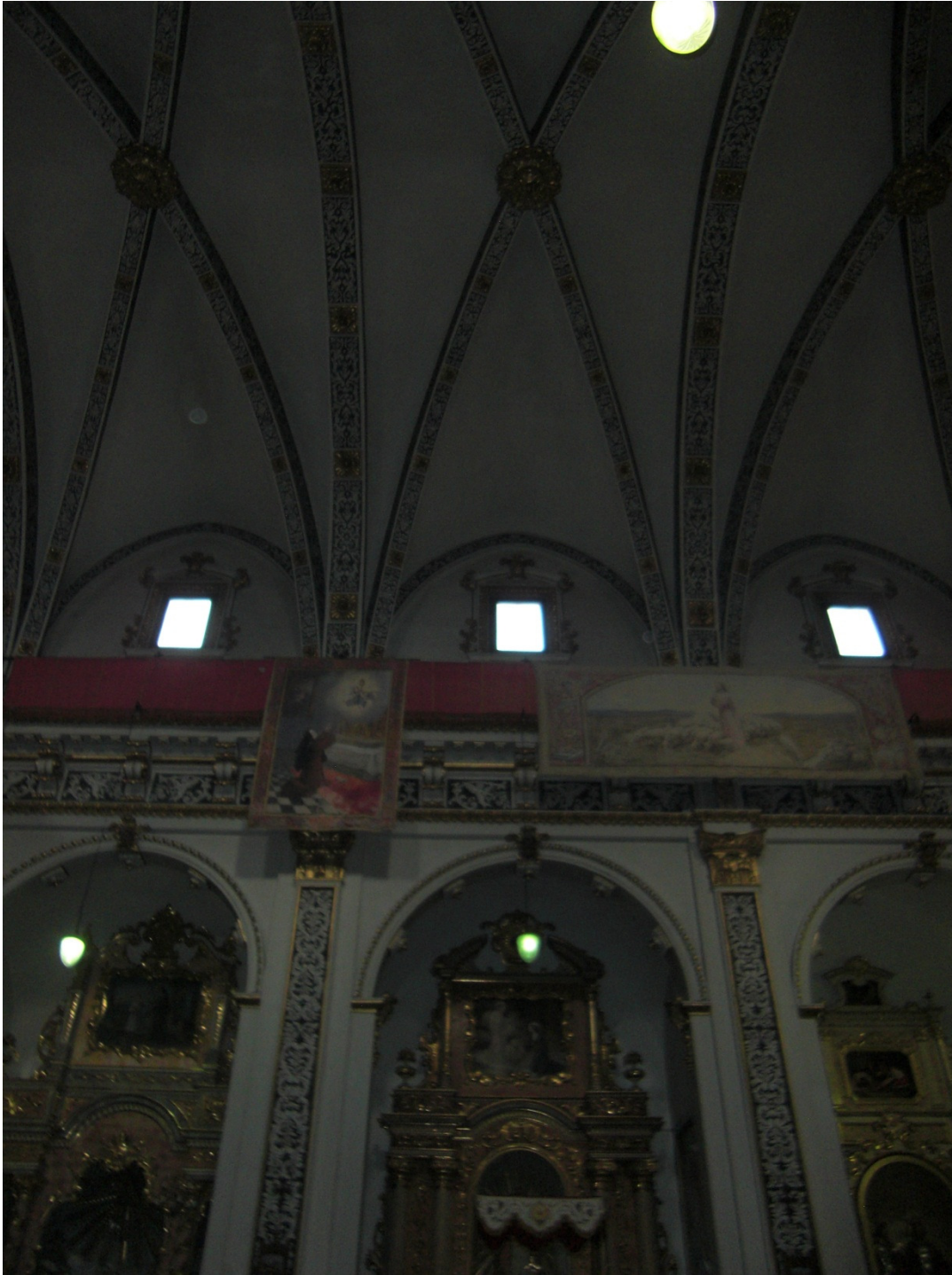
Foto 9. Bóvedas de crucería de la nave central.
