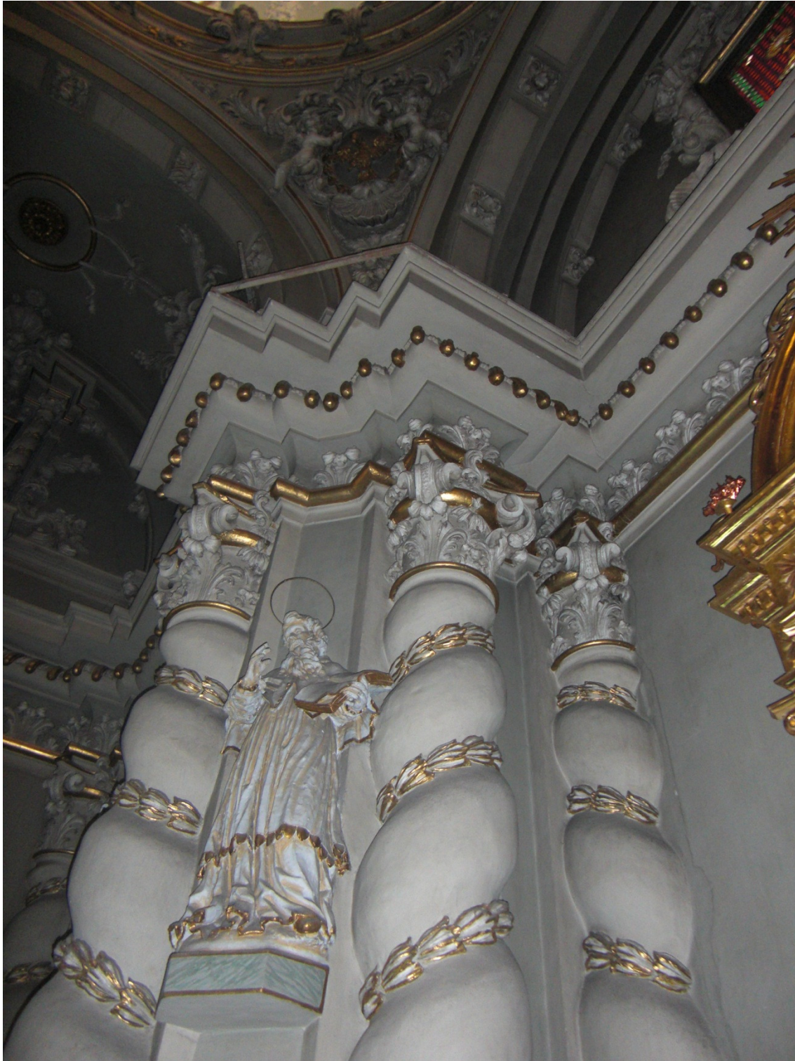
Foto 8. Columnas salomónicas que sustentan los arcos formeros.
